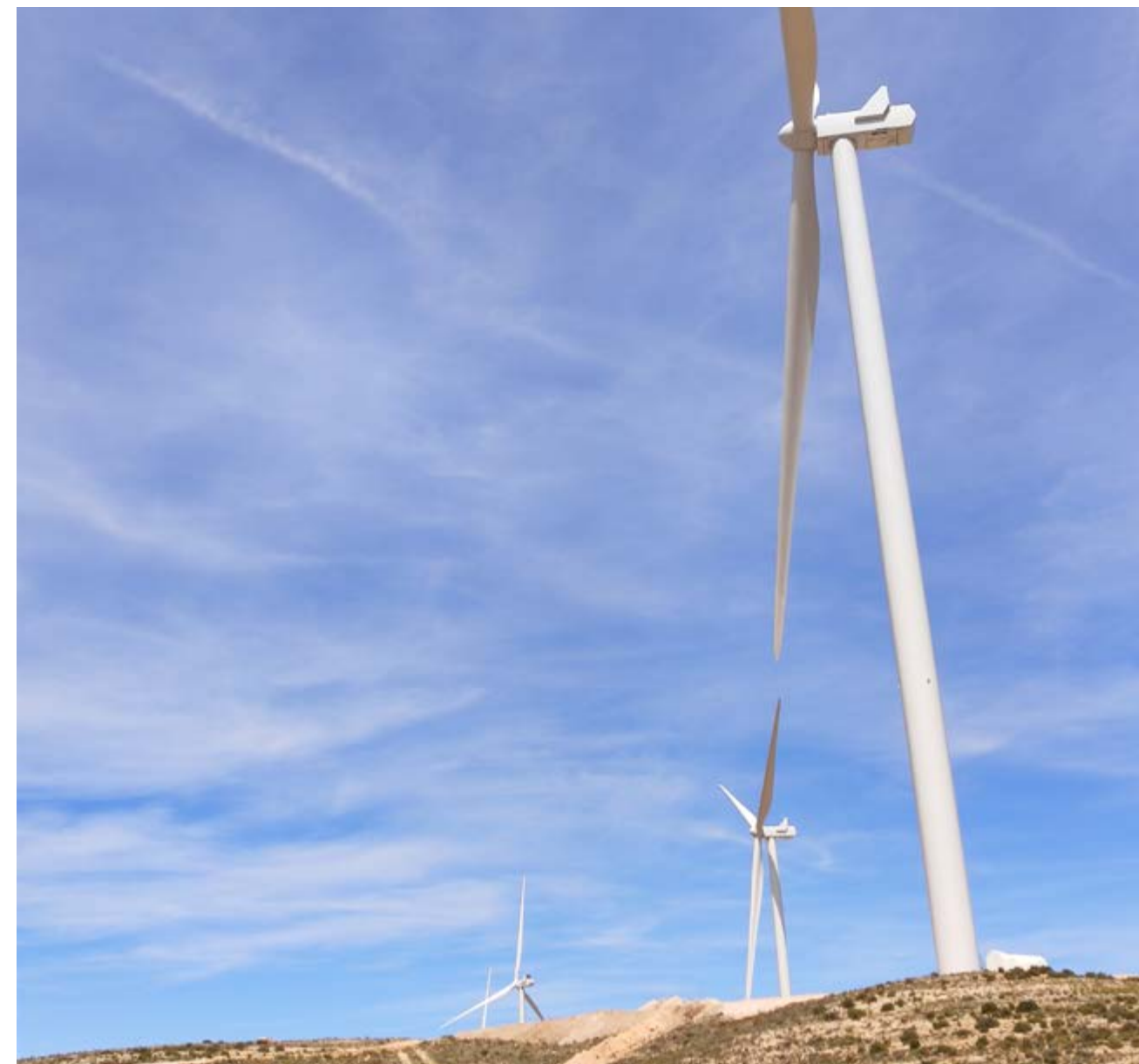
Parques eólicos para Enel Green Power em Teruel (Espanha)
