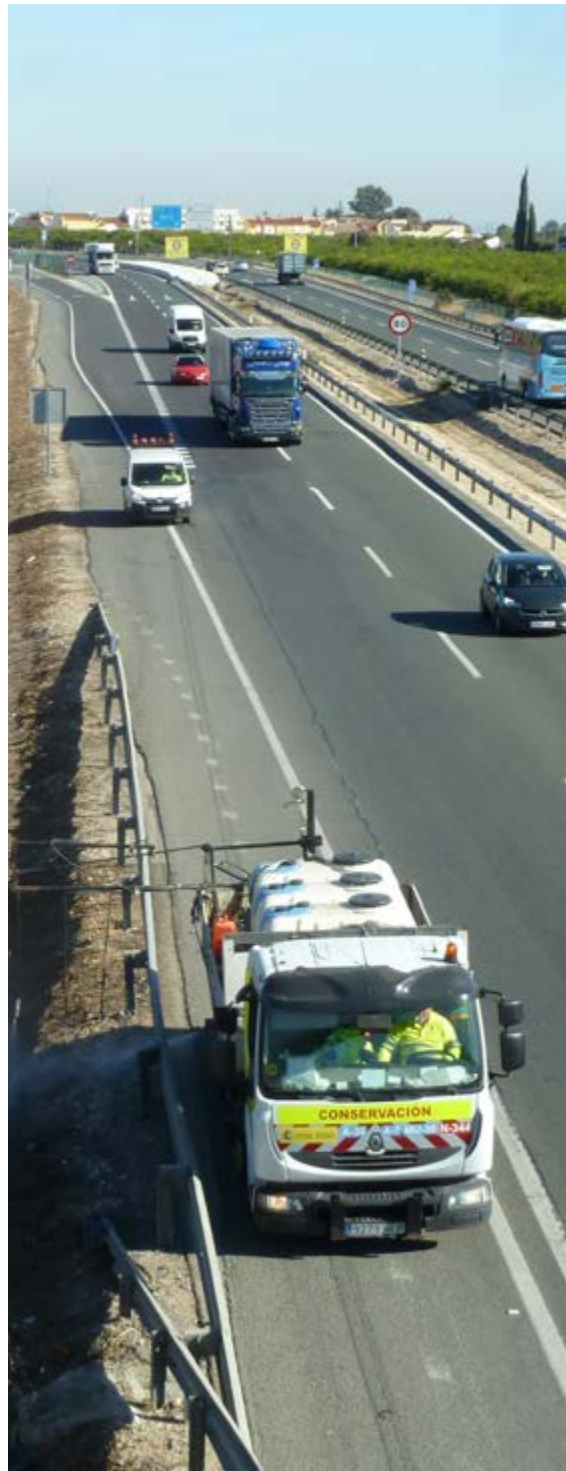
Estradas do Estado sector Múrcia (Espanha)
