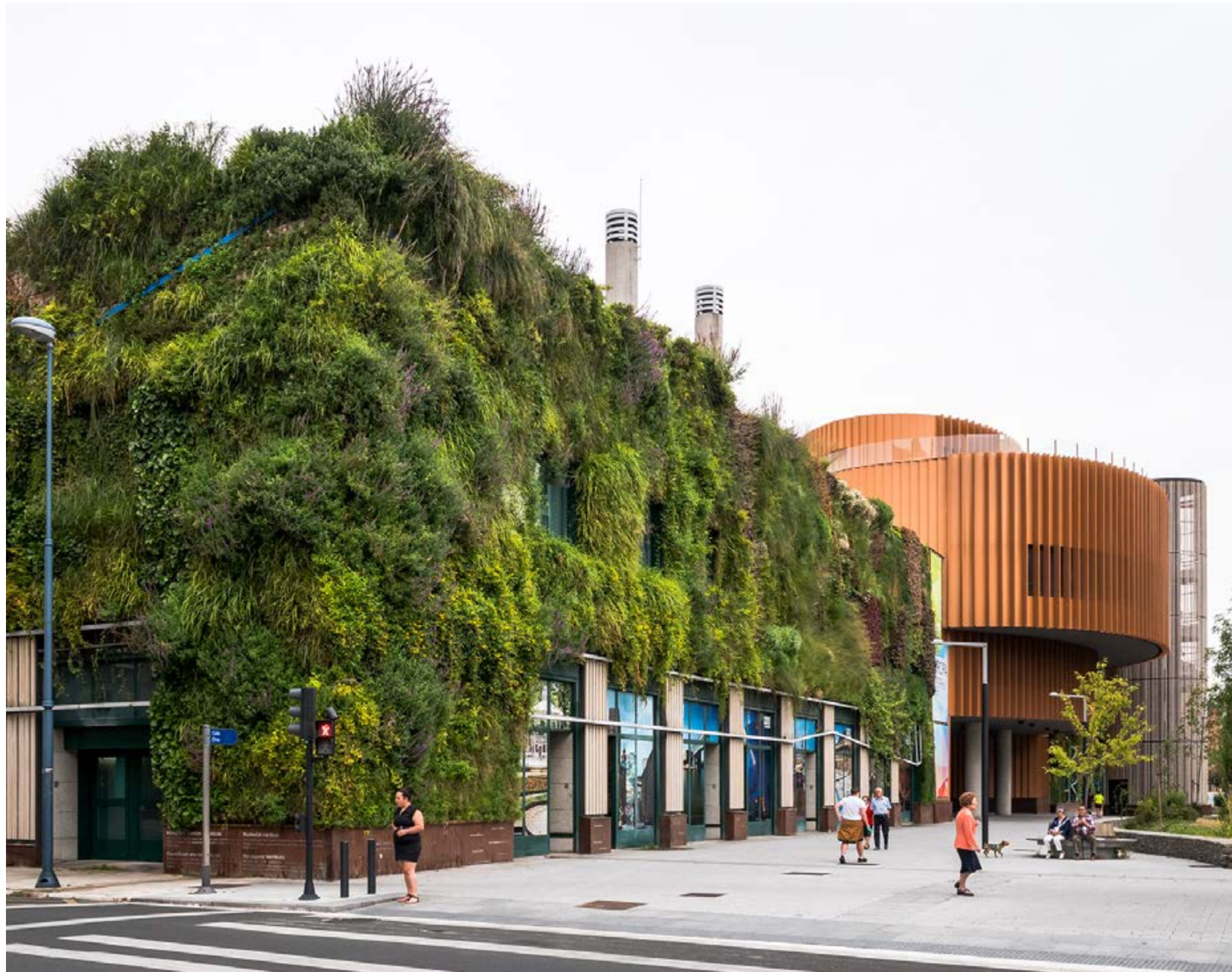
Gestão do fornecimento energético de eletricidade, otimização e manutenção com garantia total dos edifícios do Município de Vitoria. Palácio de Congressos Europa, Vitoria-Gasteiz, Álava
