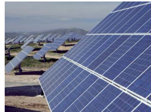
PV solar farm in Alcaudete, Jaen / 5,4 MW
