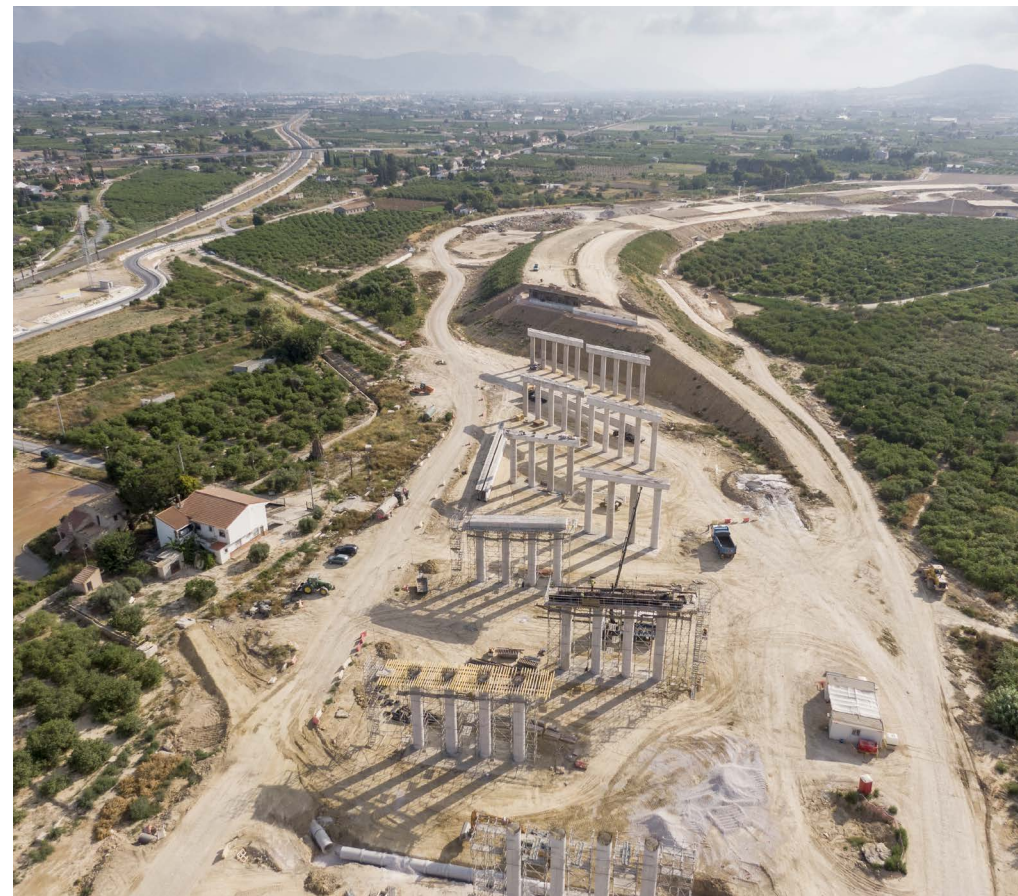
Tramo Autovía del Reguerón de la Circunvalación MU-30 de Murcia
