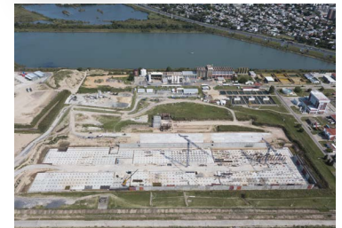
Ampliación de la Planta Potabilizadora General Belgrano, Buenos Aires
