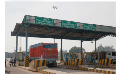
Tramo Raebarely - Banda de La Autopista NH-232, Uttar Pradesh
