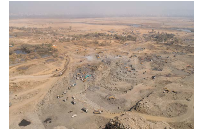
Tramo 4 del movimiento de tierras y estabiliza- ción de suelos del Nuevo Aeropuerto Navi Mumbai
