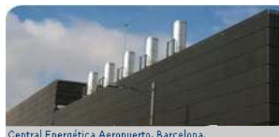
Central Energética Aeropuerto, Barcelona.
