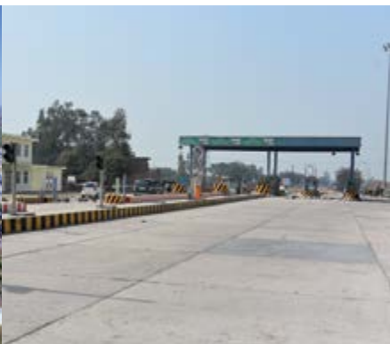
Tramo Raebarely - Faixa da Autoestrada NH-232, Estado de Uttar Pradesh (Índia).
