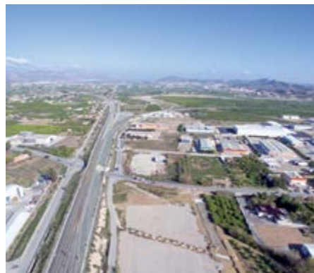
Tramo da Autoestrada de Reguerón da Circunvalação MU-30 de Múrcia (Espanha)
