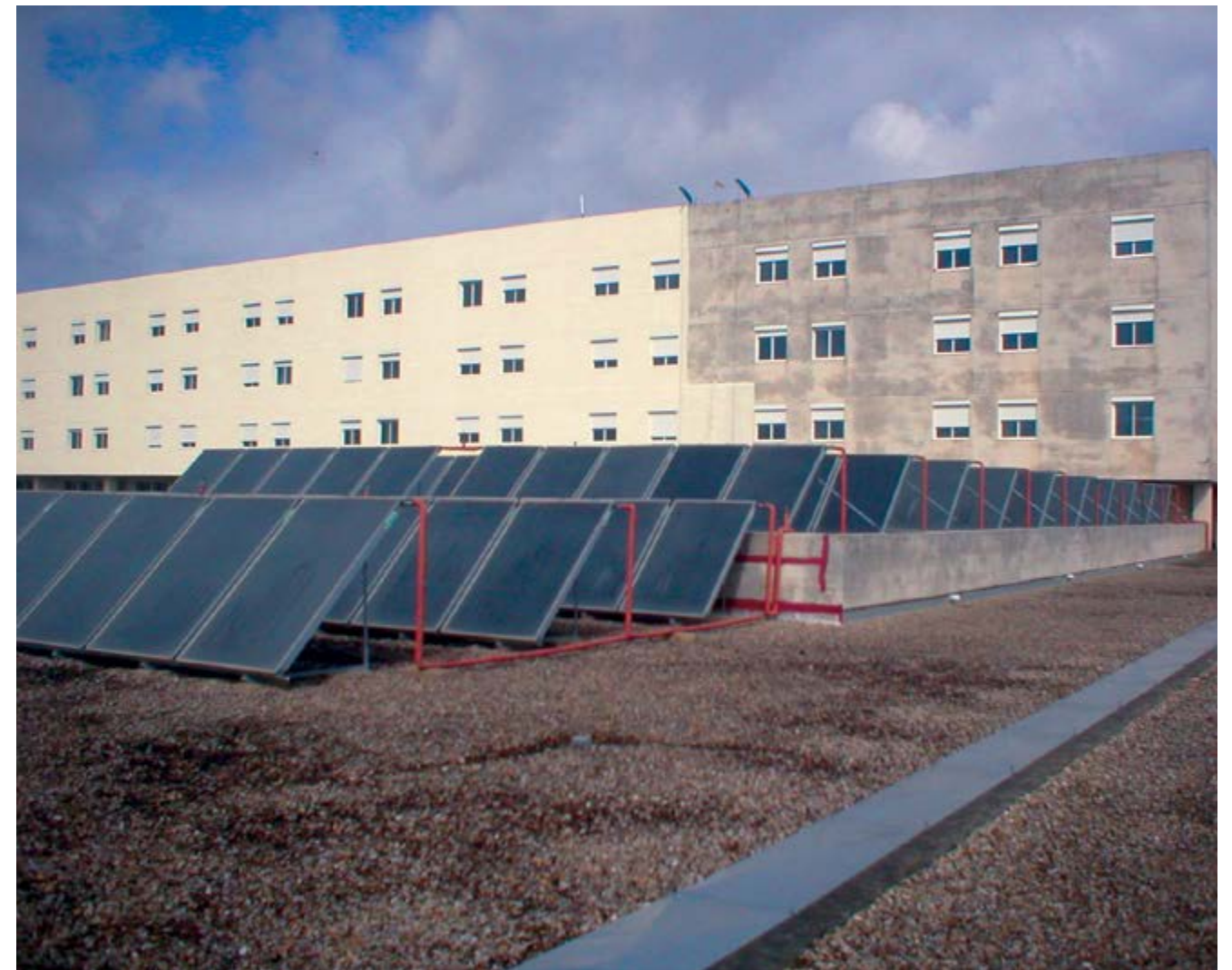
Hospital de Puerto Real, Cádiz (Espanha)
