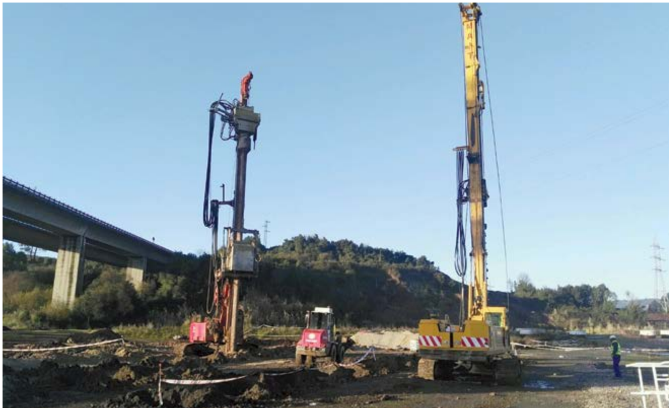
Acessos à zona de atividades logísticas e industriais das Astúrias (Zalia)
