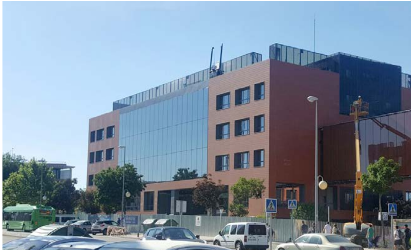
Ampliação da Sede Bankinter em Alcobendas, Madrid (Espanha)
