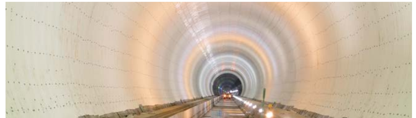
Túneis de Pajares (infraestruturas complementares Lote Sul). AVE Madrid - Astúrias (Espanha)
