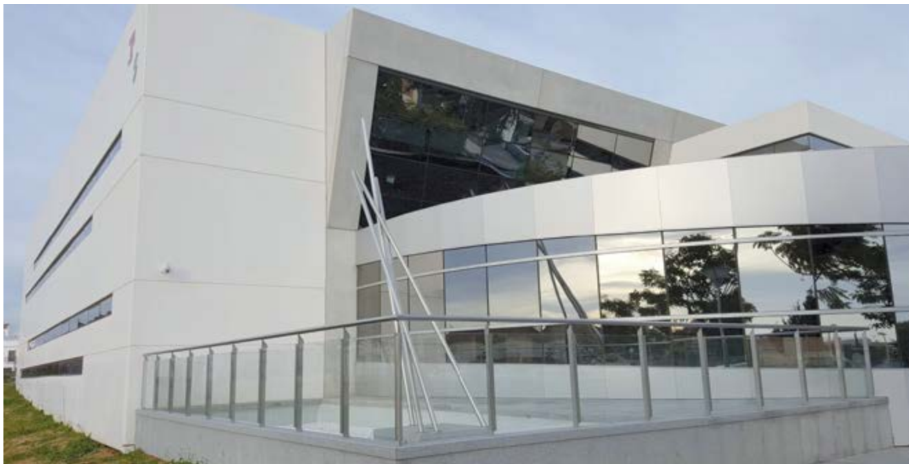
Edifício de escritórios da Tesouraria Geral da Segurança Social de Lepe, Huelva (Espanha)
