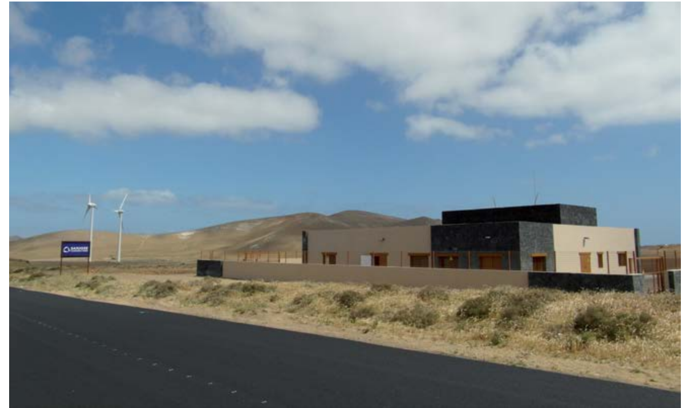
Subestação e Linha de Alta Tensão 20/66KV Consórcio da Água Callejones de Lanzarote (Espanha)
