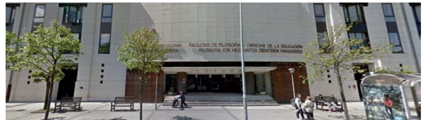
Reparações dos revestimentos exteriores de várias faculdades da Universidade do País Basco em San Sebastián (Espanha)
