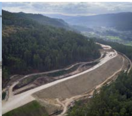
Tramo Vilaboa - A Ermida da futura Autoestrada A-57, Pontevedra (Espanha)
