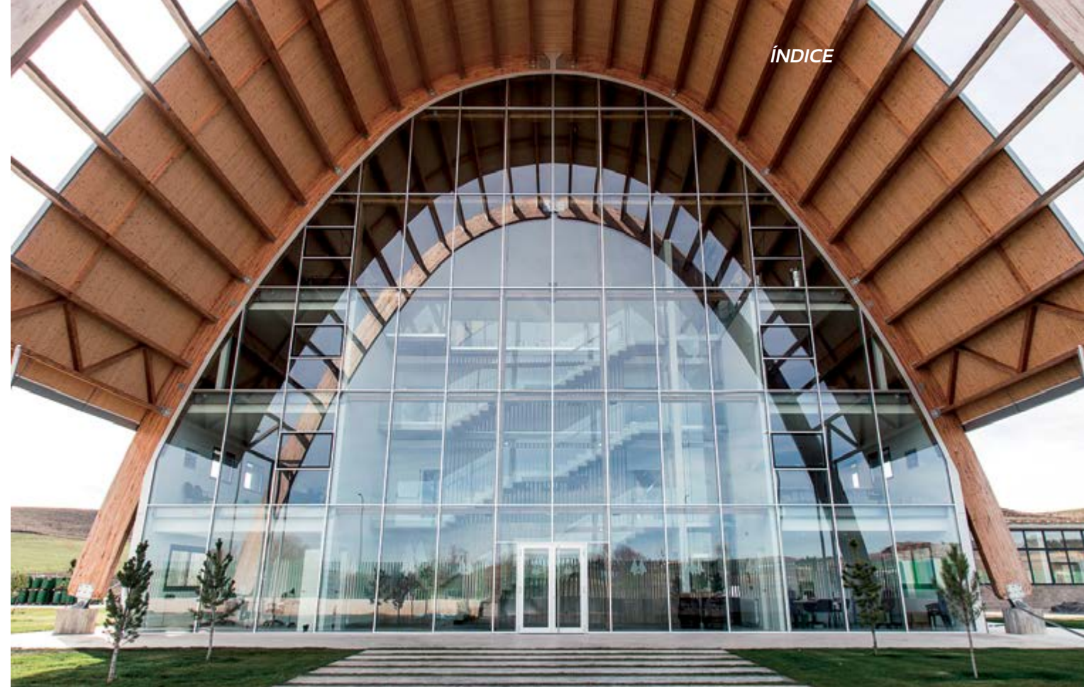
Construção integral da Fábrica de destilação de resina em Almazan, Soria
