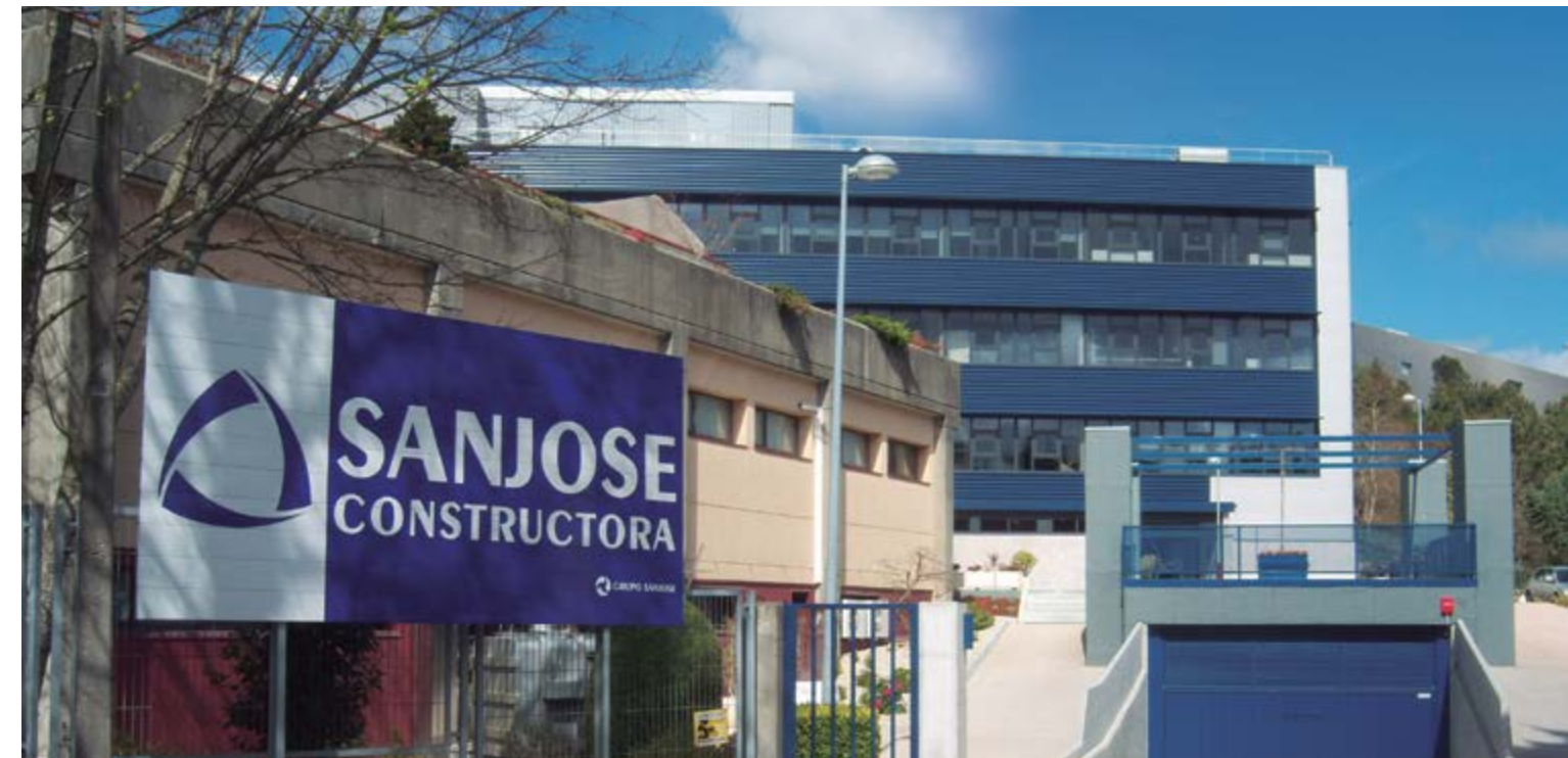
Construção integral do Centro de Tecnologias Avançadas de Investigação para a indústria Marinha e Alimentar de Vigo (Espanha)
