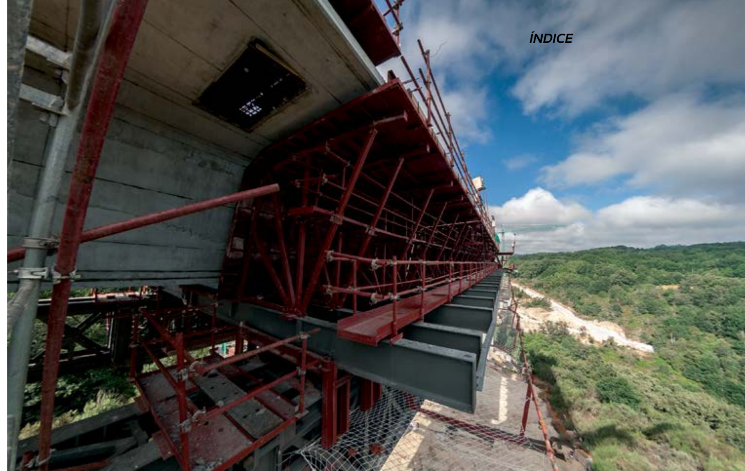
Tramo Miamán - Ponte Ambía (Ourense). AVE Madrid - Galiza
