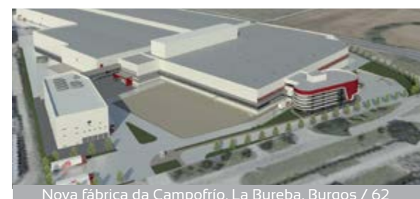
Nova fábrica da Campofrío, La Bureba, Burgos / 62
