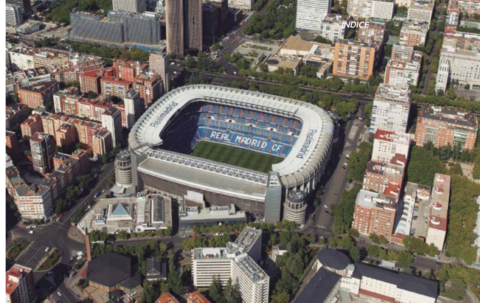
Estadio Santiago Bernabéu, Madrid (Manutenção do Património do Real Madrid) (Espanha)
