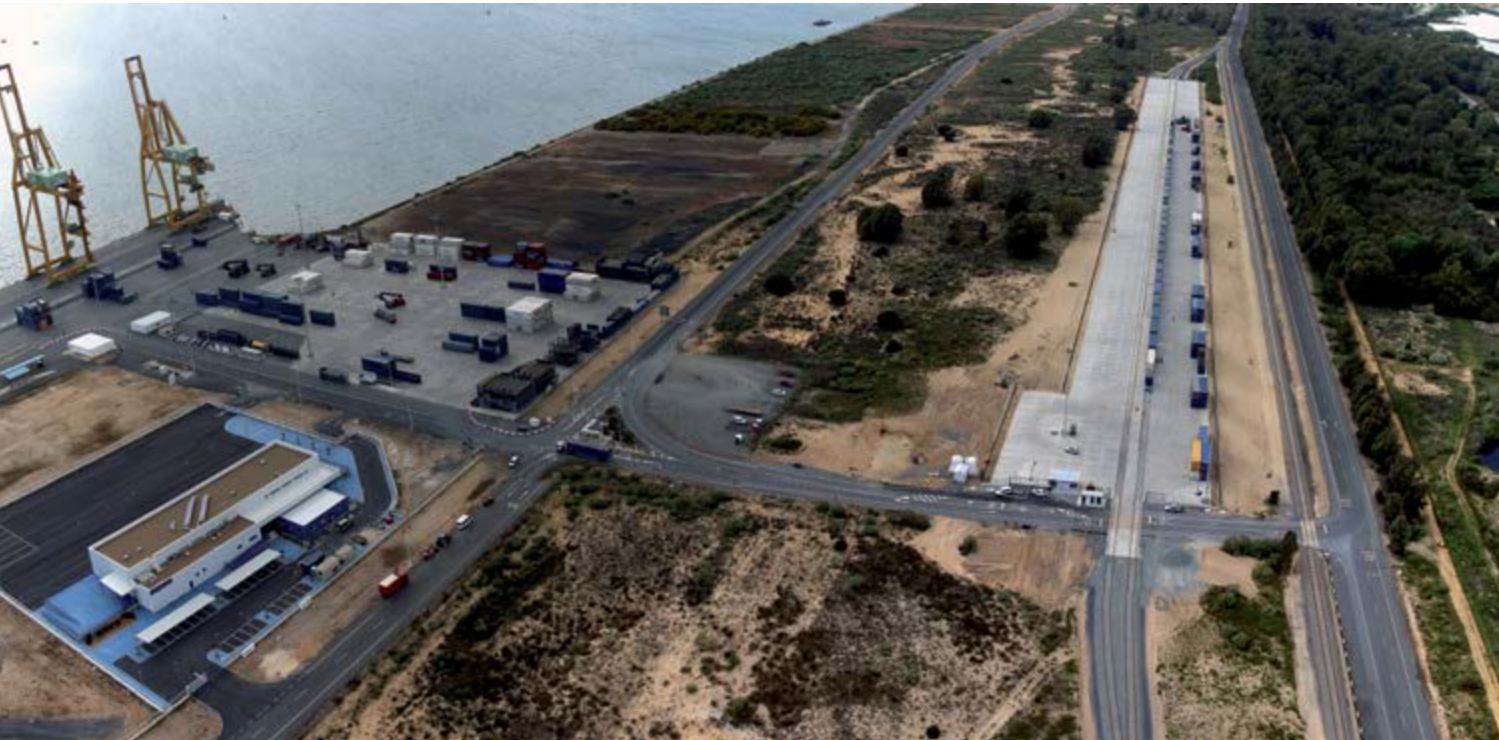
Terminal Ferroviário Muelle Sur em Huelva (Espanha)
