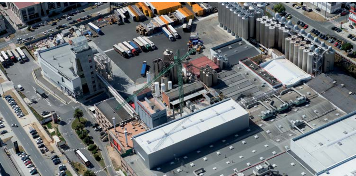
Ampliação e remodelação da fábrica da Estrella Galicia na Corunha (Espanha)
