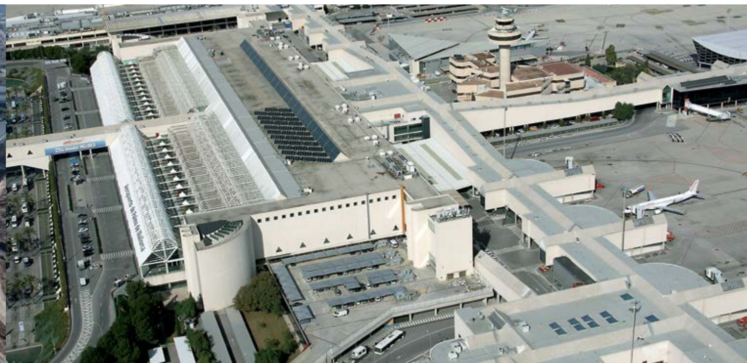
Nova impermeabilização do edifício terminal e módulos do Aeroporto de Palma de Maiorca (Espanha)
