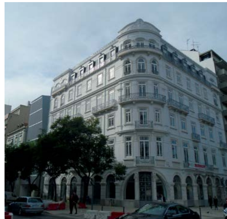
Edifício República 37, Lisboa (Portugal)
