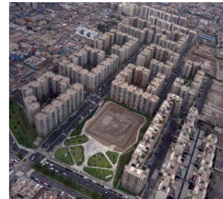
Condomínio Parques de la Huaca, Lima (Peru). Engenharia e projeto: GSJ Solutions / Execução: SANJOSE Constructora
