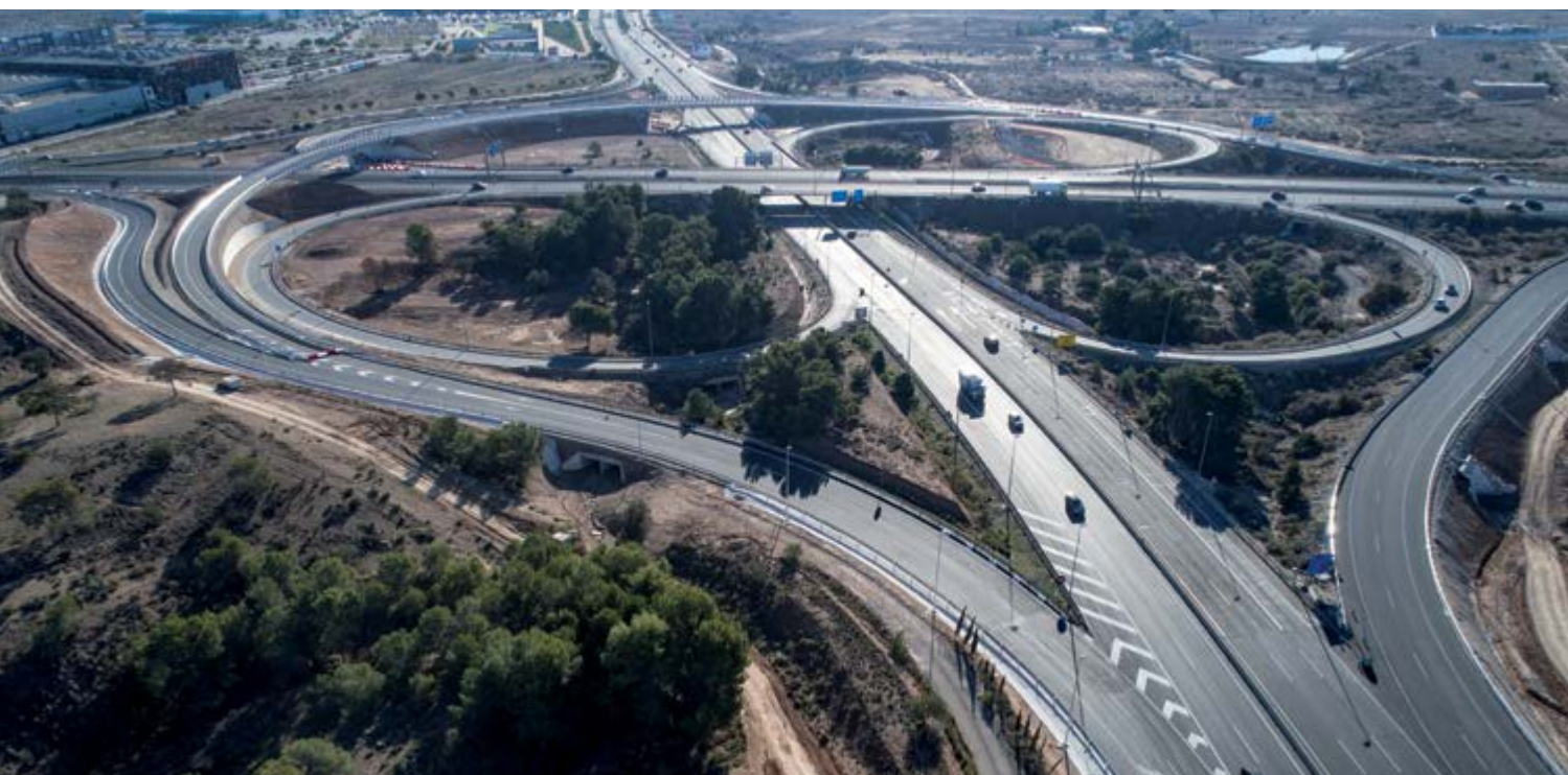
Modificação da ligação das autoestradas A-30 e A-7 e prolongamento da faixa adicional para circulação de veículos lentos na rampa da A-30, Múrcia (Espanha)
