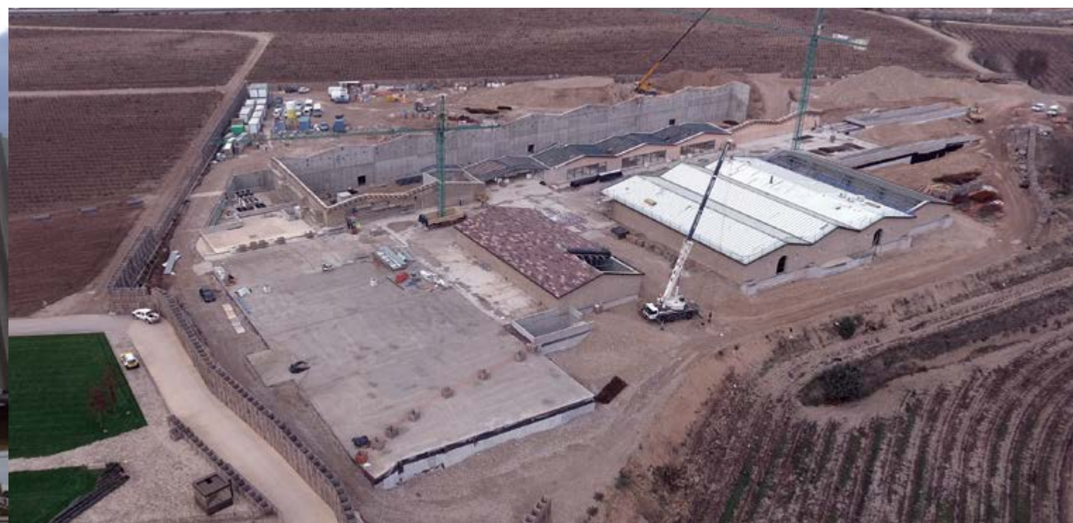
Ampliação da Adega Marqués de Murrieta em Logroño (Espanha)
