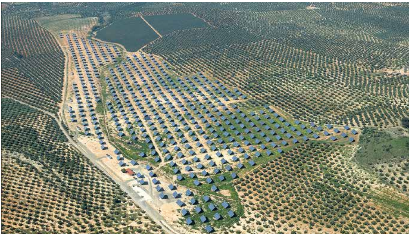
Central fotovoltaica em Alcaudete, Jaén (5,4 MW). Engenharia e projeto GSJ Solutions / Execução: SANJOSE Constructora
