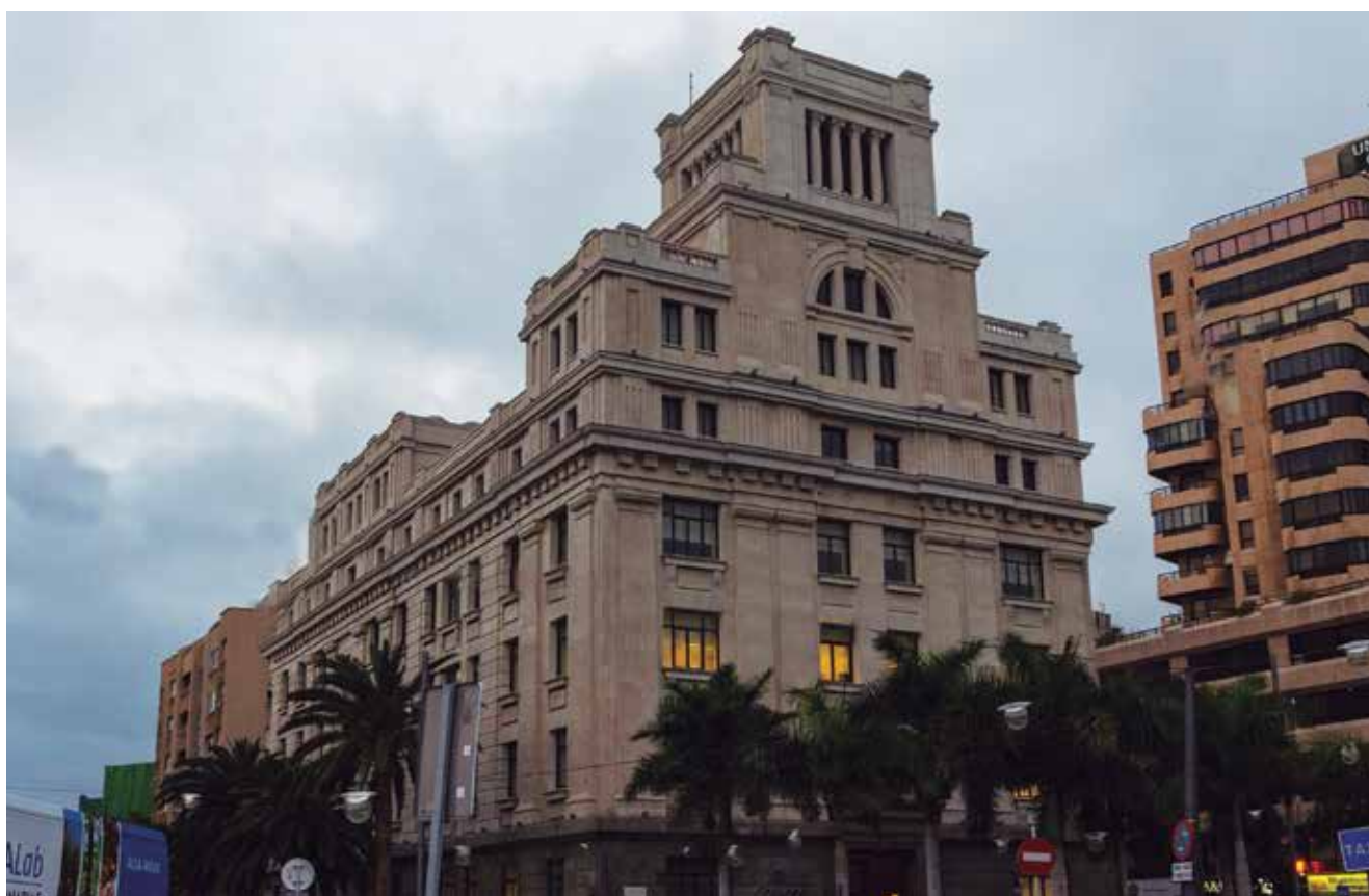
Reabilitação do Edifício Principal dos Correios e Telégrafos de Las Palmas de Gran Canaria
