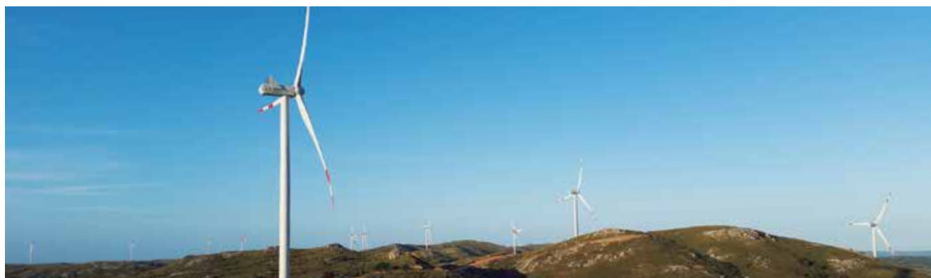
Parques eólicos no Uruguai (90MW). Engenharia e projeto GSJ Solutions / Execução: SANJOSE Constructora
