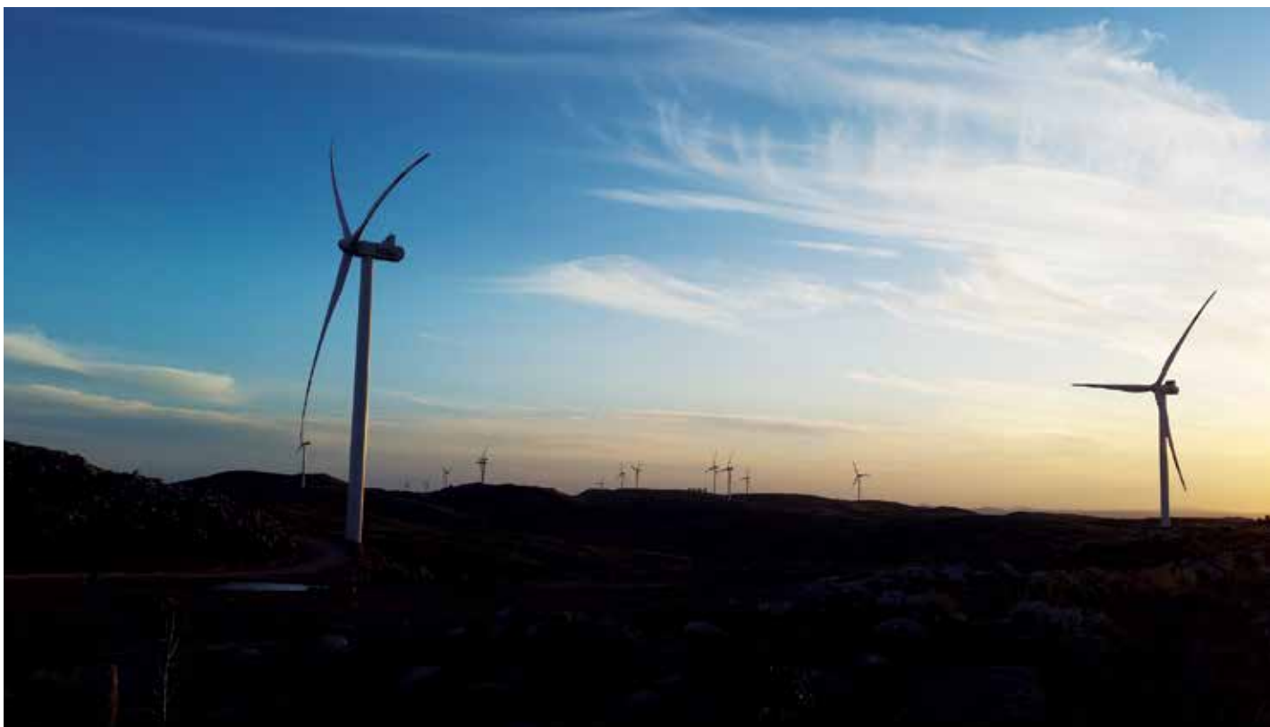
Parques eólicos no Uruguai (90 MW). Engenharia e projeto GSJ Solutions / Execução: SANJOSE Constructora
