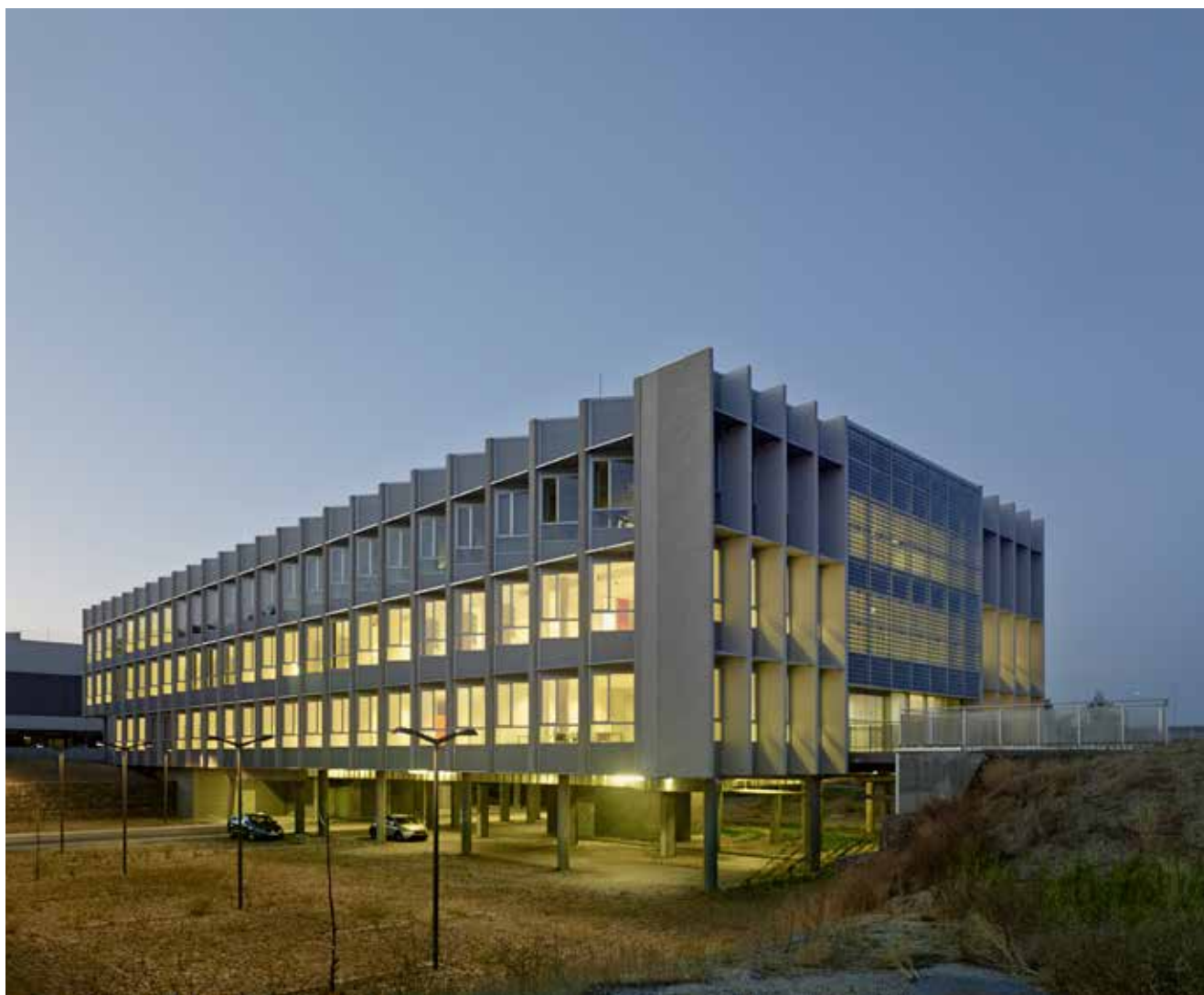
Edifício LUCIA da Universidade de Valladolid (Espanha). Certificado com 98 pontos por Leed Platinum como o edifício mais sustentável da Europa e o segundo de todo o Mundo
