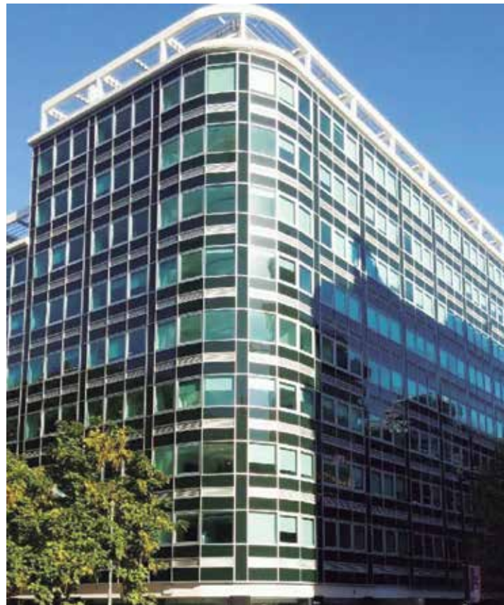
Reabilitação de edifício de escritórios para o Fundo de Pensões do Banco de Portugal, Lisboa (Portugal)
