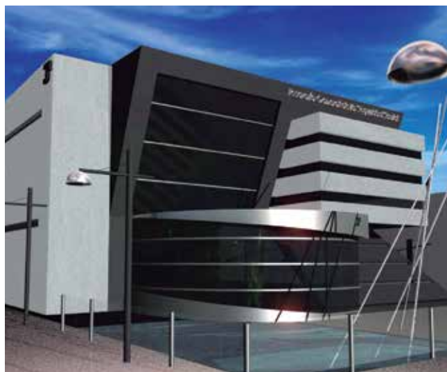
Edifício de escritórios da Tesouraria Geral da Segurança Social em Lepe, Huelva.
