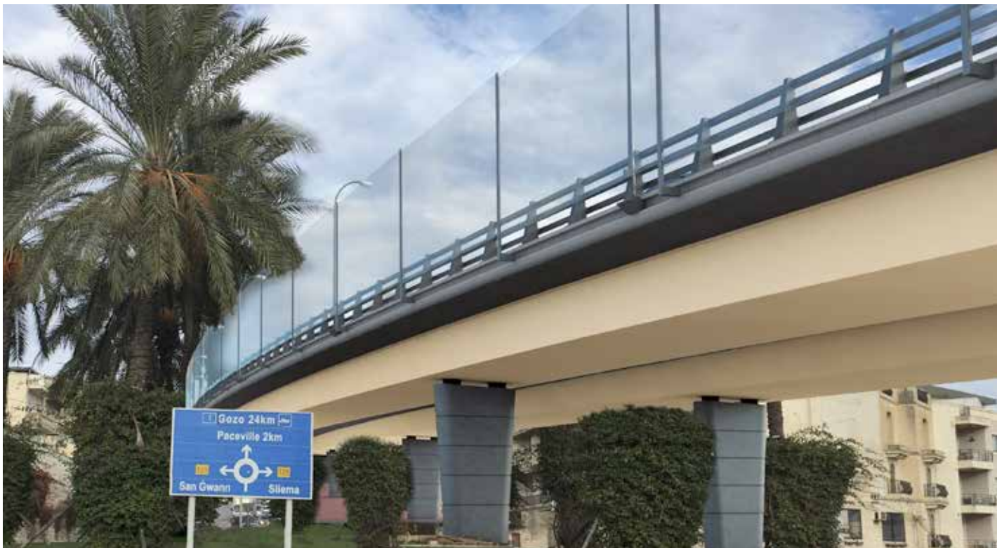
Viaduto no nó da EA15 em Kappara, Malta. Engenharia e projeto GSJ Solutions / Execução: SANJOSE Constructora
