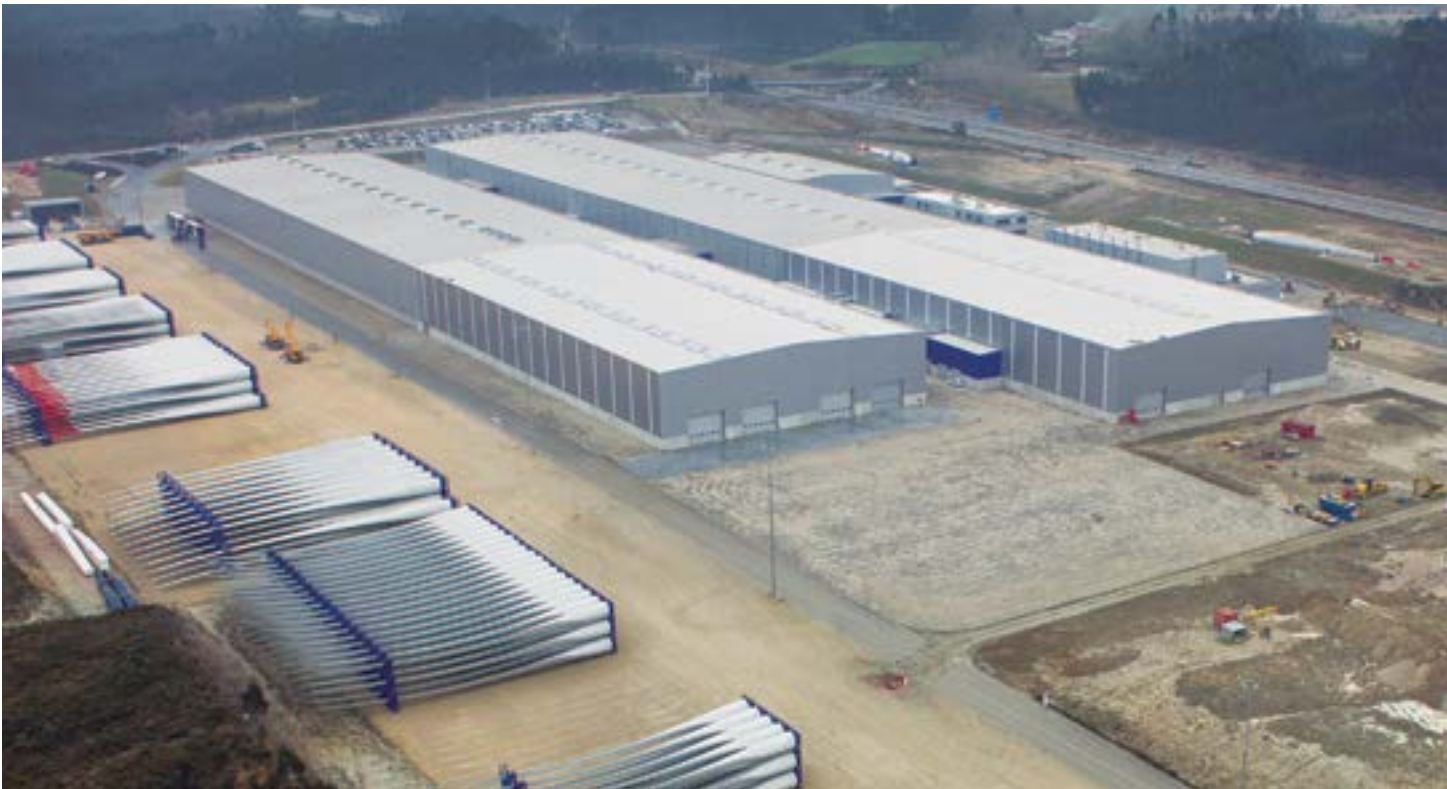
Ampliação da Unidade Industrial Ria Blades em Vagos, Aveiro (Portugal)
