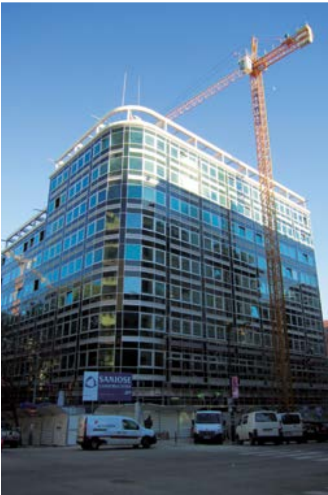
■ Reabilitação de edifício de escritórios na Rua Castilho 24, Lisboa (Portugal)
