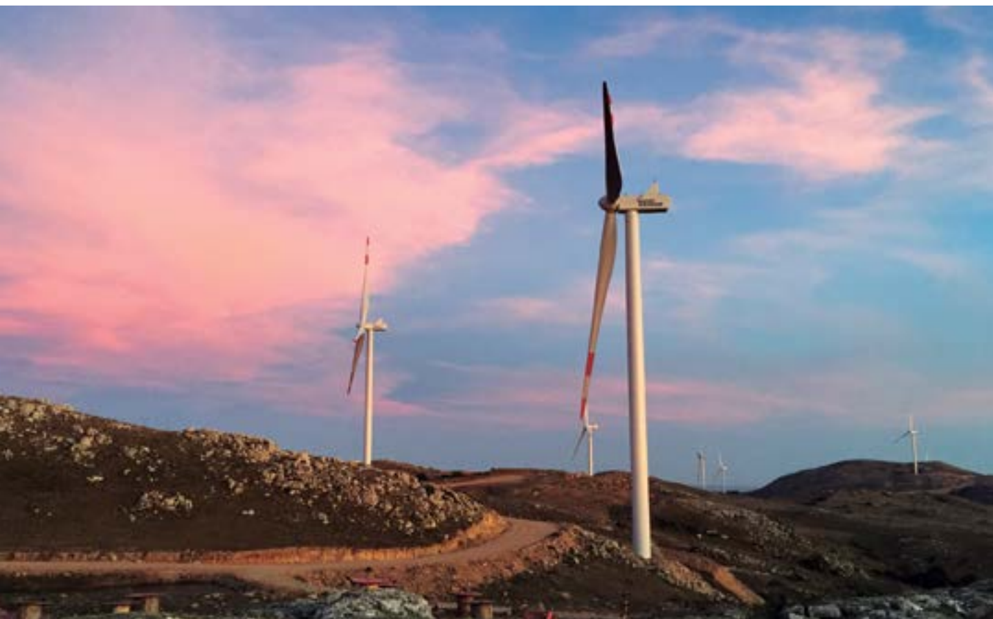
■ Promoção e desenvolvimento de dois parques eólicos (90 MW) no Uruguai. Engenharia e Projeto GSJ Solutions / Execução SANJOSE Constructora
