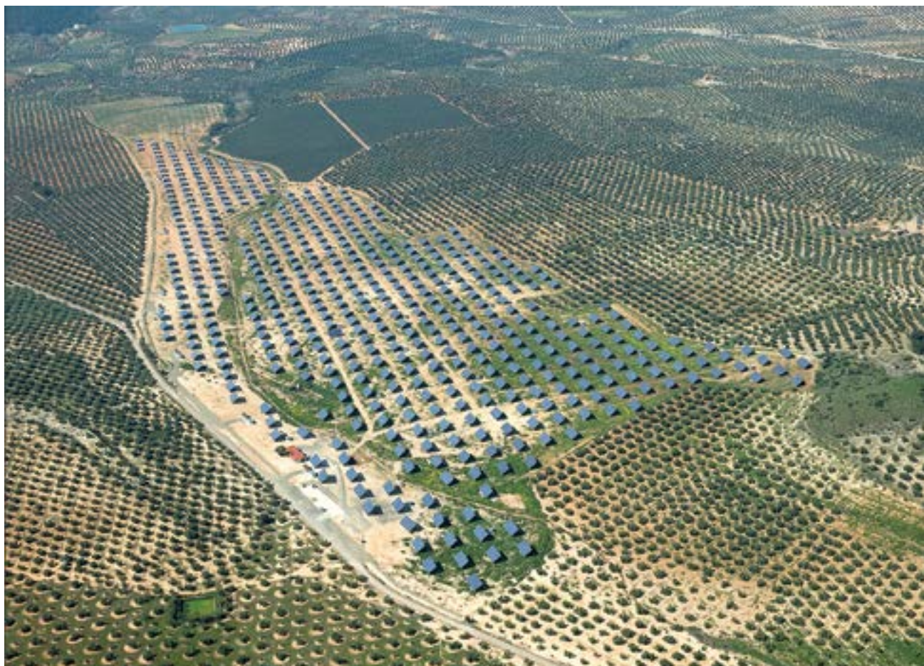
■ Central fotovoltaica em Alcaudete, Jaén / 5,4 MW
