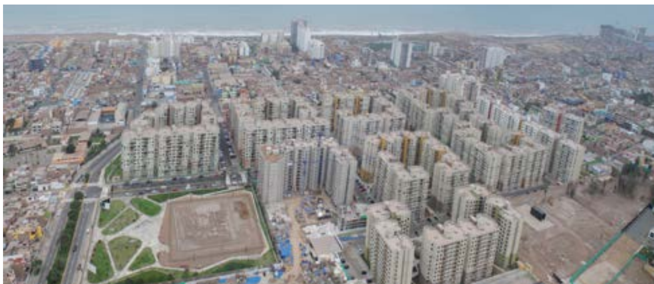
Condomínio Parques de la Huaca, Lima (Peru). Engenharia e Projeto GSJ Solutions / Execução SANJOSE Constructora
