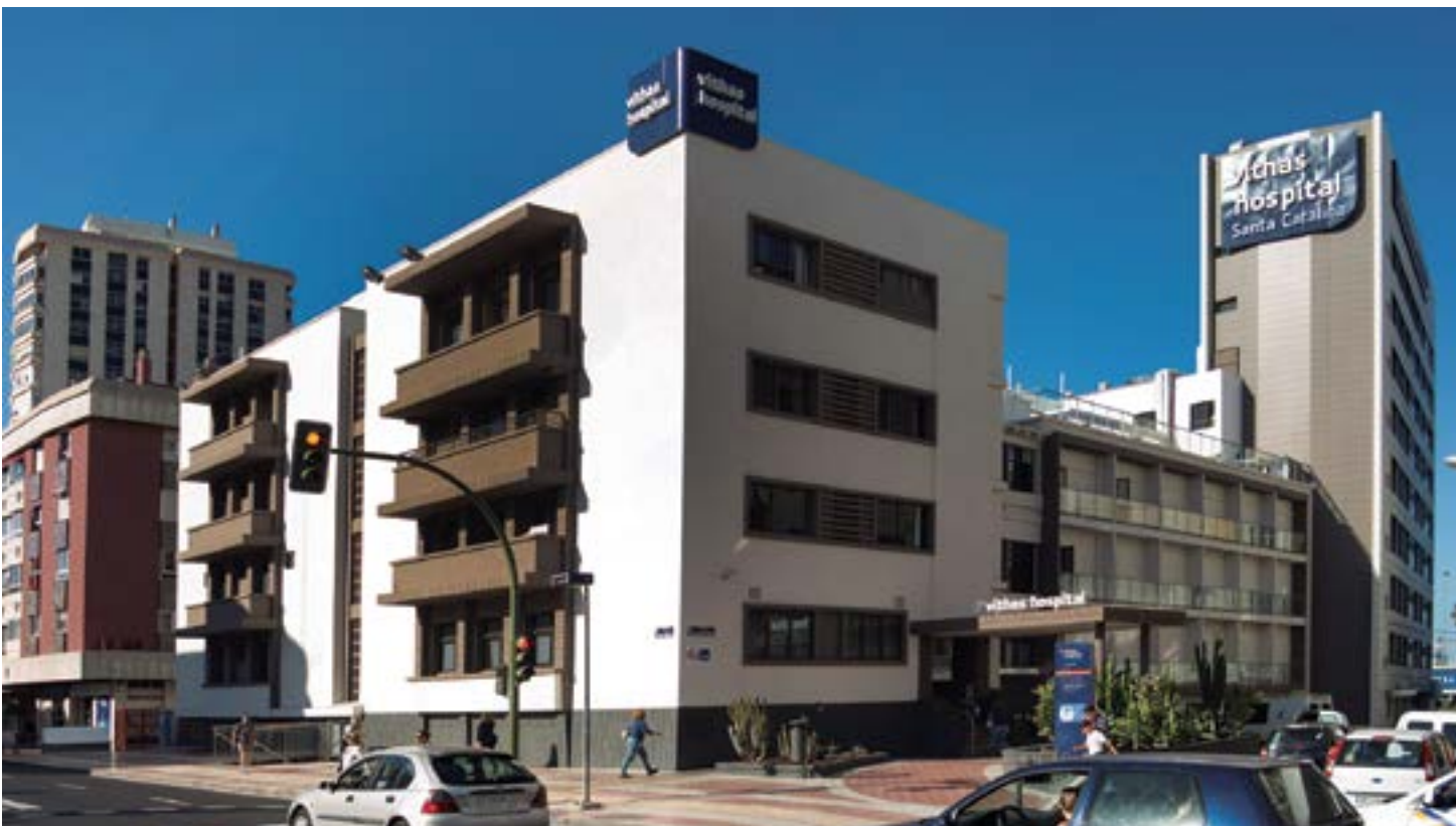
Reforma integral do Hospital Santa Catalina em Las Palmas da Gran Canaria
