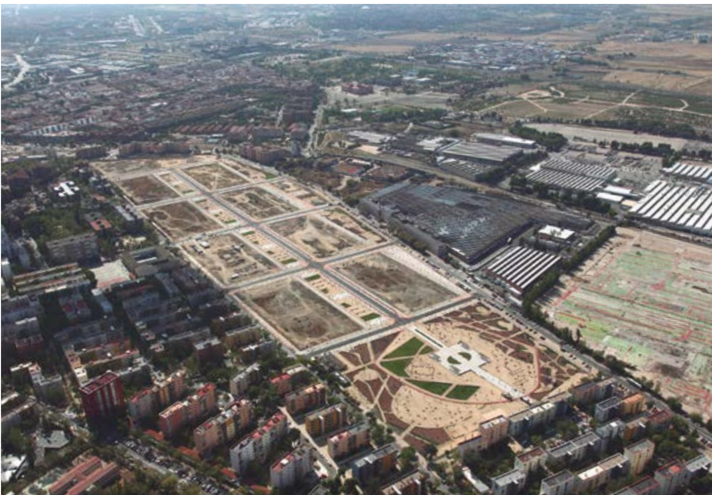
■ Urbanização Parque Central dos Engenheiros de Villaverde (273.794 m 2 ), Madrid.
