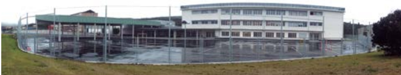
■ Escola Secundária Badaia, estacionamento de autocarros e acessos em Nanclares de Oca, Alava
