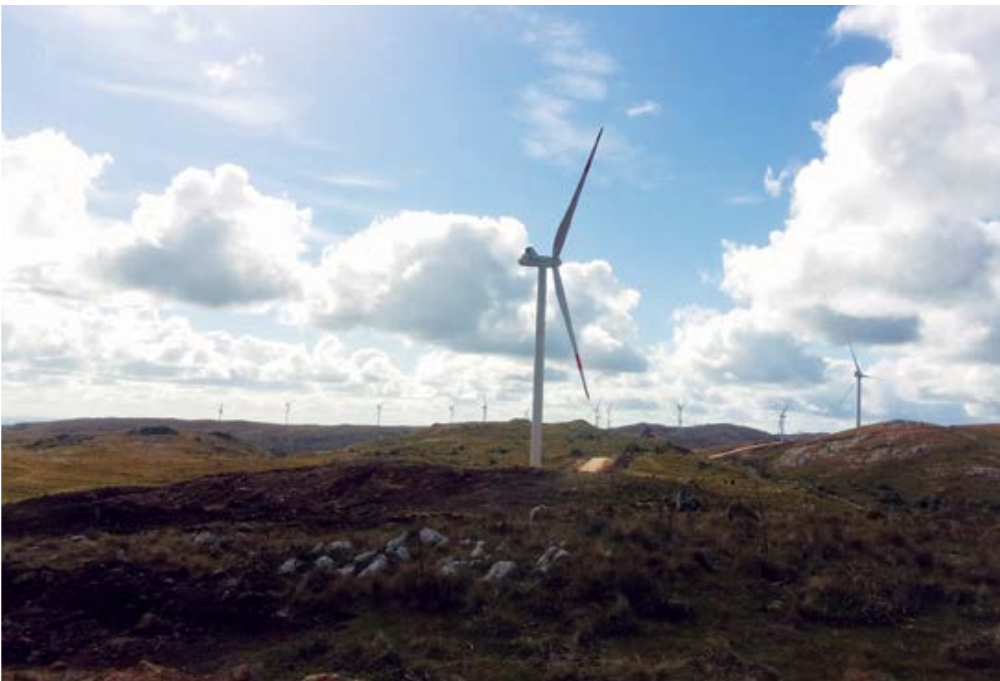
■ Parques eólicos no Uruguai (90 MW). Engenharia e projeto GSJ Solutions / Execução SANJOSE Constructora
