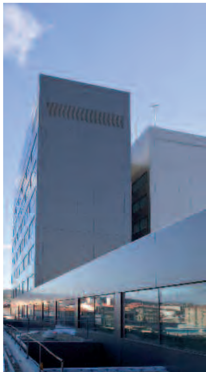
Edifício Administrativo da Xunta em Campolongo, Pontevedra.
