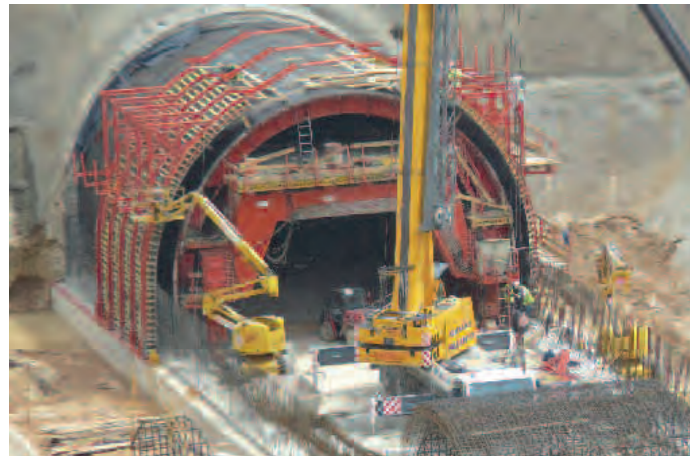
Acesso ferroviário de Alta Velocidade Madrid-Valencia.
