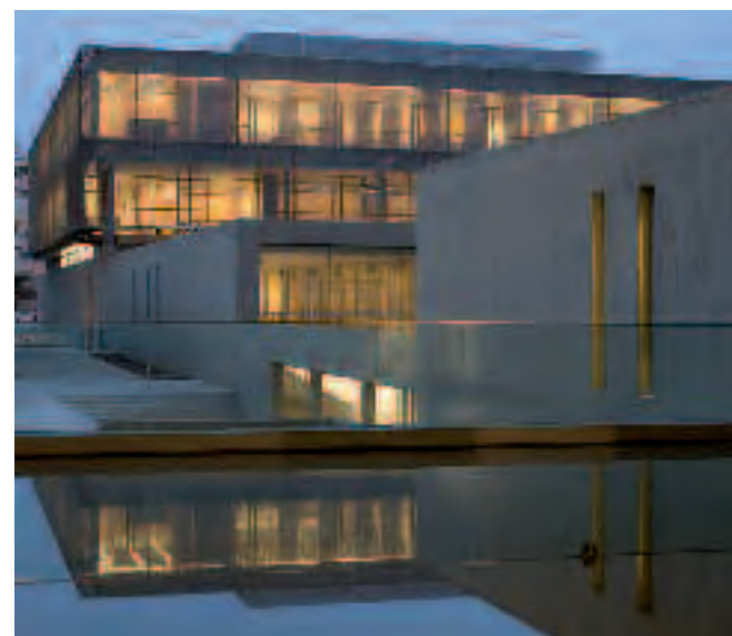
Instalações de Trigeração na nova sede da Deputação de Málaga.
