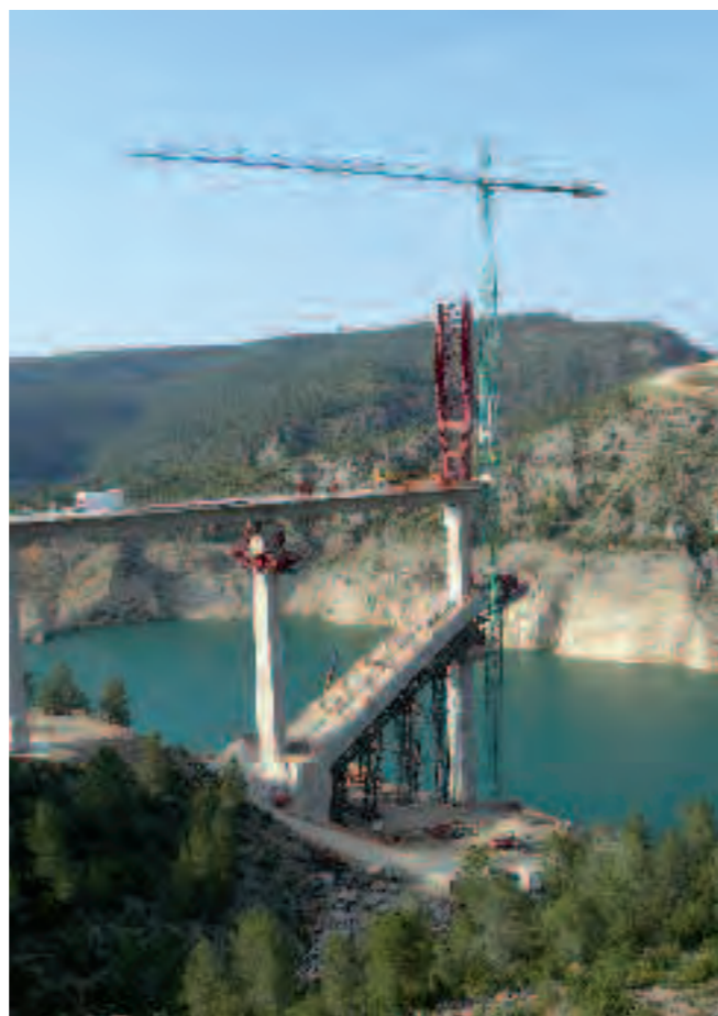
Acesso ferroviário de Alta Velocidade Madrid-Valencia.
