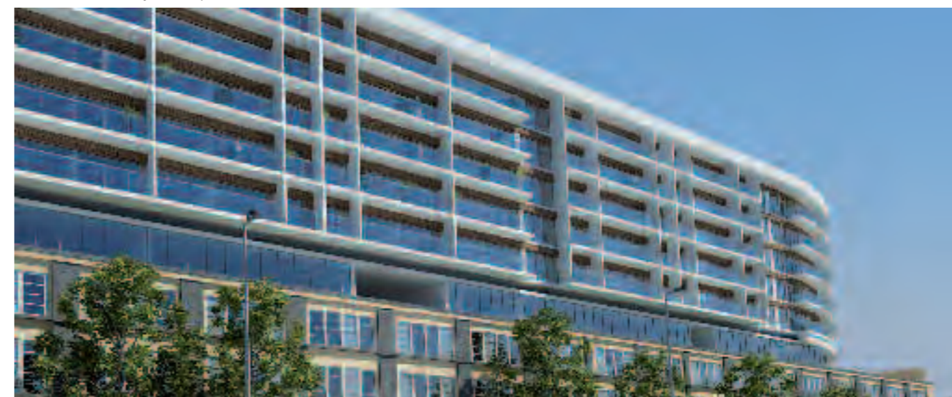
Residências Metrocity no Parque das Nações, Lisboa.
