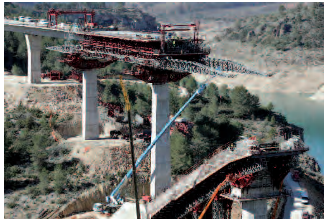
Acesso ferroviário de Alta Velocidade Madrid-Valencia.
