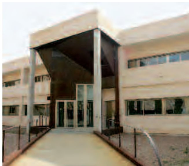
Ampliação Universidade Castela La Mancha, Ciudad Real.
