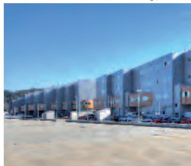
Edifícios Industriais Texvigo, Pontevedra.
