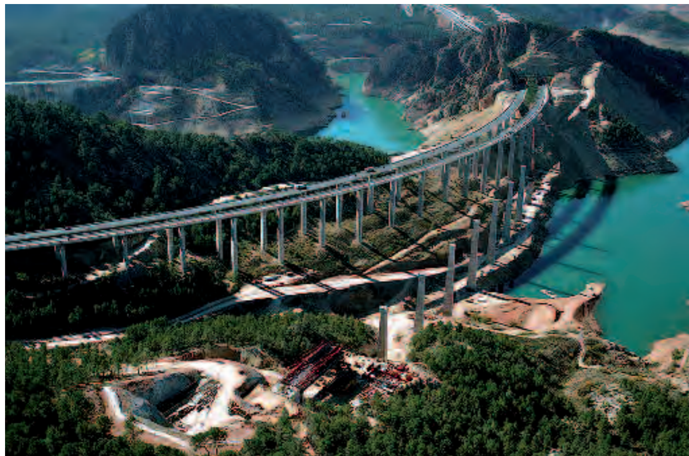
Acesso ferroviário de Alta Velocidade Madrid-Valencia.
