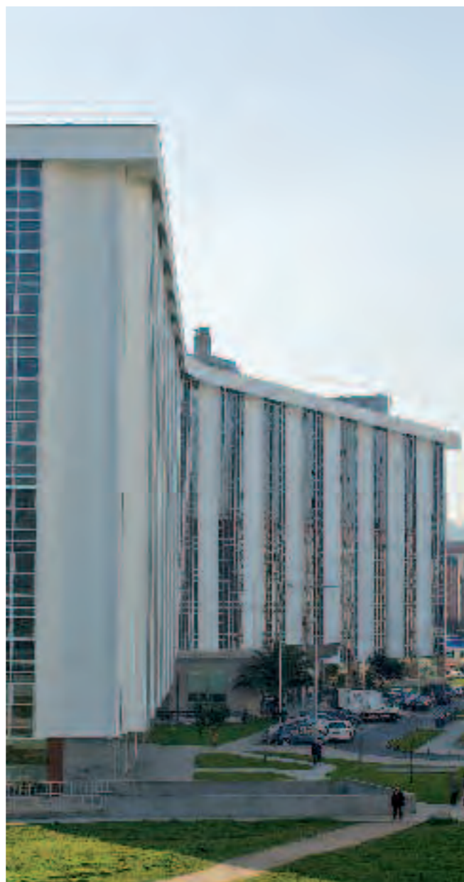
Edifício Monelos, Corunha
