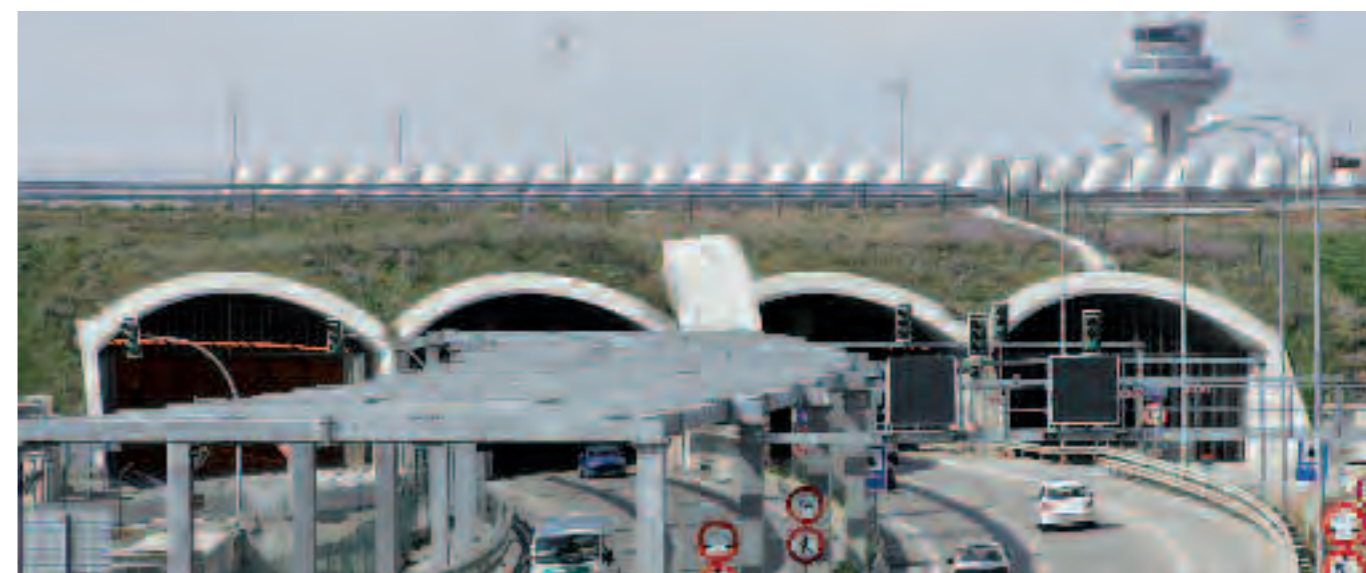
Túneis do Aeroporto de Barajas, Madrid.
