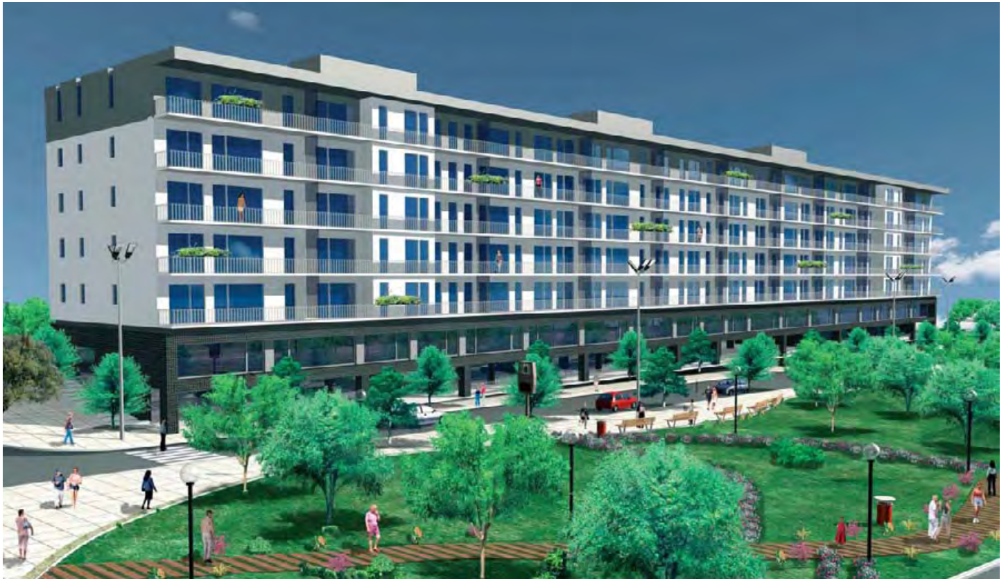
Edifícios de habitação, Maia (Portugal)
