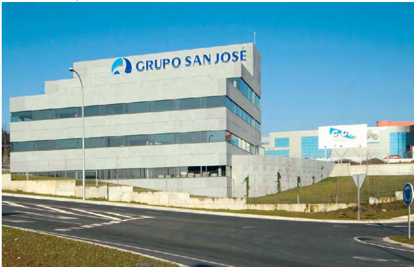
Edifício de Escritórios do Grupo San José
