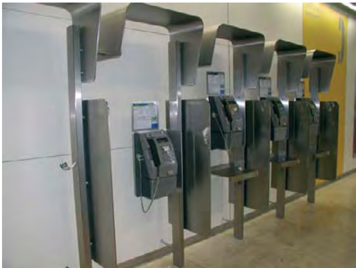
Manutenção de mobiliário urbano
