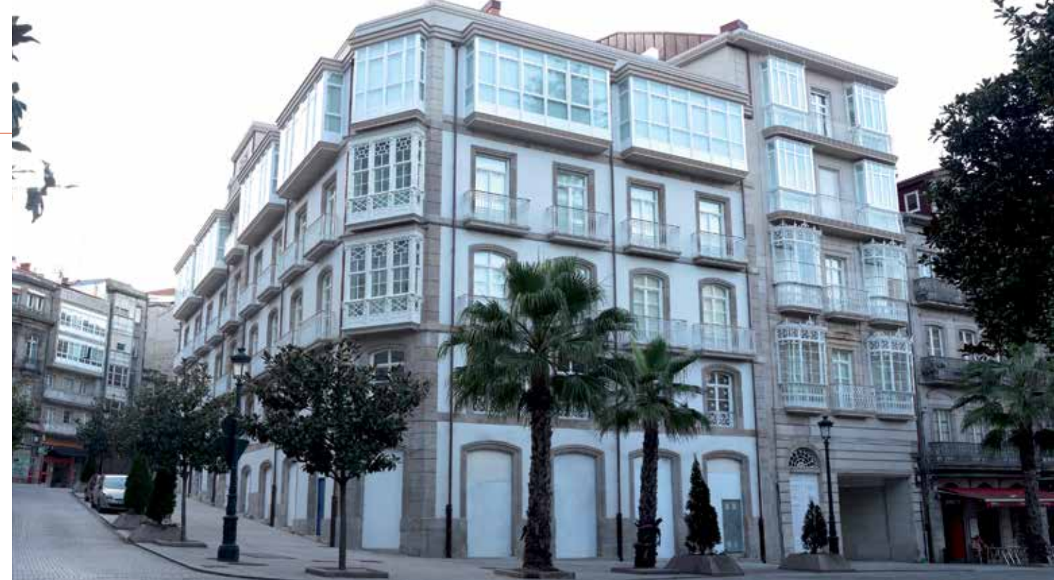
Bâtiment Victoria sur la Plaza de Compostela, Vigo (Espagne)
