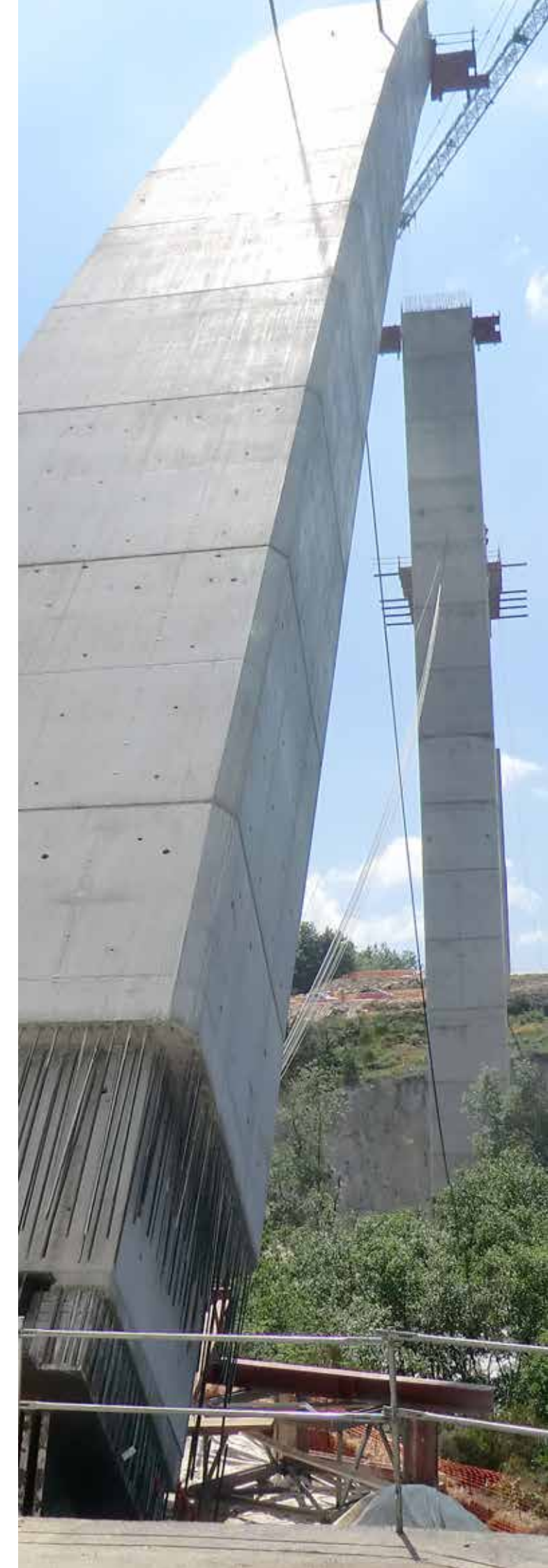
Viaduc de Arnoia, tronçon Miamán - Ponte Ambía (Orense). AVE Madrid-Galice (Espagne)
