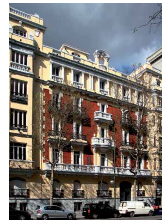
Bâtiment José Abascal 45, Madrid (Espagne)
