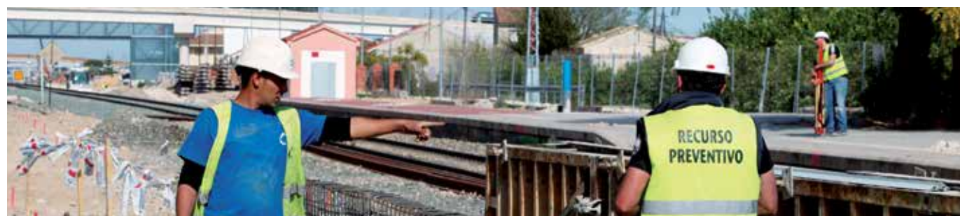
Tronçon Colada de la Buena Vida - Murcia (Espagne)
