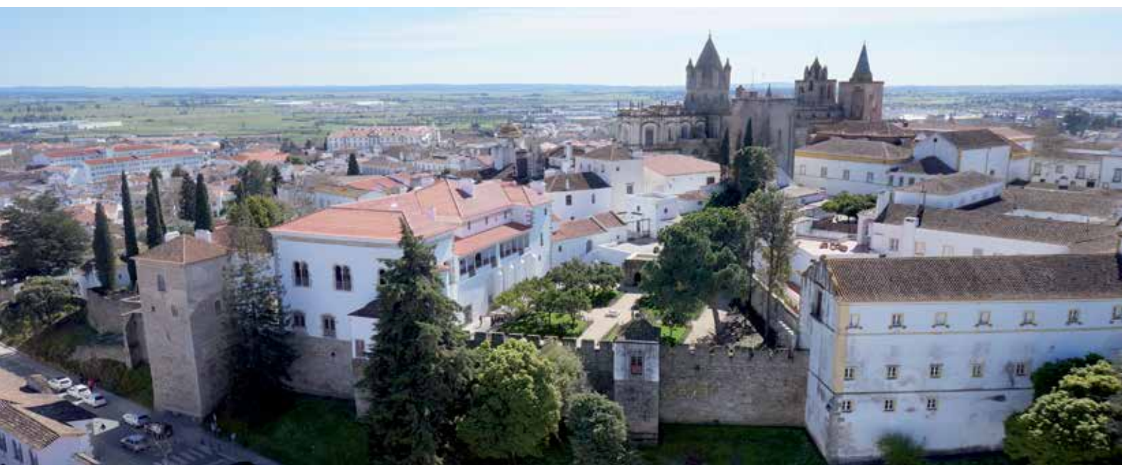
Réhabilitation Palais de l'Inquisition, Casas Pintadas et Patio de San Miguel de Évora (Portugal)
