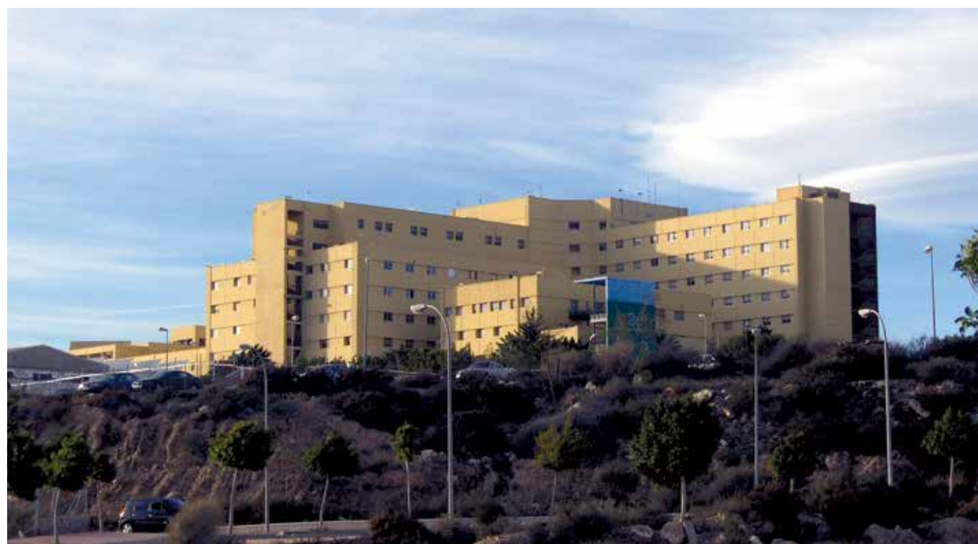
Hôpital de Torrecárdenas, Almería (Espagne)
