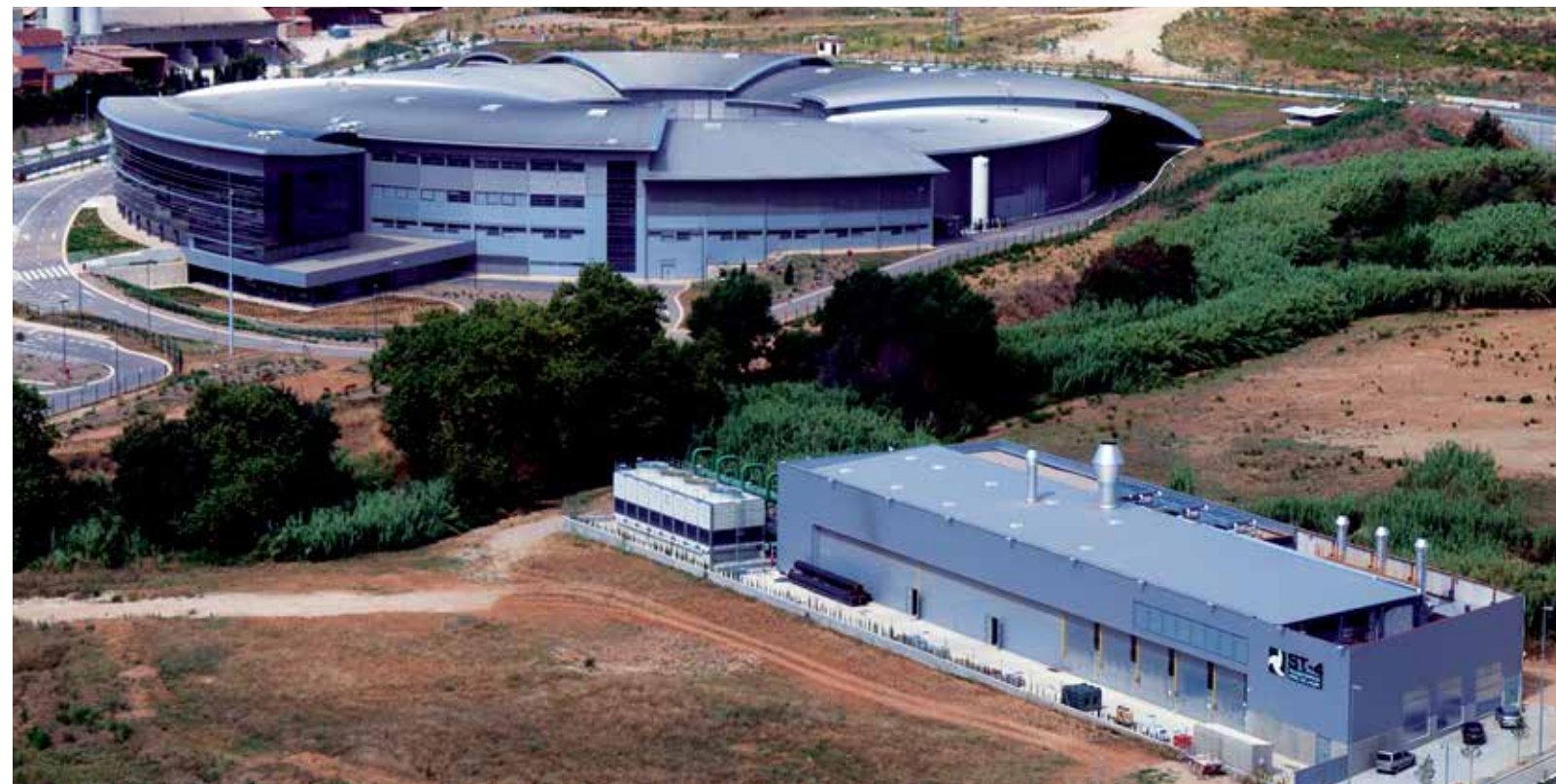
Centrale ST-4 et Accélérateur de Particules Synchrotron Alba
