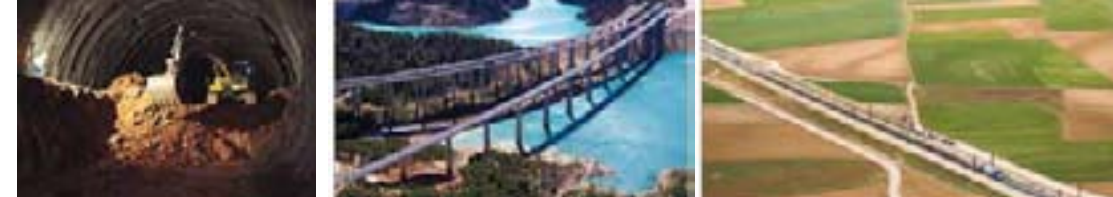
Détail du tunnel, AVE Madrid-Valence (ligne à grande vitesse)
