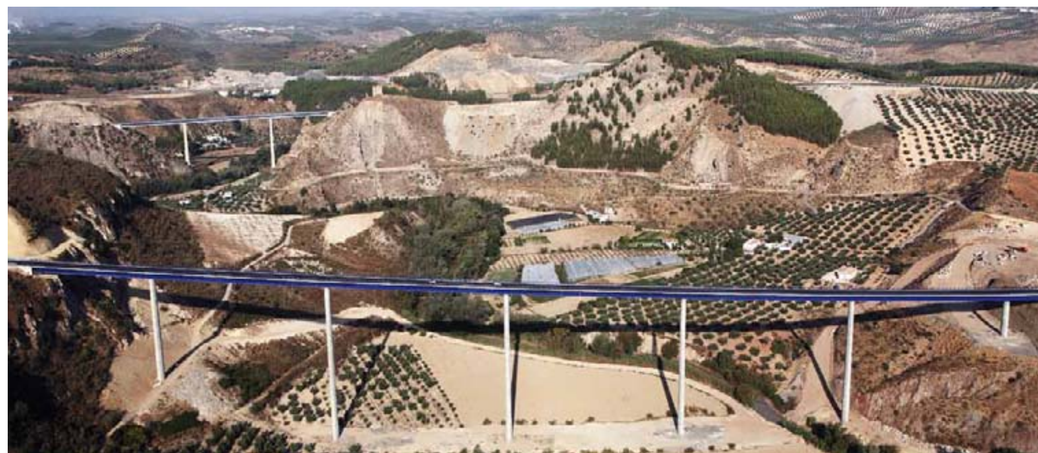
Viaduc sur la rivière Genil de la A-45, Cordoue
