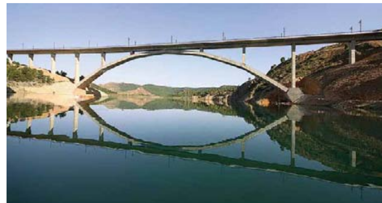
Viaduc Barrage de Contreras, AVE Madrid - Valence (ligne à grande vitesse)
