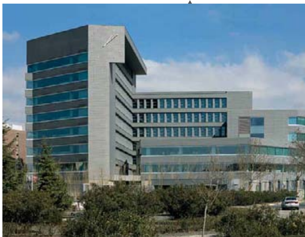
Bâtiment Administratif Multiple du Gouvernement d'Andalousie à Almanjajar, Grenade
