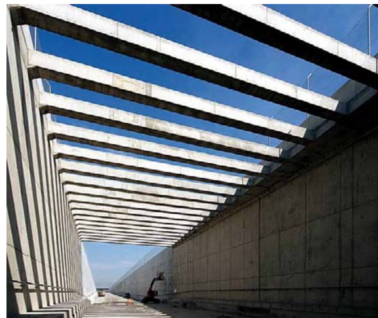
Tronçon Montcada-Mollet, AVE Madrid-Saragosse-Barcelone (ligne à grande vitesse) Frontière Française
