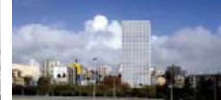
Bâtiment Burgo, Porto
