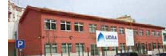
École Primaire et Garderie de la Póvoa, Santo Adrião-Odivelas
