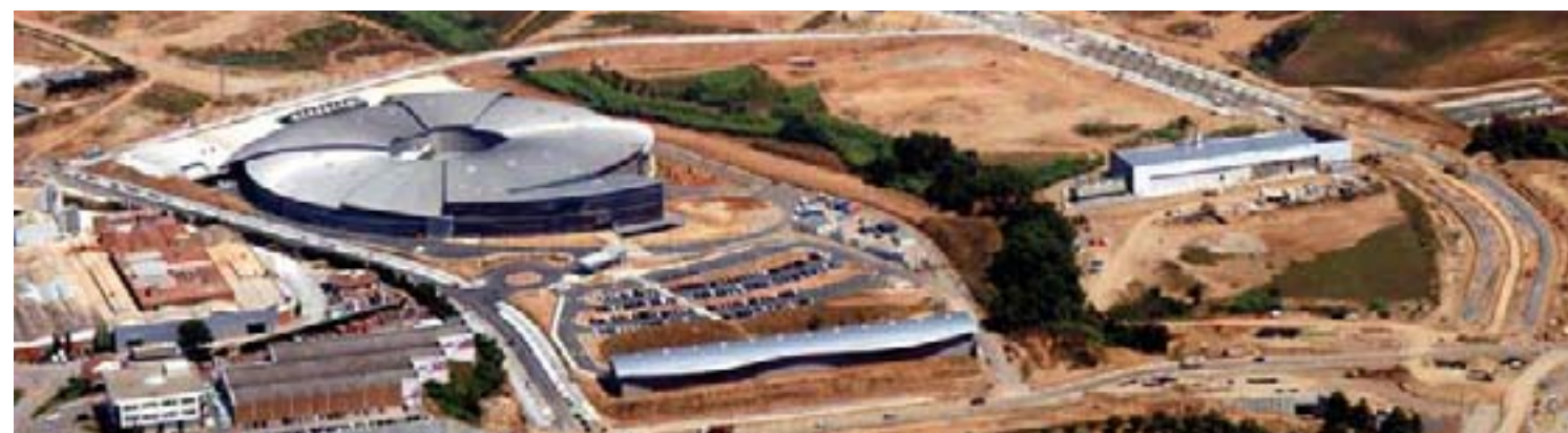
Usine de Polygénération (froid et chaleur) à Cerdanyola del Vallés, Barcelone
