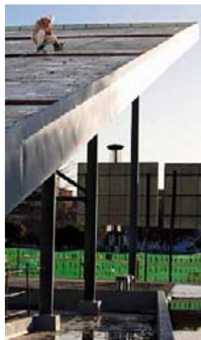
Annexe du service de Propreté Urbaine dans le Terminal de Télécabine de l'Expo 92 à Séville
