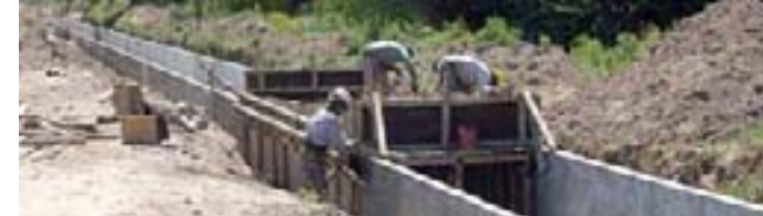
Projet de Modernisation et d'Unification des canaux Socavón à San Rafael, Mendoza
