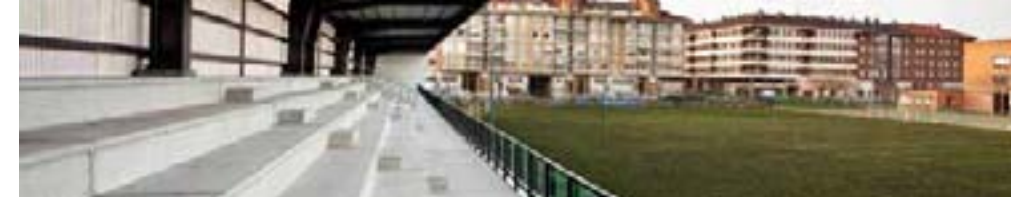
Vestiaires et gradins au terrain de football San Martín à Vitoria
