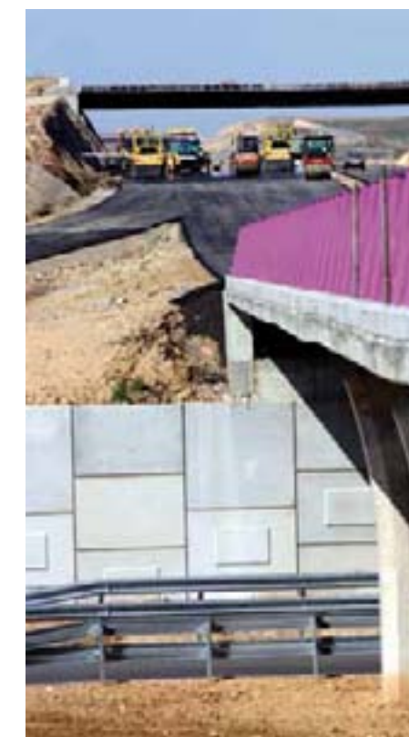
Voie Rapide Déviation sud-ouest de Tolède
