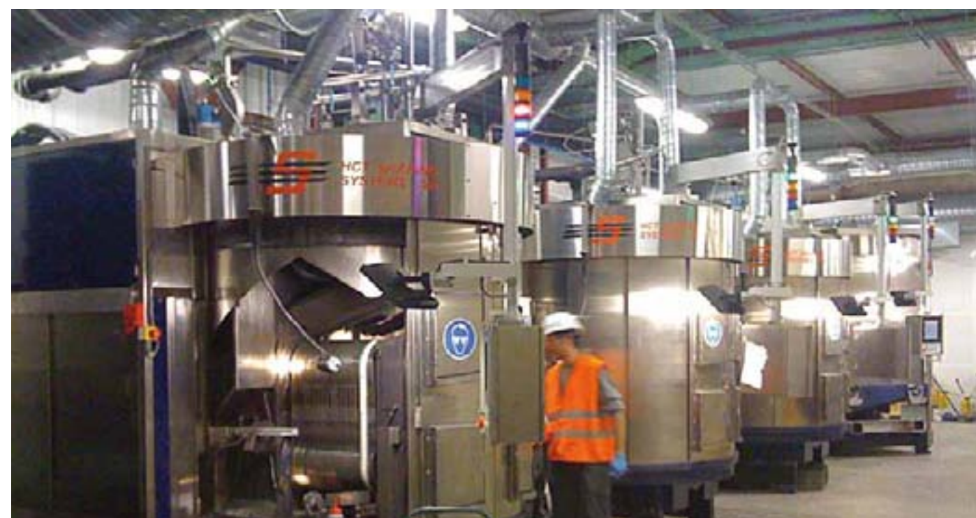
Usine de fabrication de plaquettes photovoltaïques à León
