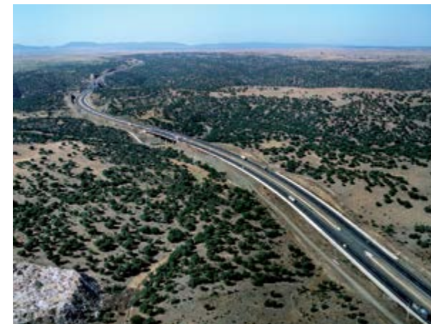
Mantenimiento carreteras del Estado sector CC-3 Cáceres
