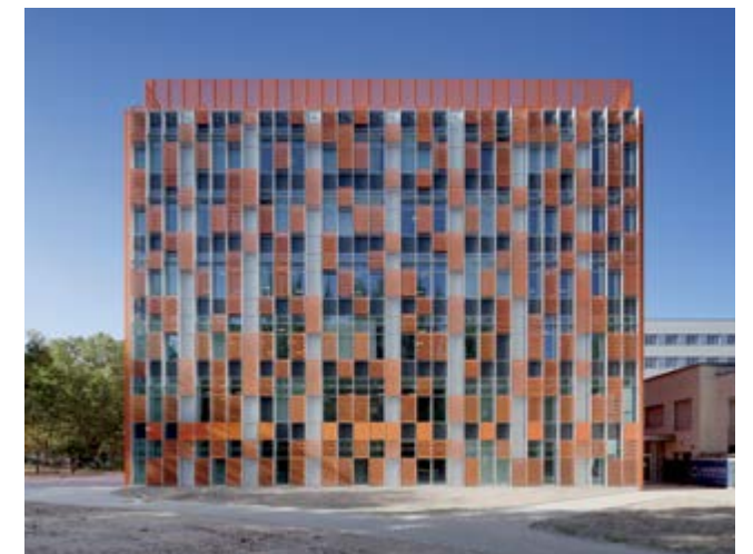
Aulario IndUVA de la Universidad de Valladolid (España)
