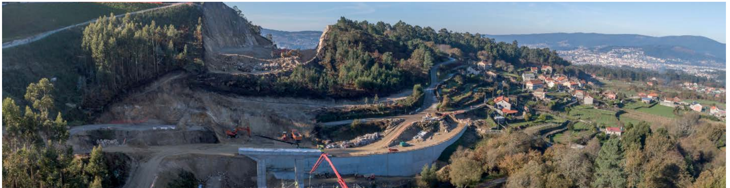
Tramo Vilaboa - A Ermida de la futura Autovía A-57, Pontevedra
