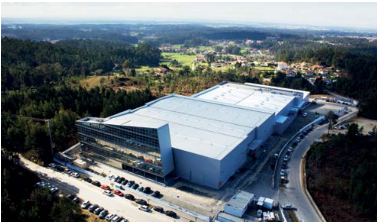
Ampliación de la fábrica de Aspock Logistics en Vila de Cucujães, Oliveira de Azemeis (Portugal)
