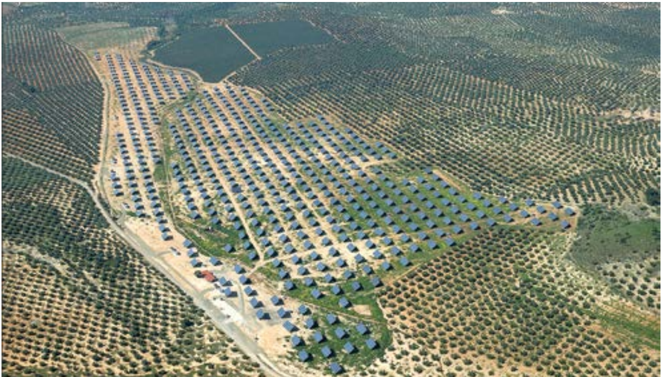
Planta fotovoltaica en Alcaudete, Jaén (5,4 MW). Ingeniería y proyecto GSJ Solutions / Ejecución SANJOSE Constructora
