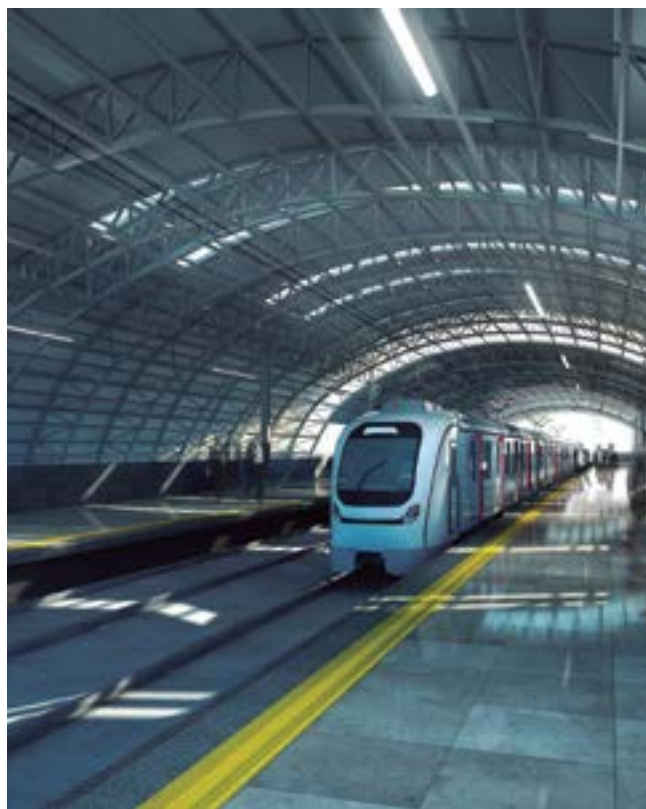
Estaciones de la Línea 1 del Metro de Navi Mumbai, Bombay (India)
