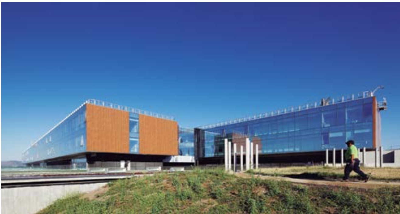
Hospital El Carmen Dr. Luis Valentín Ferrada de Maipú, Santiago de Chile. Ingeniería y proyecto GSJ Solutions / Ejecución SANJOSE Constructora
