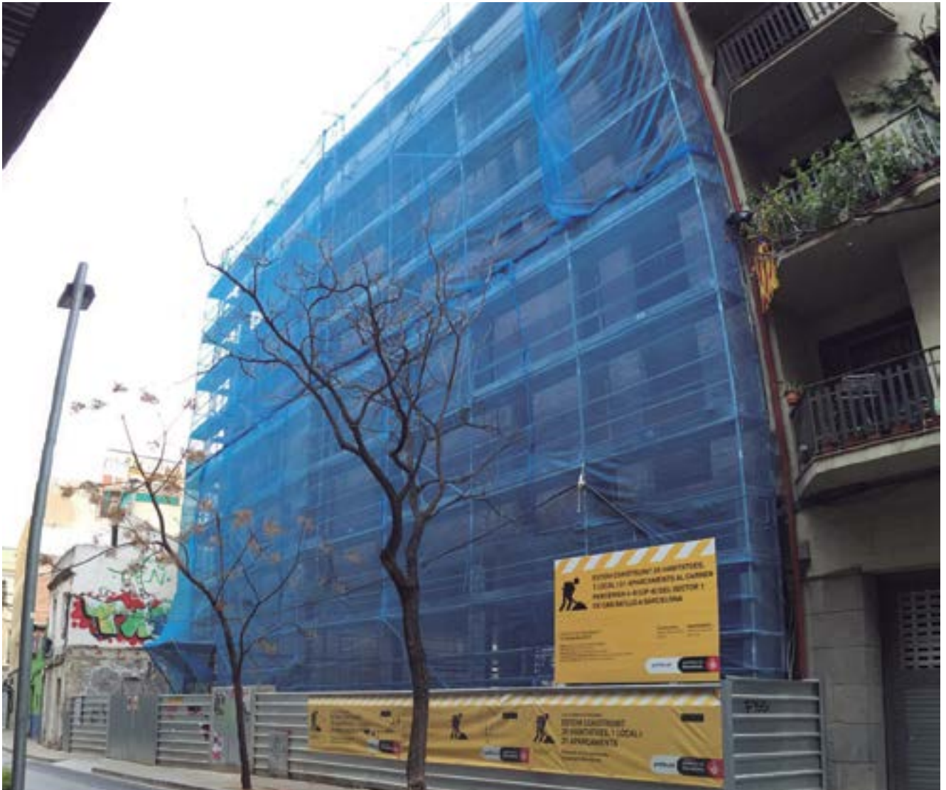
Edificio de viviendas en el Sector 1 de Can Batlló, Barcelona
