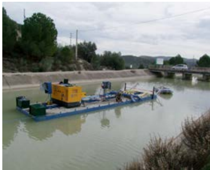
Infraestructura hidráulica para la mejora de la eficiencia en el canal principal de la zona regable del Genil - Cabra, Córdoba
