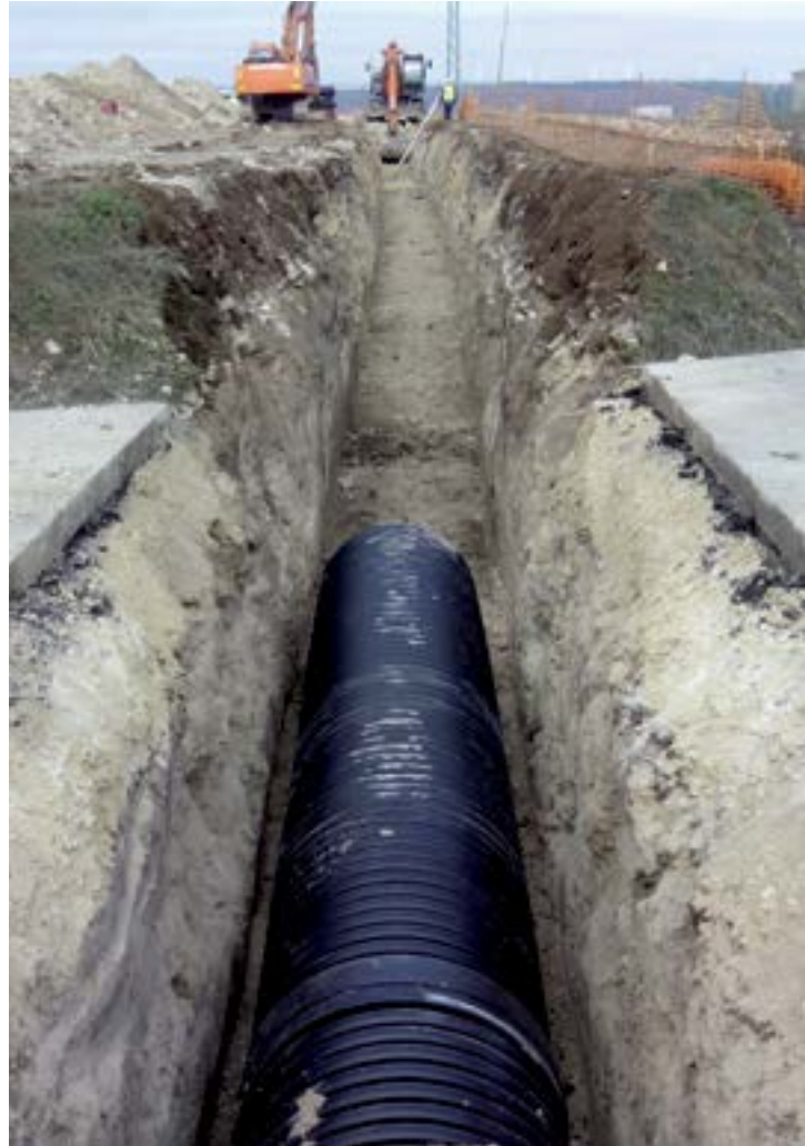
Anillo de abastecimiento y depósitos de agua potable de Cortes, Burgos
