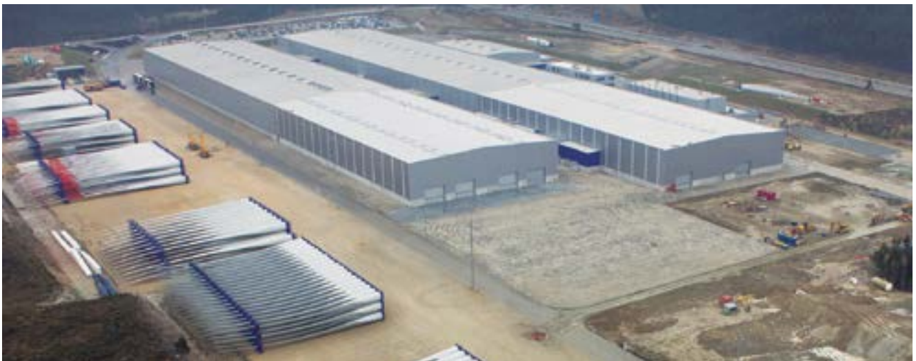
Ampliación de la fábrica de Ria Blades en Vagos, Aveiro (Portugal)
