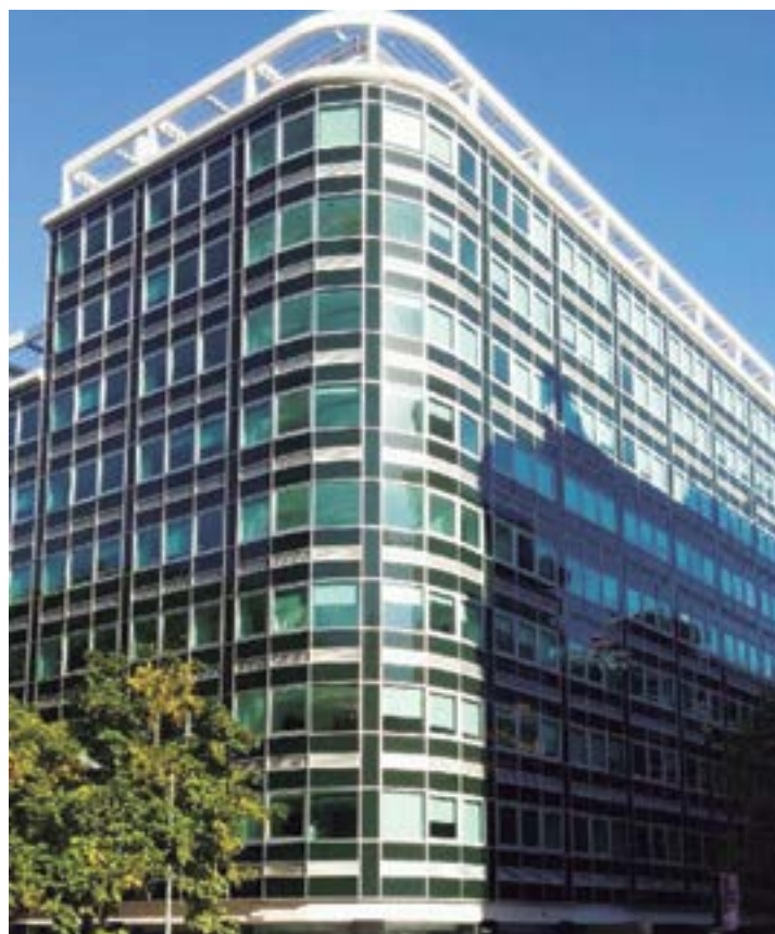
Rehabilitación de edificio de oficinas para el Banco de Portugal, Lisboa (Portugal)
