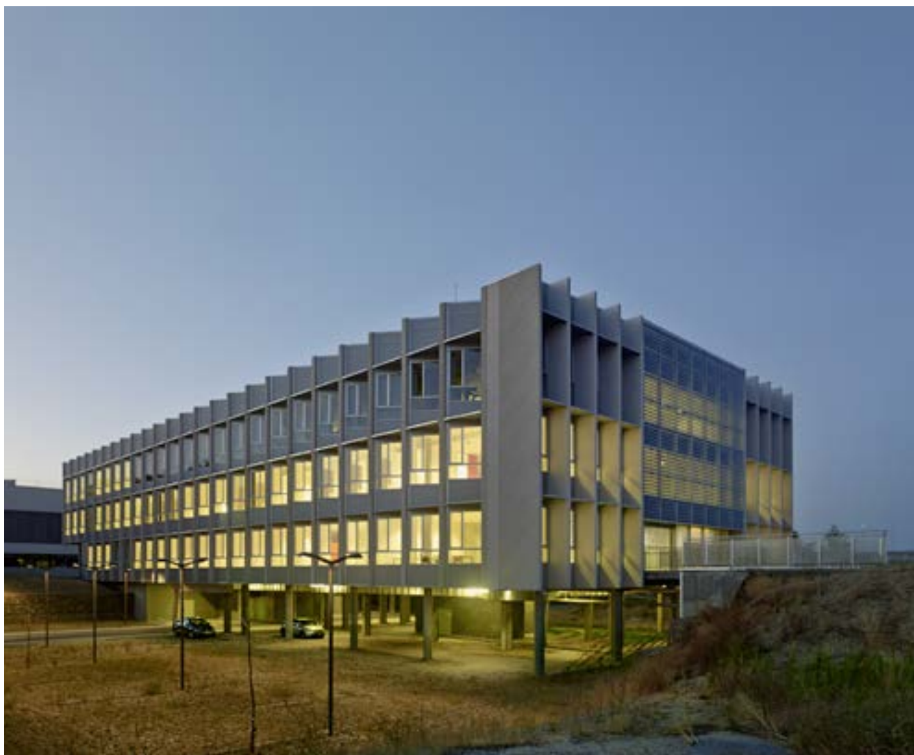
Edificio LUCIA en la Universidad de Valladolid (España). Certificado con 98 puntos por Leed Platinum como el edificio más sostenible de Europa y el segundo de todo el mundo
