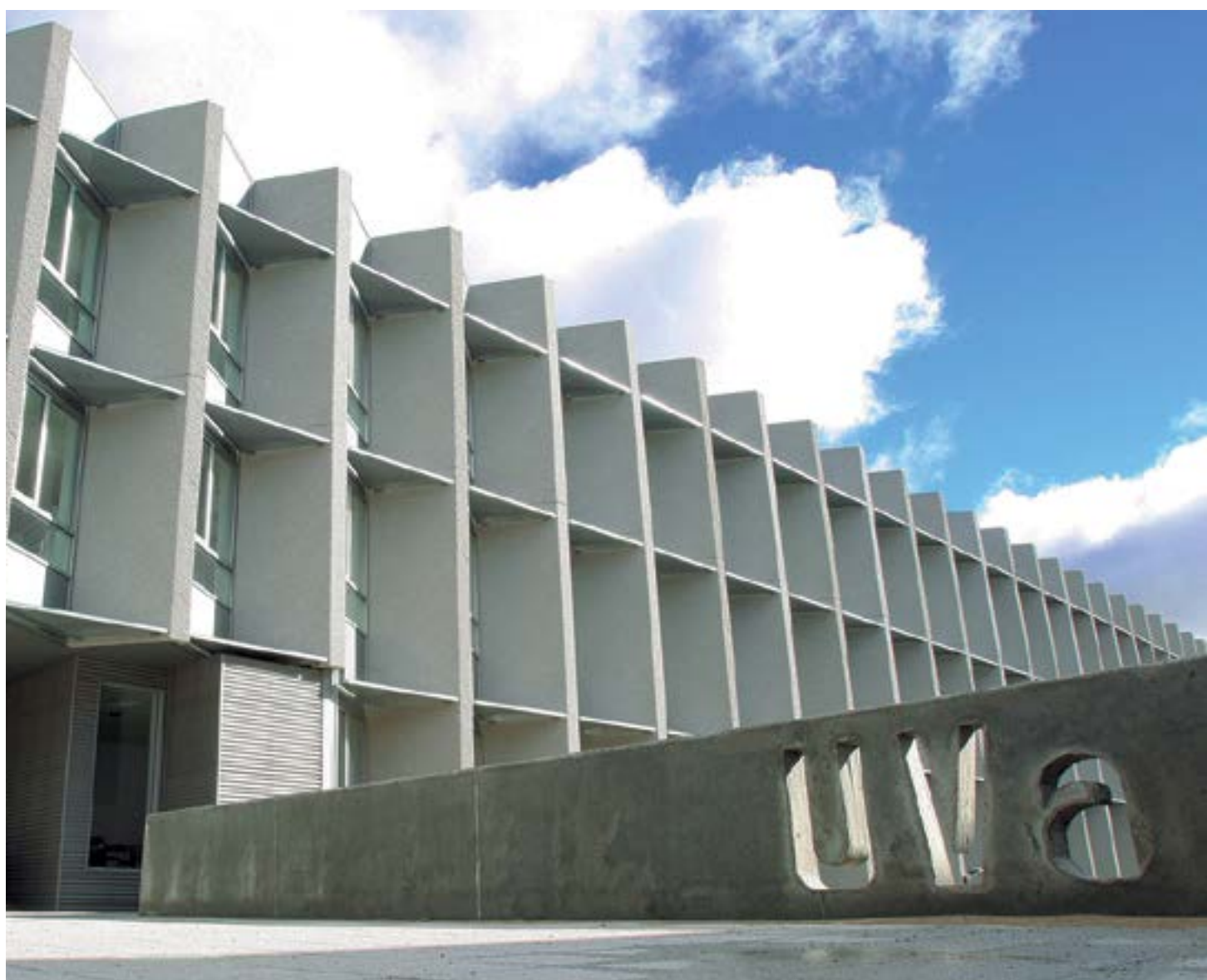
■ Edificio Lanzadera Universitaria de Centros de Investigación Aplicada (LUCIA), Universidad de Valladolid. Certificado con 98 puntos por Leed Platinum como el edificio más sostenible de Europa y el segundo de todo el mundo
