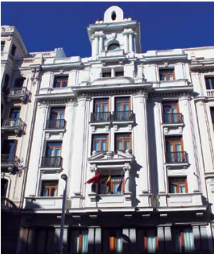
Rehabilitación Hotel H10 Villa de la Reina 4 estrellas en Gran Vía, Madrid
