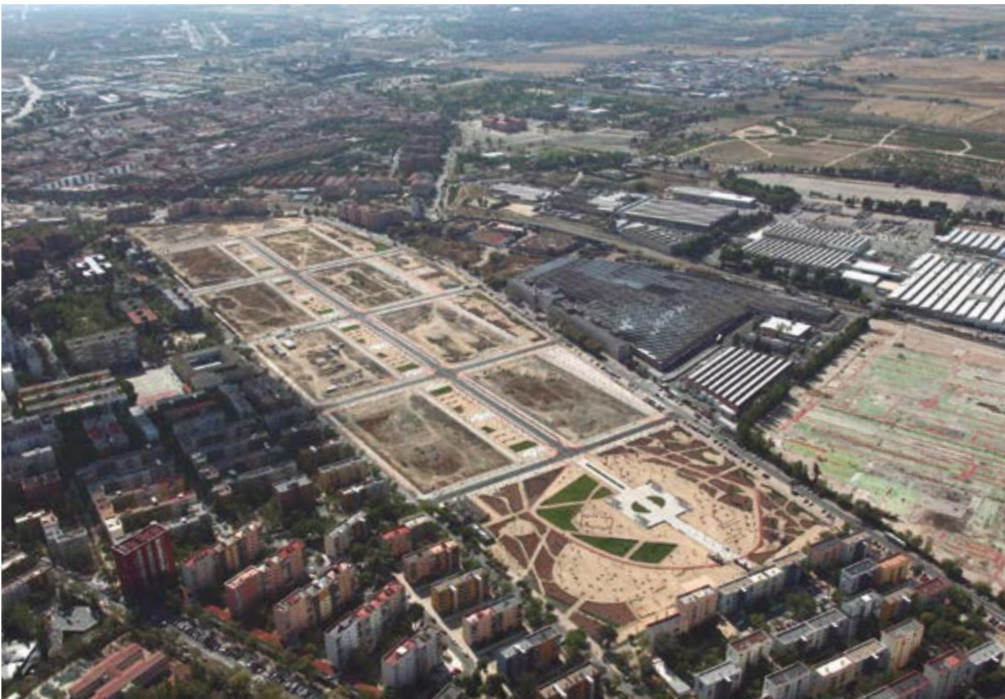
■ Urbanización Central de Ingenieros de Villaverde (273.794 m 2 ), Madrid
