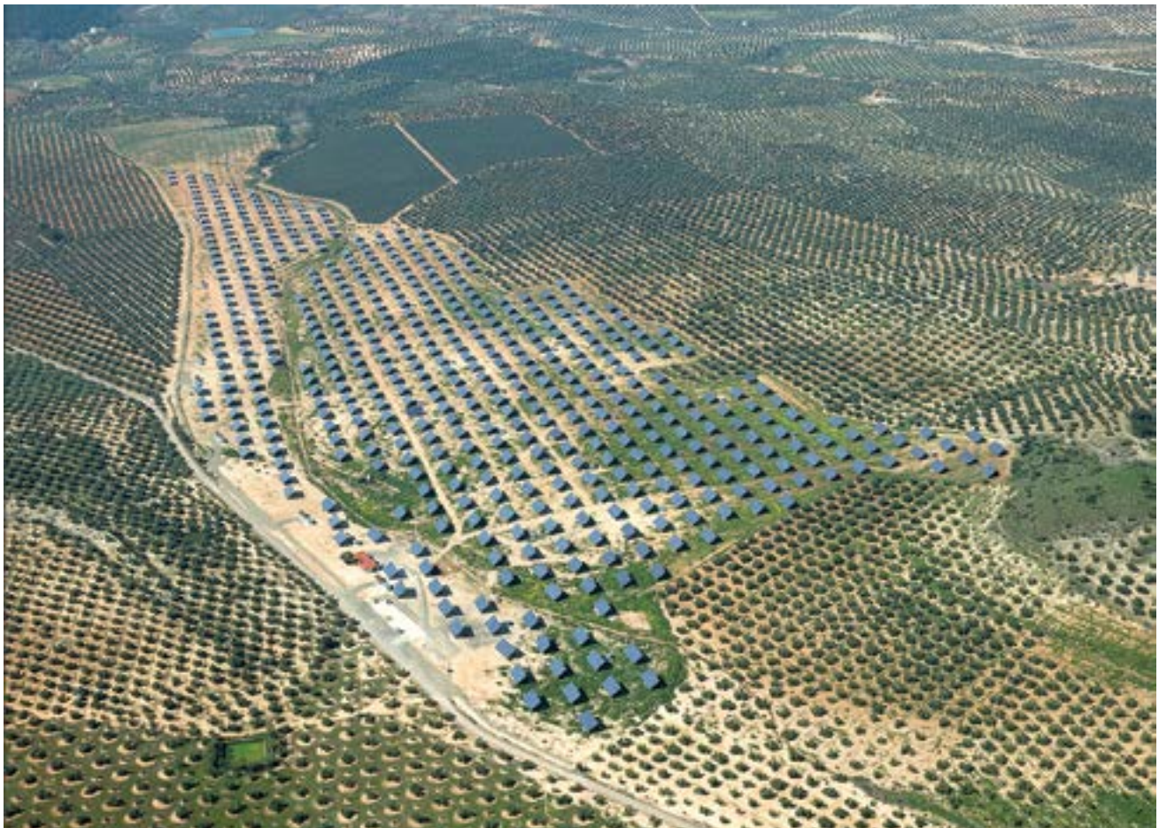
■ Planta fotovoltaica en Alcaudete, Jaén / 5,4 MW
