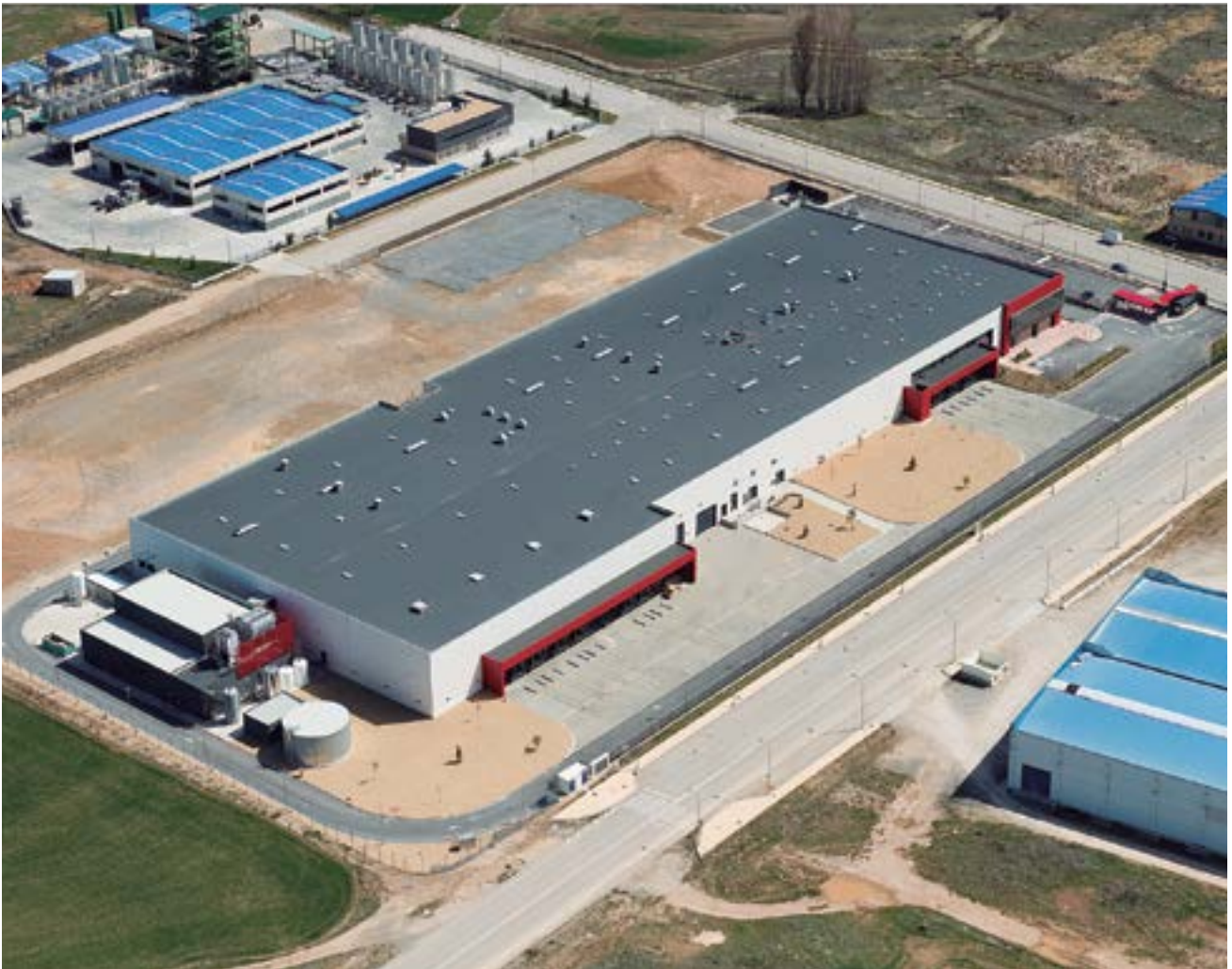
■ Reforma instalaciones de la Planta de Campofrío en Ólvega, Soria
