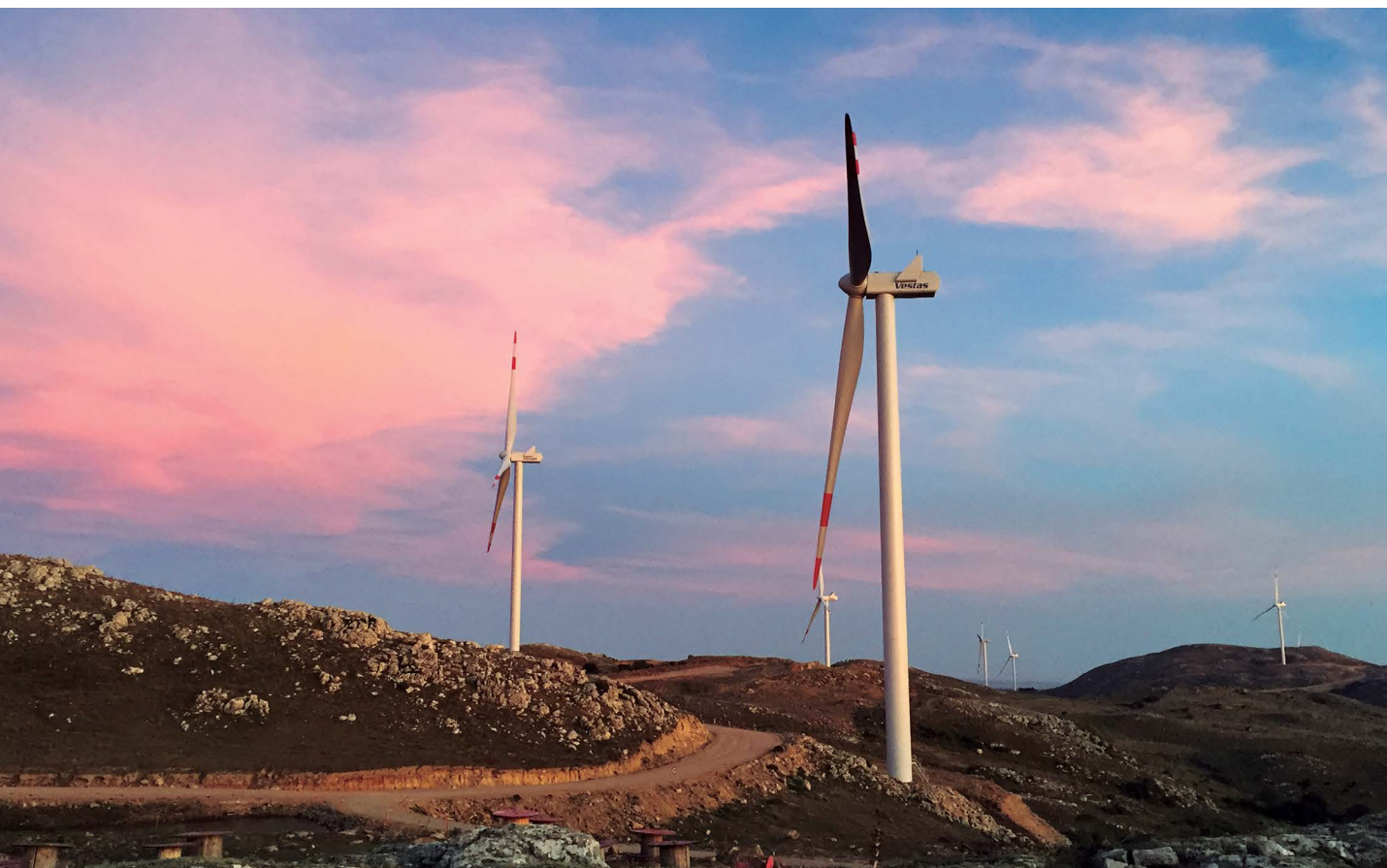
Promoción y desarrollo de dos parques eólicos (90 MW) en Uruguay. Ingeniería y proyecto GSJ Solutions / Ejecución SANJOSE Constructora
