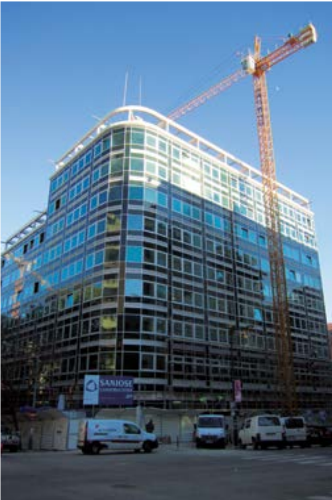
■ Rehabilitación edificio de oficinas C/Castilho 24, Lisboa (Portugal)
