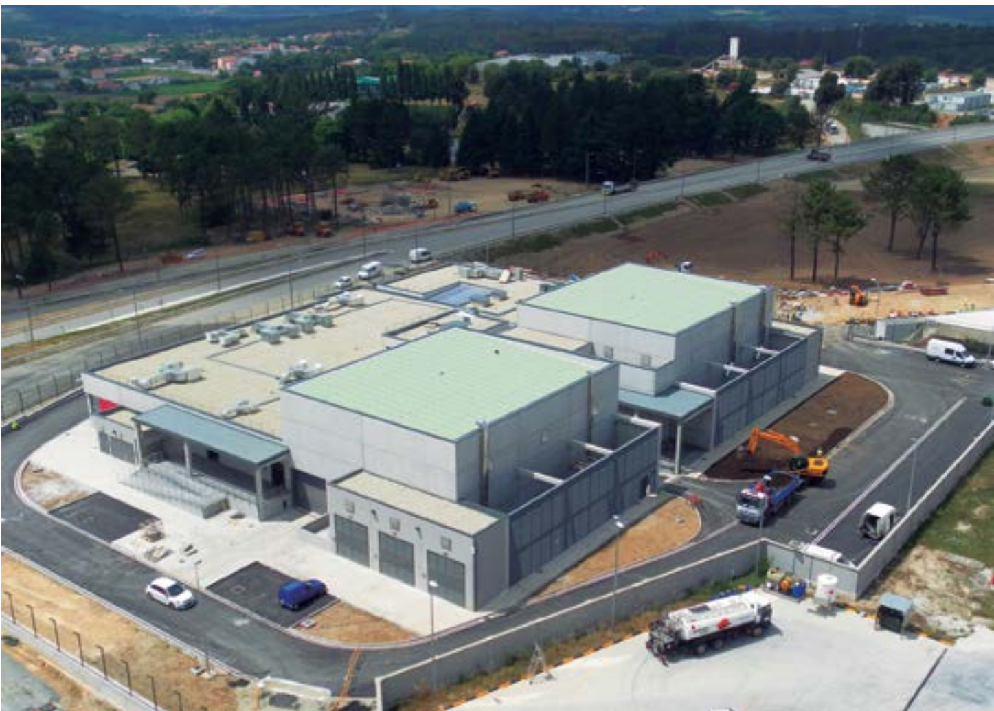
Central Eléctrica del Aeropuerto de Santiago de Compostela
