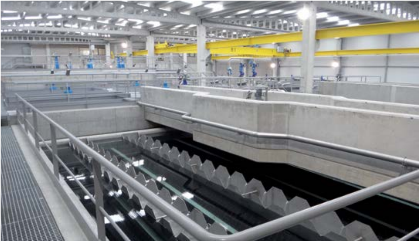
■ Estación de Tratamiento de Agua Potable (ETAP) de Monforte de Lemos, Lugo. Ingeniería y proyecto GSJ Solutions / Ejecución SANJOSE Constructora
