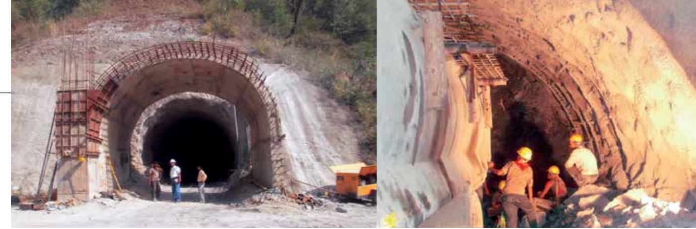
Túneles ferroviarios para Indian Railways, Estado de Manipur
