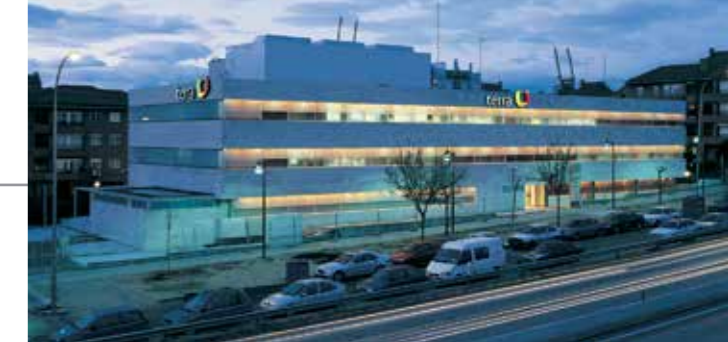
Edificio Vía Dos Castillas, Pozuelo de Alarcón (Madrid)
