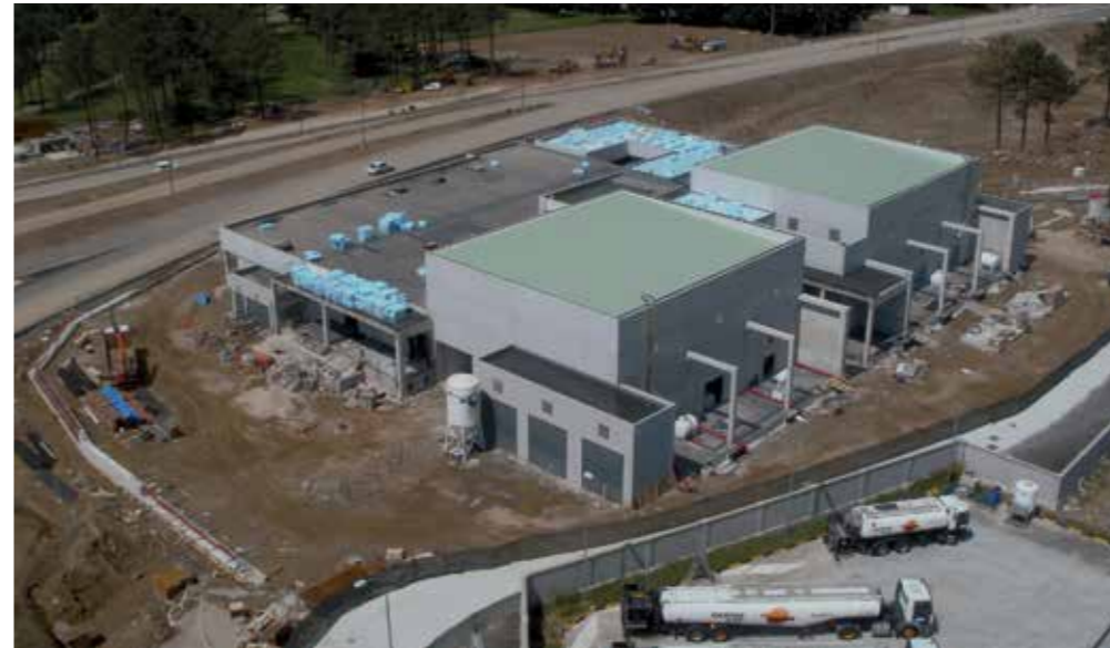
Central Eléctrica del Aeropuerto de Santiago de Compostela
