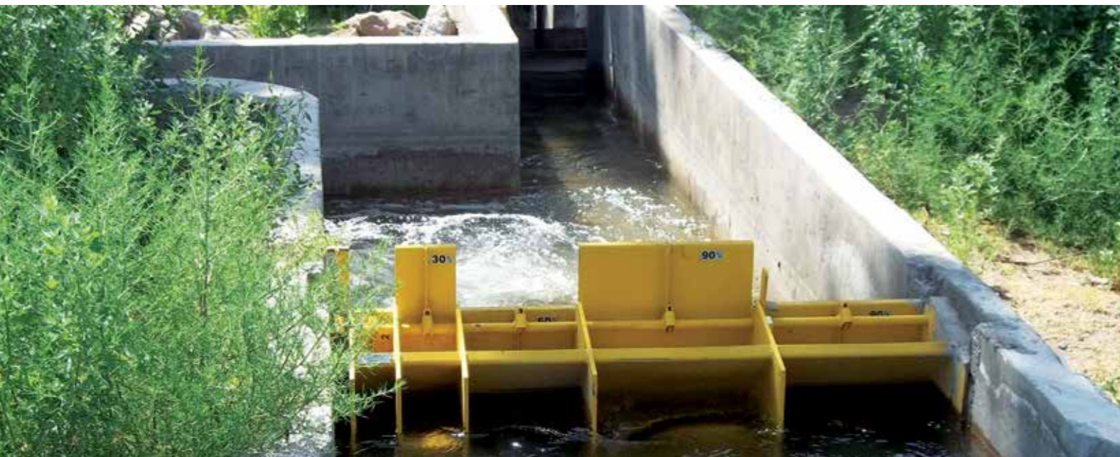
Canales Socavón en San Rafael, Mendoza (44.000 m.)
