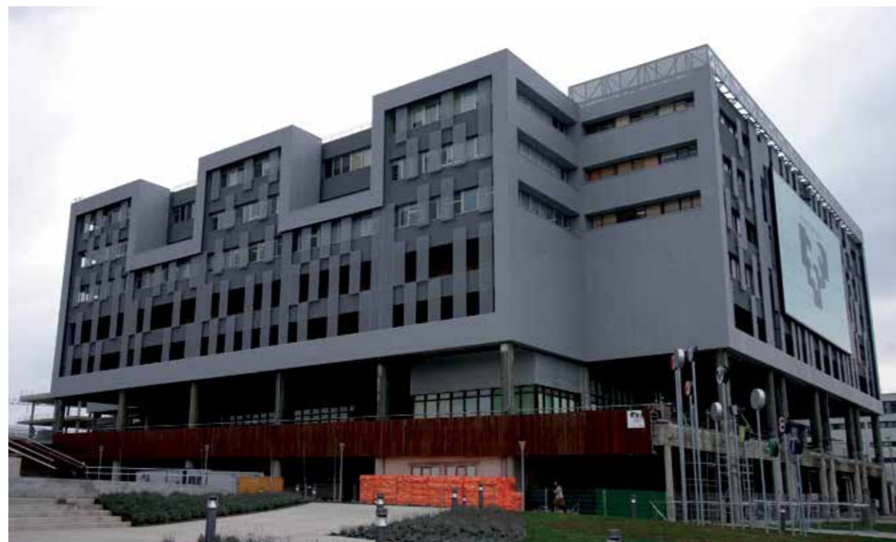
Rehabilitación de las fachadas de la Biblioteca Central de la Universidad del País Vasco en el Campus de Leioa, Vizcaya
