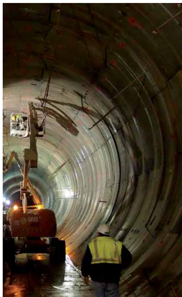
Túneles de Pajares, AVE Madrid - Asturias
