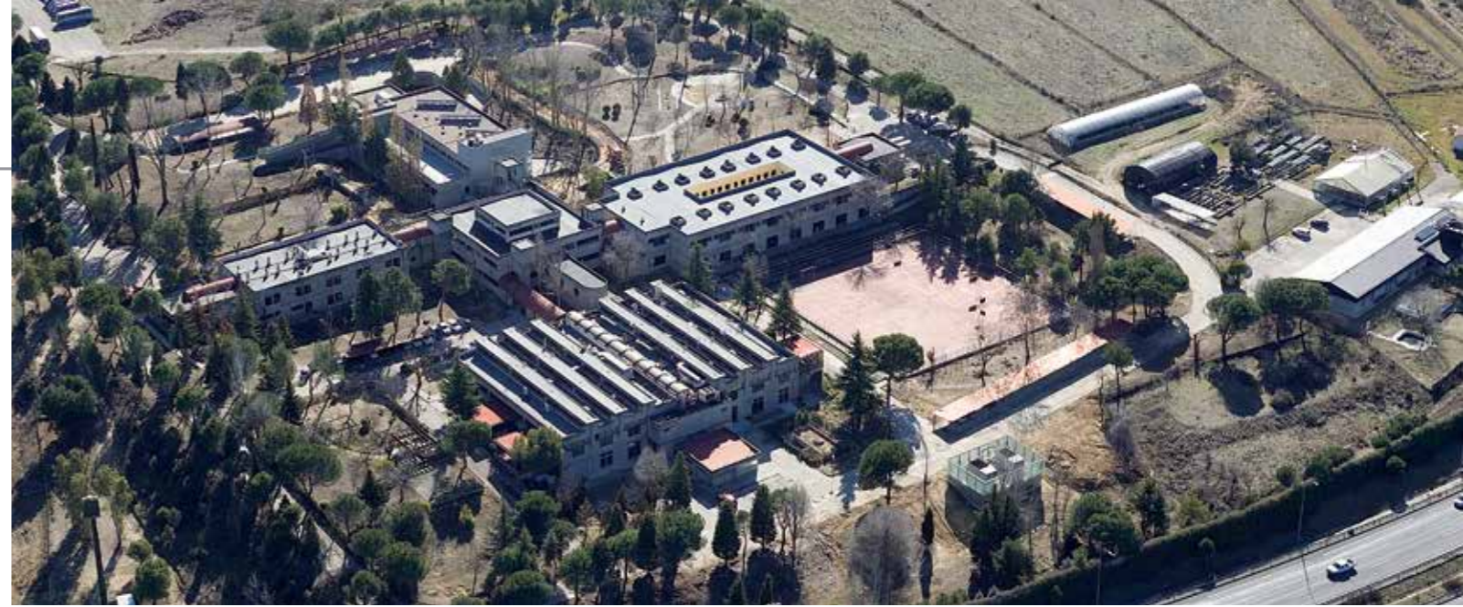
Conjunto Residencial de ATAM - Telefónica en Pozuelo de Alarcón, Madrid
