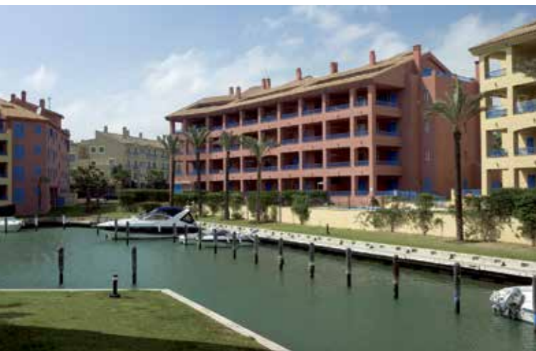
Residencial Guadalmarina I y II en Sotogrande, Málaga
