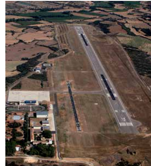
Balizamiento Aeropuerto de Huesca
