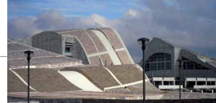
Edificio Administrativo de la Ciudad de la Cultura, Santiago de Compostela
