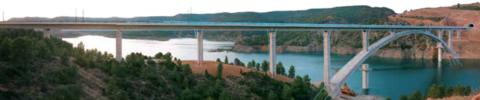
Tramo del Embalse de Contreras - Villargordo del Cabriel, AVE Madrid - Valencia
