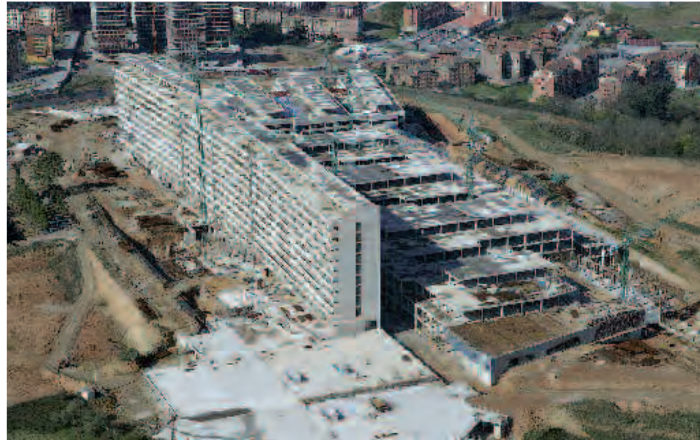
Hospital Universitario Central de Asturias, Oviedo.
