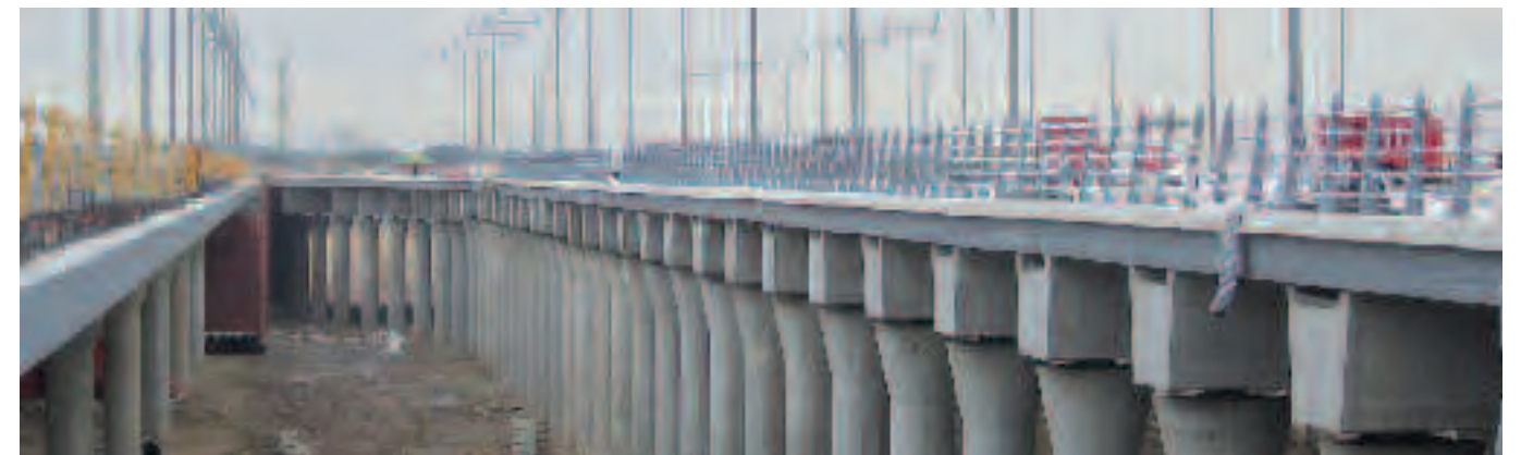
Conexión AP-68 con la Estación de Delicias, Zaragoza.
