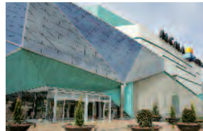
Centro Comercial "Alcalá Magna" en Alcalá de Henares, Madrid.
