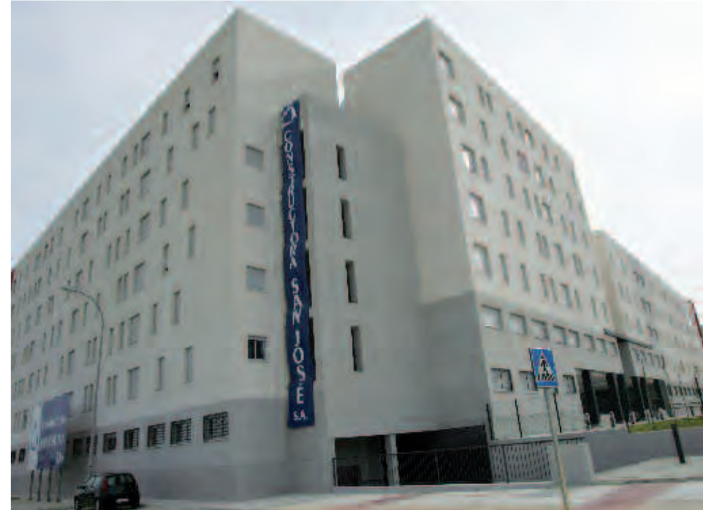
VPO en el Polígono Casines en Puerto Real, Cádiz.
