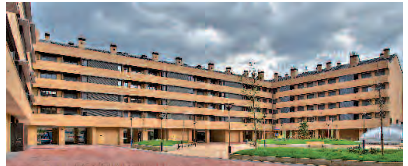
Viviendas en Echabarri, Vizcaya.
