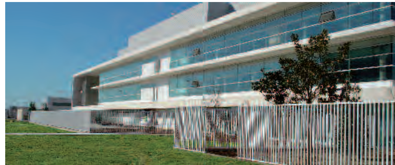
Sede de Barclays Bank, Zaragoza.
