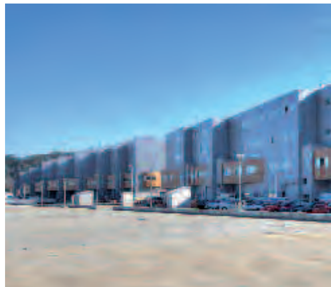
Edificios Industriales Texvigo, Pontevedra.
