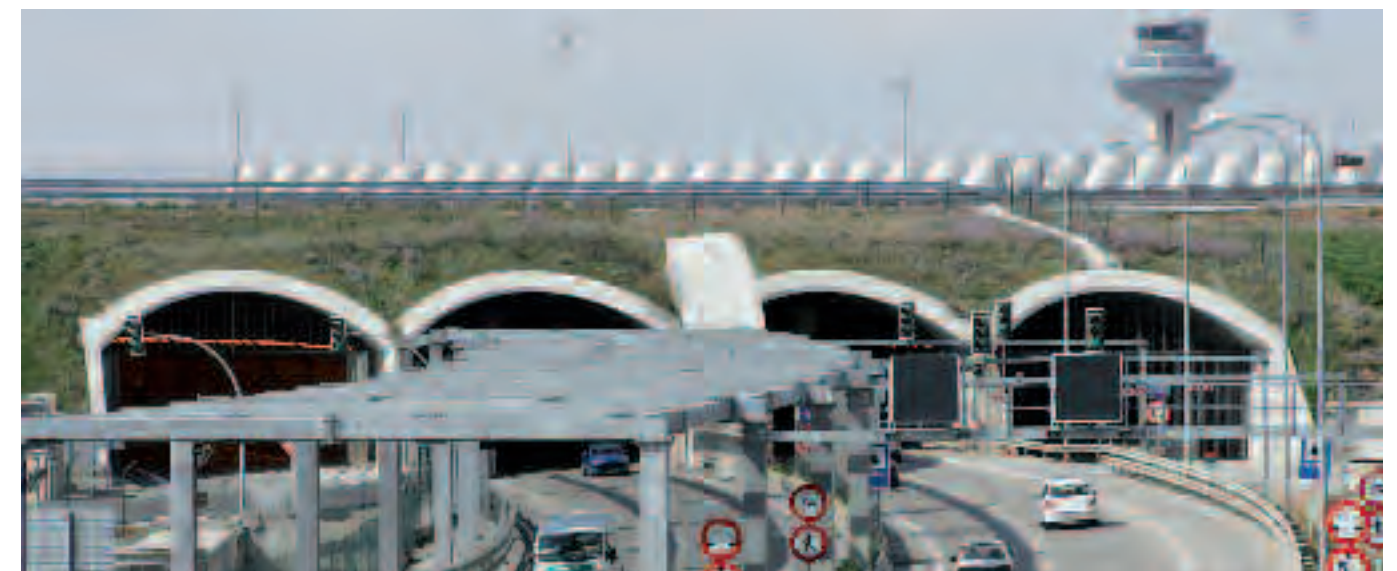
Túneles del Aeropuerto de Barajas, Madrid.
