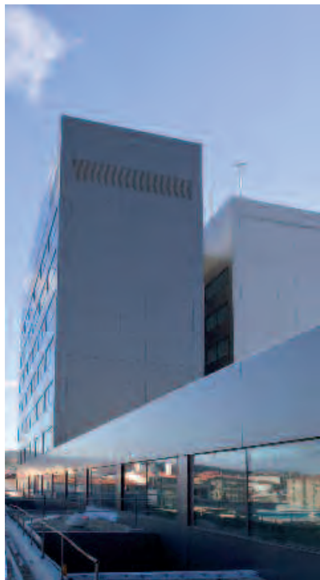
Edificio Administrativo de la Xunta en Campolongo, Pontevedra.
