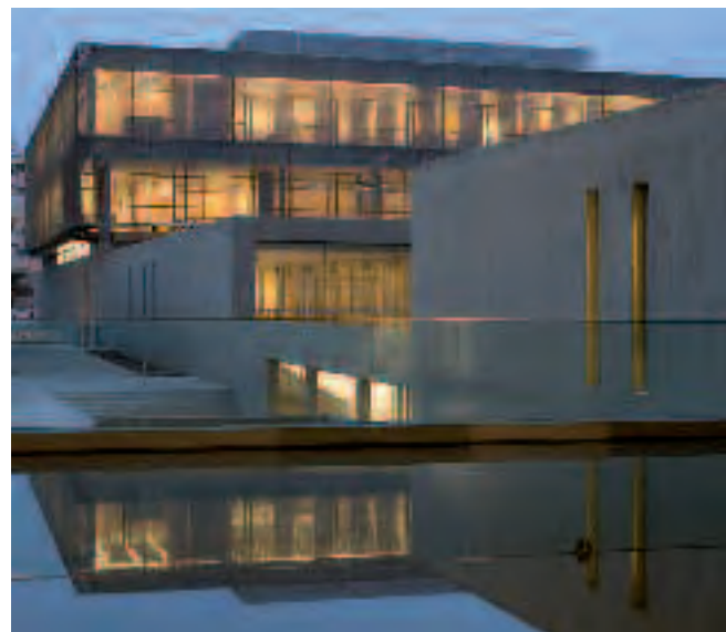
Instalaciones de Trigeneración en la nueva sede de la Diputación de Málaga.
