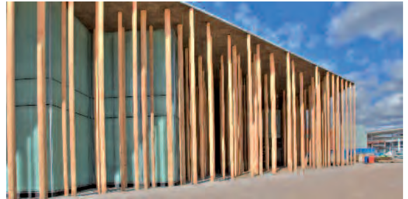
Pabellón de España EXPOAGUA, Zaragoza.
