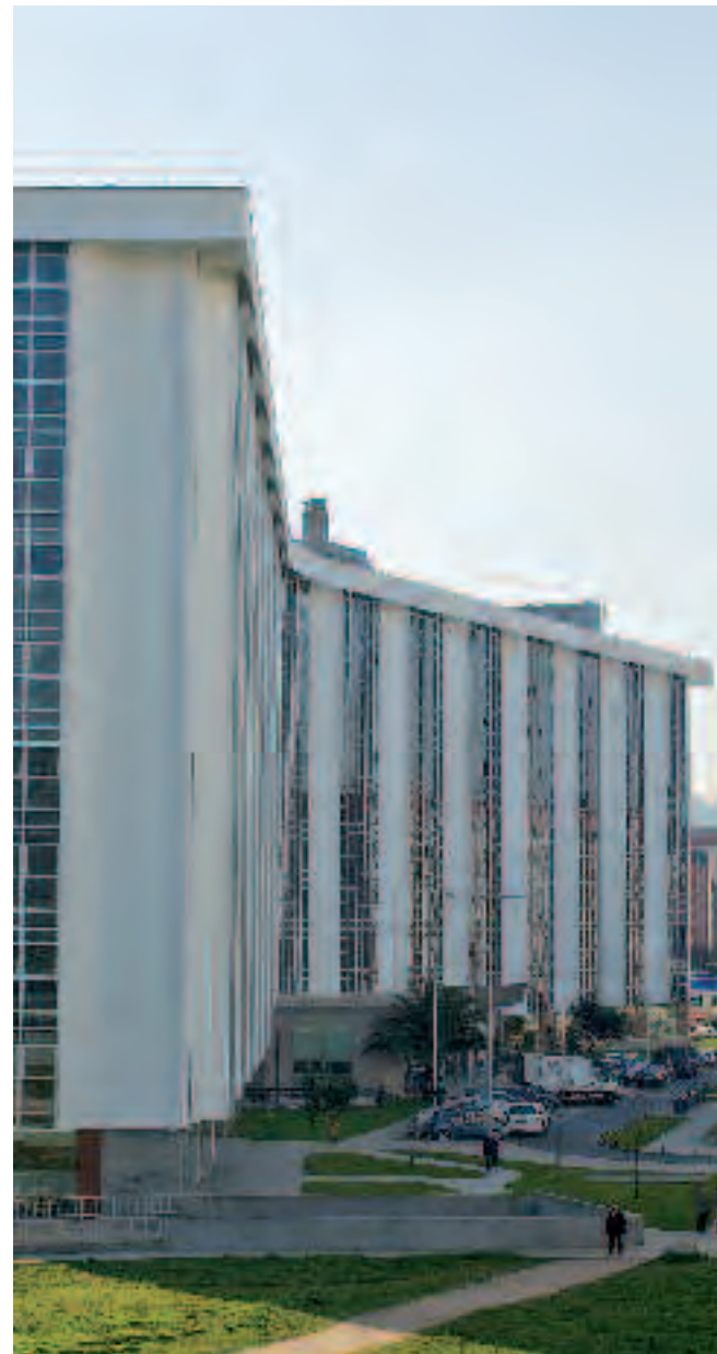
Edificio Monelos, La Coruña.
