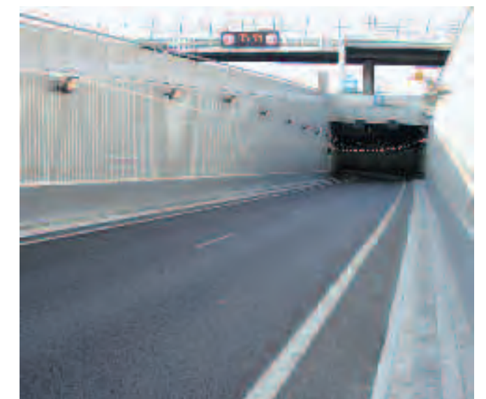
Túnel By-pass Sur, Madrid.
