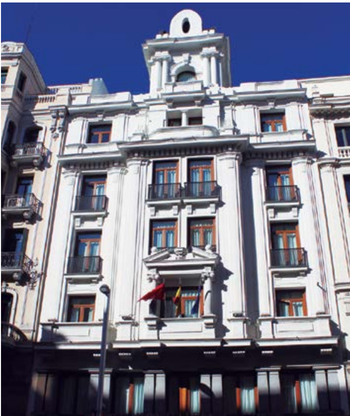
■ Refurbishment of the 4* H10 Villa de la Reina Hotel at Gran Vía, Madrid
