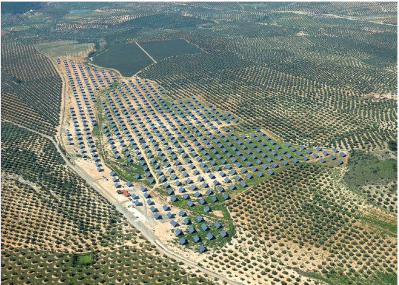
■ PV solar farm in Alcaudete, Jaen / 5,4 MW
