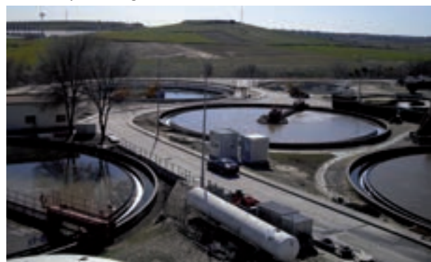
WWTS Arroyo de la Vega, Madrid
