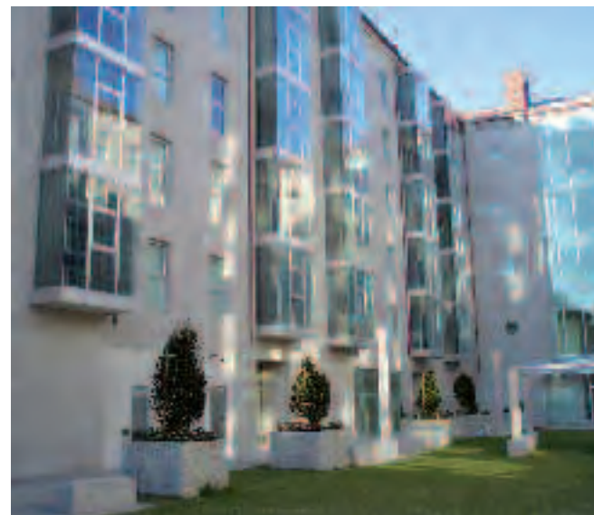
Calle Galera Residences in Santiago de Compostela, La Coruña.
