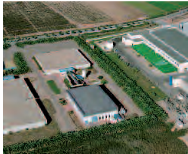
El Mojón Desalinization Plant, Murcia.
