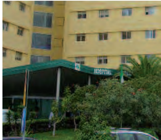
Torreardenas Hospital, Almeria.
