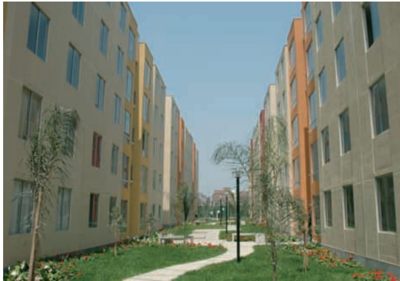
Del Aire Condominium, Lima.
