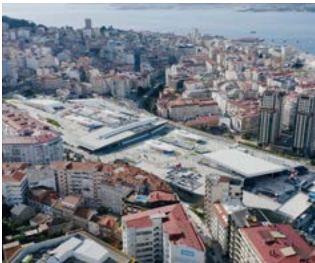
Centre commercial Vialia Estación à Vigo (Espagne)
