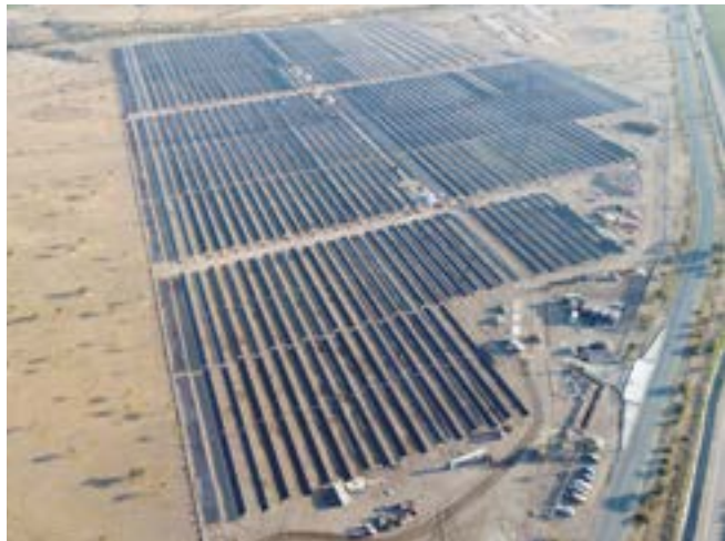
Centrale photovoltaïque de Los Nogales, Région d'Ovalle (Chili). 9,9 MW
