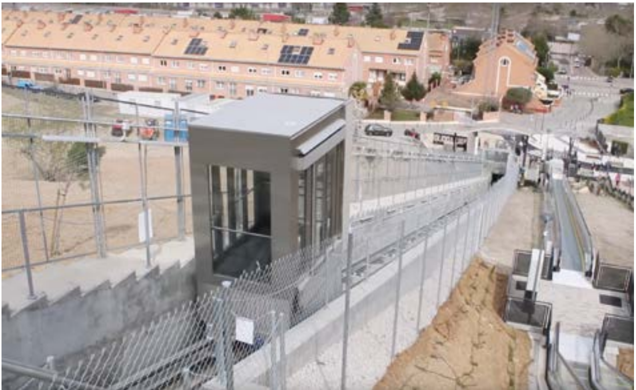
Mobilité verticale et ascenseurs mécaniques sur le versant nord du quartier Parquesol, Valladolid (Espagne)
