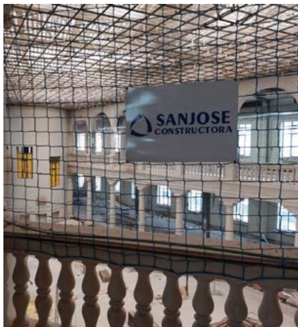
Edifício Administrativo Plaza Madrid 5, Valladolid (Espanha)
