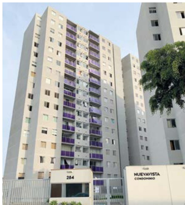
Condomínio Nuevavista no bairro da Bellavista na província de Callao - 1.104 fogos -, Lima (Peru)
