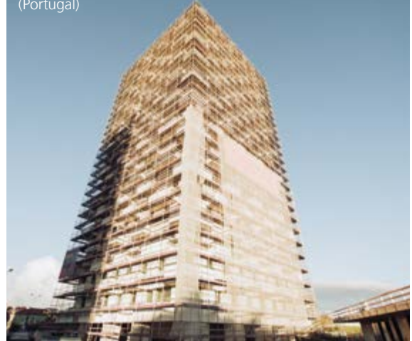
Edifício de habitação The Flower Tower em Leça da Palmeira (Portugal)
