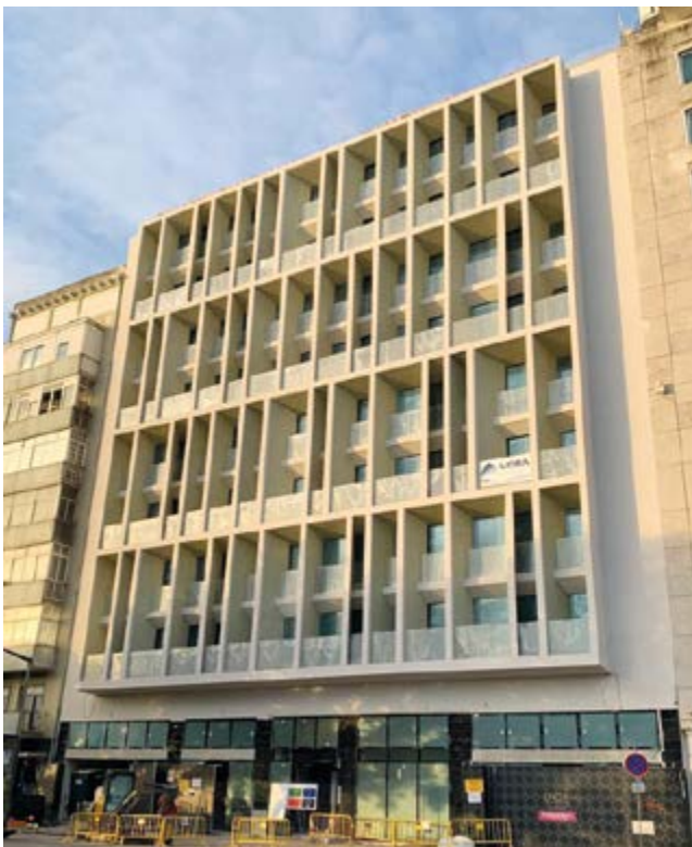
Edifício de habitação Linea Residences, Lisboa (Portugal)
