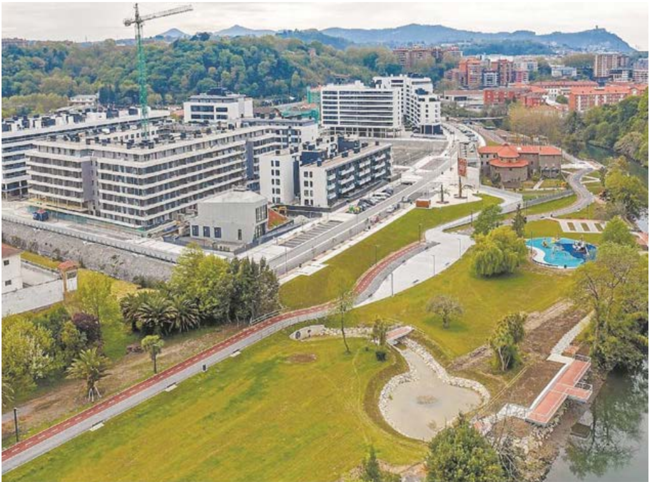
Sistema de District Heating do Eco Bairro Txomin Enea em Donostia - San Sebastian (Espanha)
