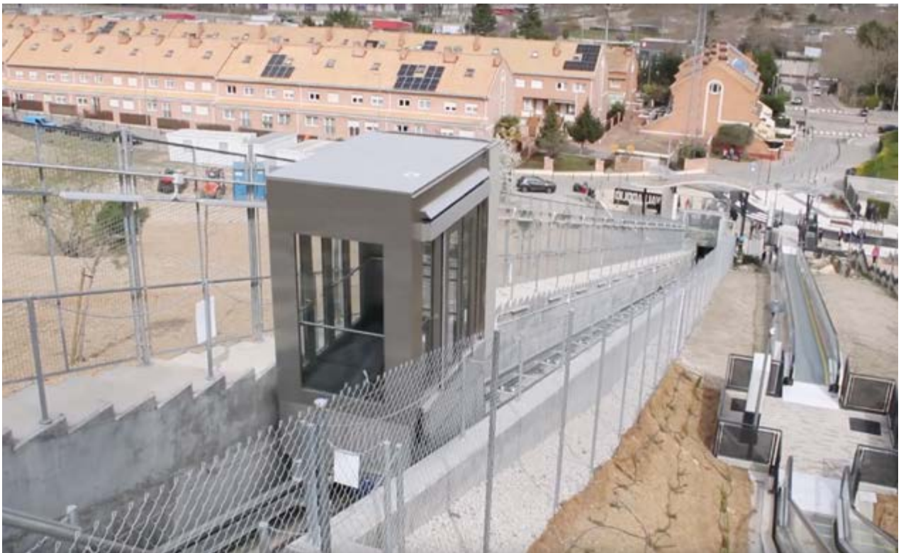
Mobilidade vertical e elevadores mecânicos na encosta norte do bairro de Parquesol, Valladolid (Espanha)
