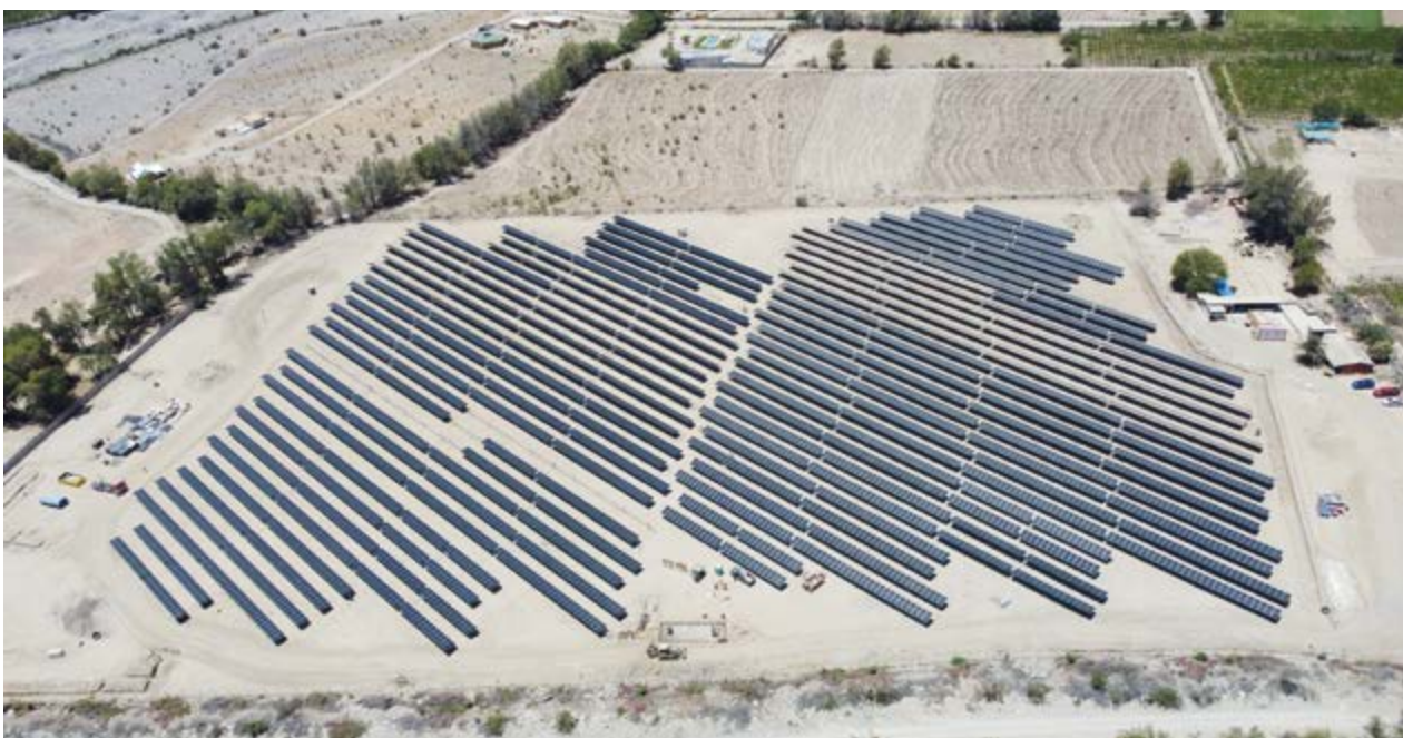
Parque fotovoltaico de Olivier, Região de Coquimbo (Chile). 3 MW
