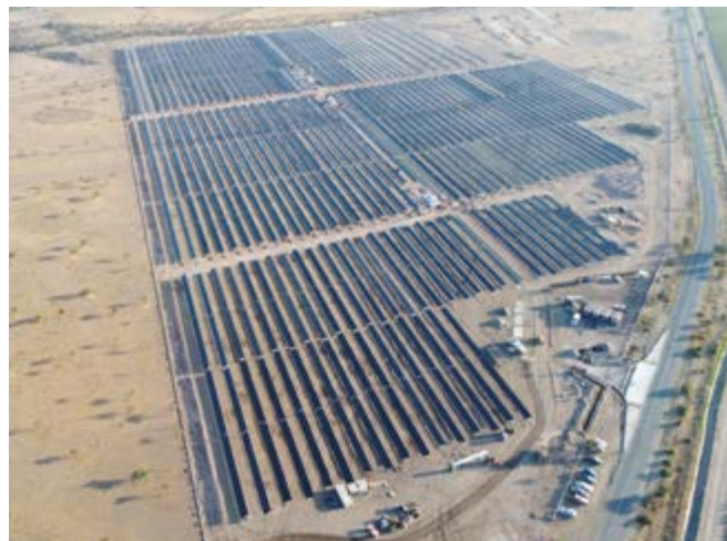
Parque fotovoltaico de Los Nogales, Região de Ovalle (Chile). 9,9 MW
