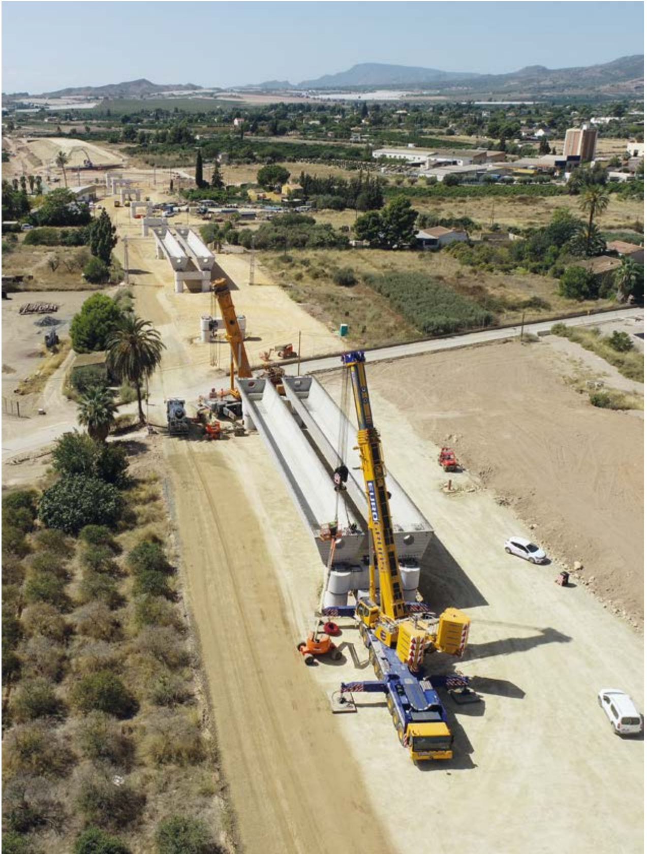
Troço Sangonera - Totana do Corredor Mediterrâneo de Alta Velocidade Múrcia - Almería (Espanha)
