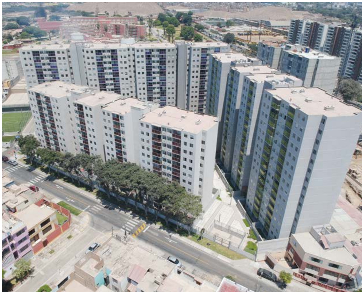
Condomínio Nuevavista no bairro da Bellavista na Província de Callao - 1.104 fogos-, Lima (Peru)
