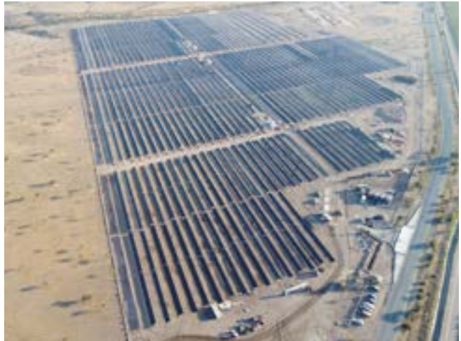
Planta fotovoltaica Los Nogales, Región de Ovale (Chile). 9,9 MW.
