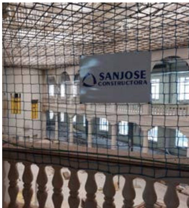
Edificio Administrativo Plaza Madrid 5, Valladolid (España)
