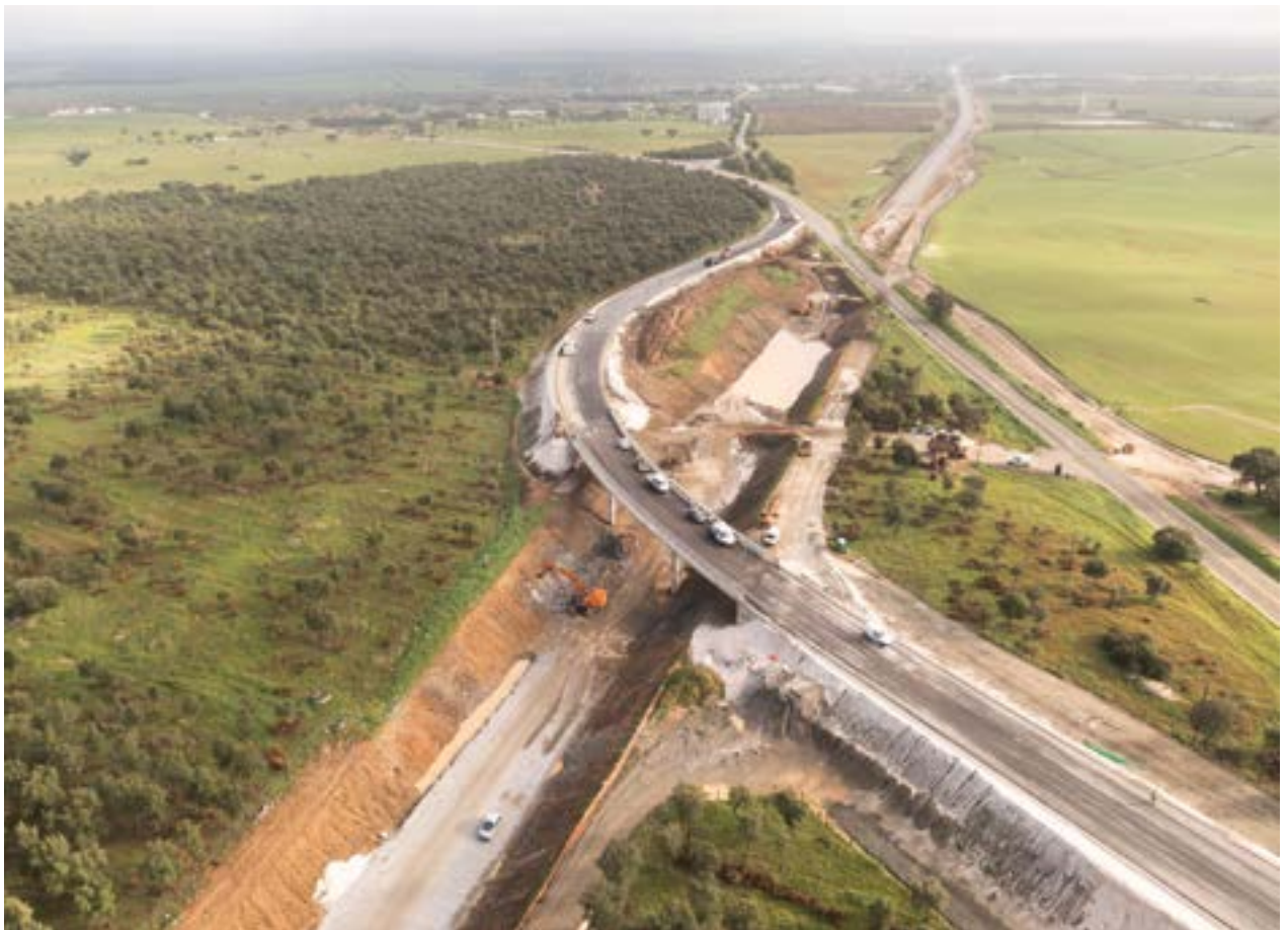
Tramo Évora Norte - Freixo del Corredor Internacional del Sur (Portugal)
