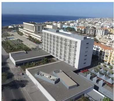
SEDE DEL BANCO CENTRAL DE CABO VERDE EN PRAIA, ISLA DE SANTIAGO (CABO VERDE)
