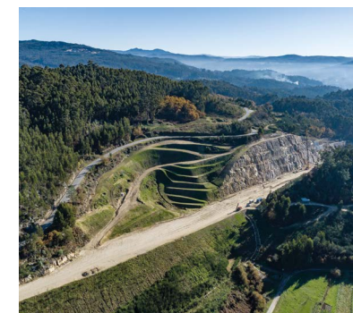
TRAMO VILABOA - A ERMIDA, DE LA FUTURAA-57, PONTEVEDRA (ESPAÑA)
