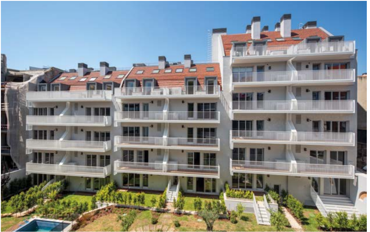
Edificios residenciales Duque Loulé 70, Lisboa (Portugal)
