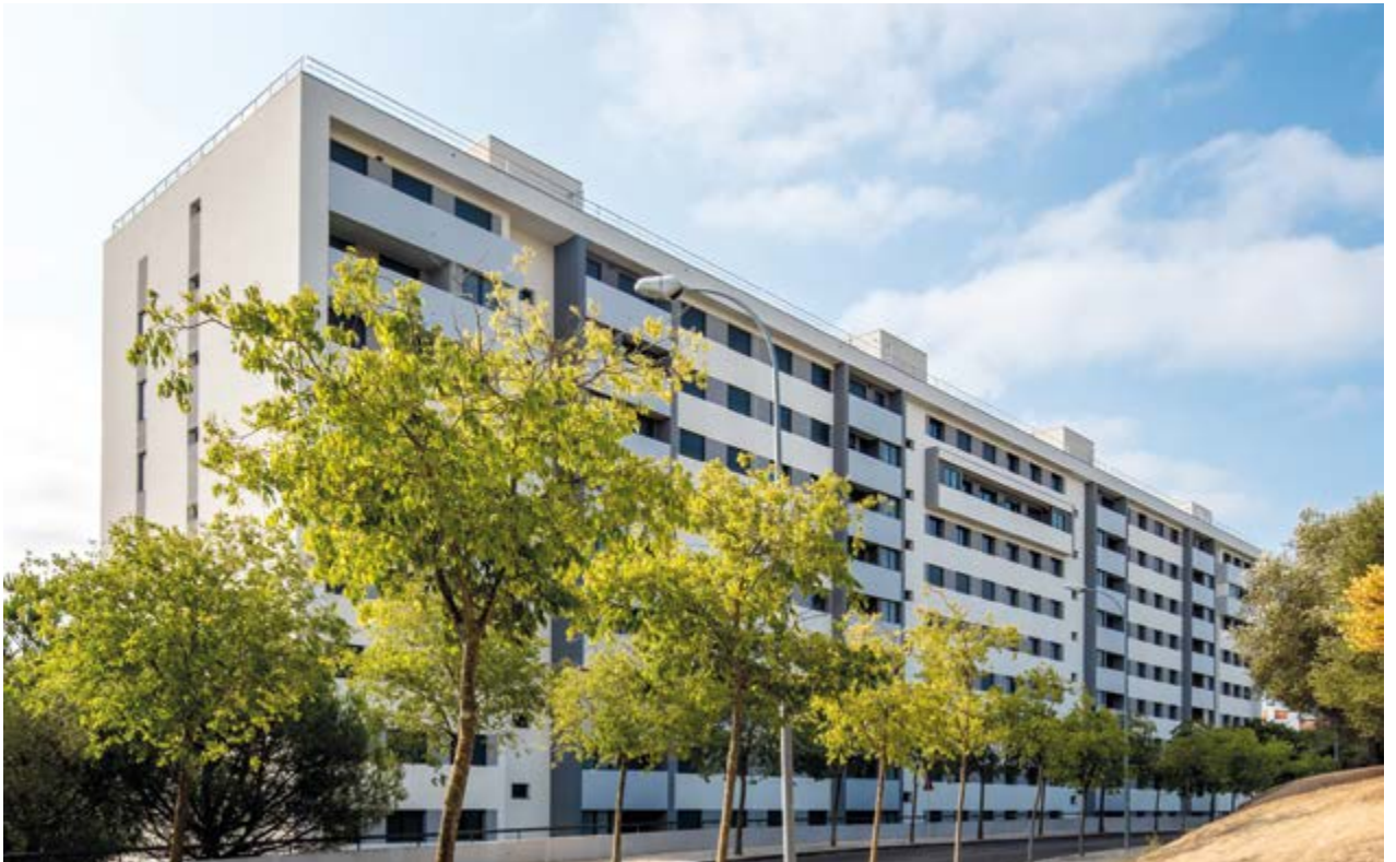
Edificios residenciales en Almarjão, Miraflores (Portugal)
