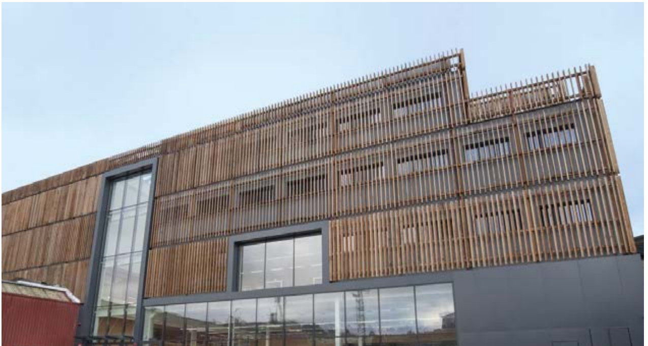
Edificio Beta 2 (Fase II y Fase III) en Zorrotzaurre, Bilbao (España)
