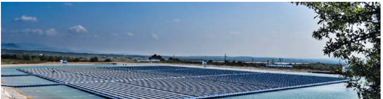
Bombeo solar flotante sobre balsa y dos bombas subterráneas para el autoconsumo de la Comunidad de Regantes de Llíria, Valencia (España)
