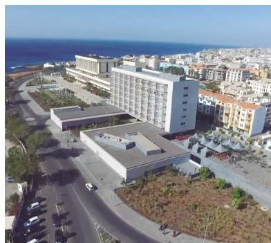
SEDE DEL BANCO CENTRAL DE CABO VERDE
