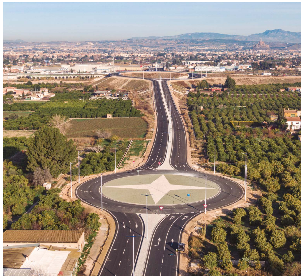
Tramo Autovía del Reguerón de la Circunvalación MU-30 de Murcia (España)
