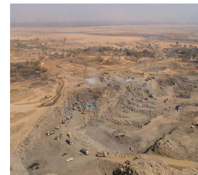
TRAMO 4 DEL MOVIMIENTO DE TIERRAS Y ESTABILIZACIÓN DE SUELOS DEL NUEVO AEROPUERTO NAVI MUMBAI
