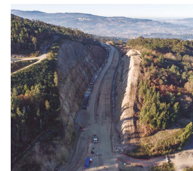
TRAMO VILABOA - A ERMIDA DE LA FUTURA AUTOVÍA A-57, PONTEVEDRA (ESPAÑA)
