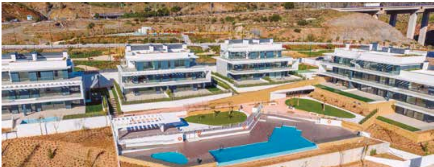
Edifício de habitação La Escala de Valdebebas, Madrid (Espanha)
