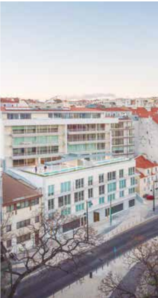
Edifício de habitação Santos Design, Lisboa (Portugal)
