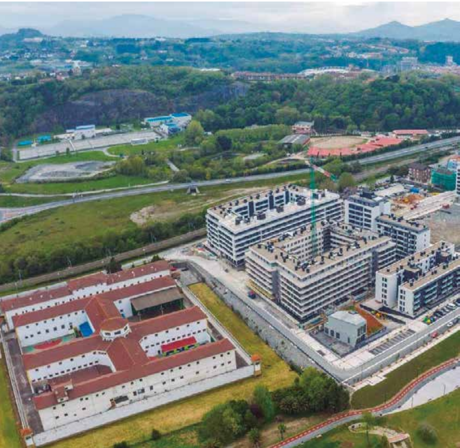
Exploração, operação e venda de energia no Sistema de District Heating do Bairro Txomin Enea de San Sebastian (Espanha)
