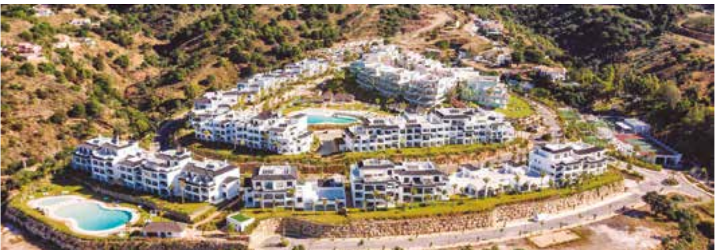
Edifício de habitação Mirador de Estepona Hills, Málaga (Espanha)
