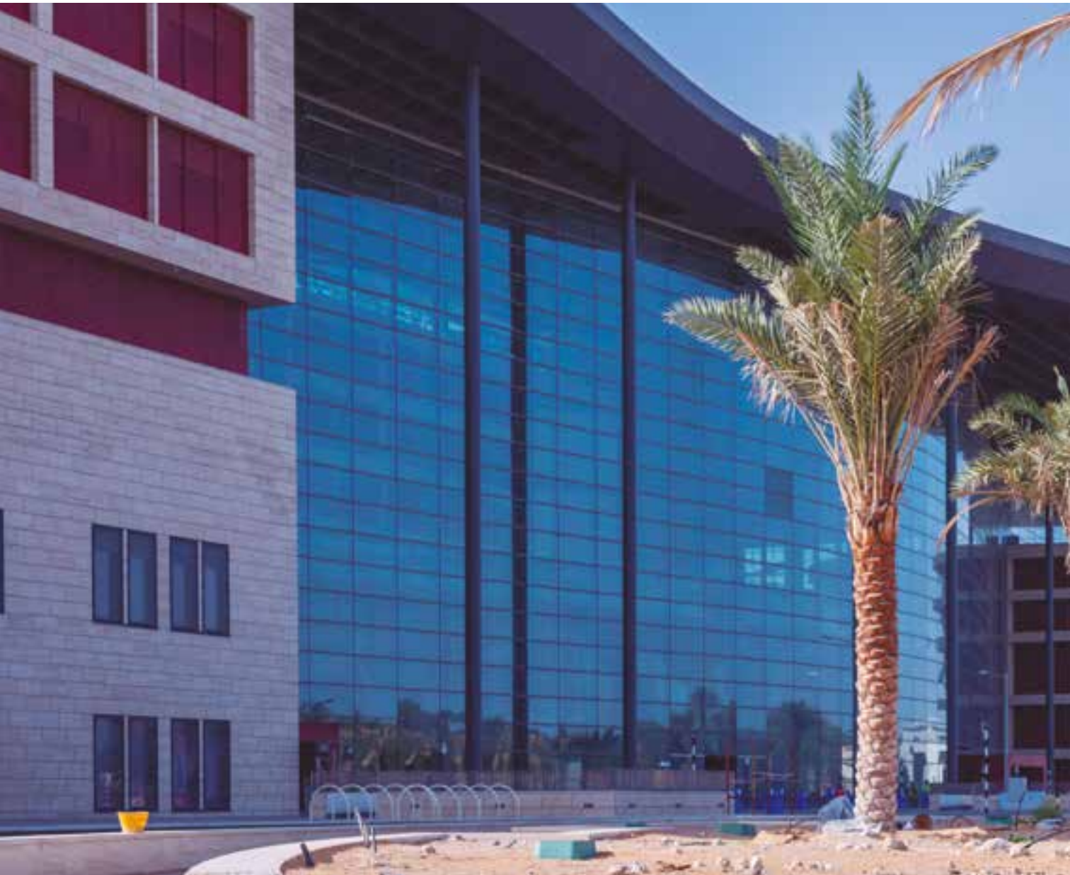
Hospital de Al Ain, Abu Dhabi (Emirados Árabes Unidos)
