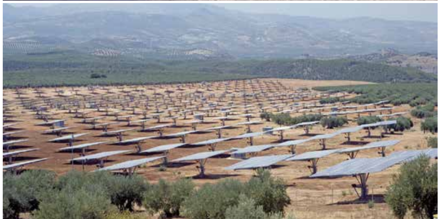
Parque Fotovoltaico de Alcaudete, Jaén / 5,4 MW (Espanha)
