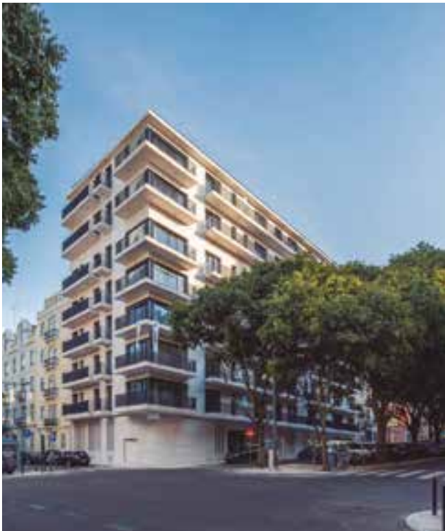
Edifício de habitação Luis Bivar 26-30, Lisboa (Portugal)
