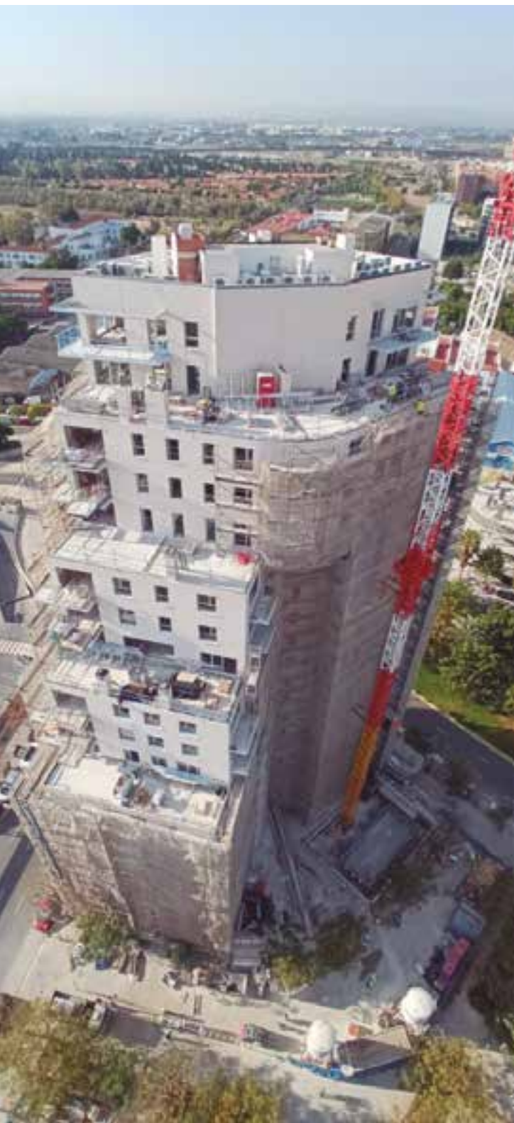
Edifício de habitação Torre Patraix em Valencia (Espanha)
