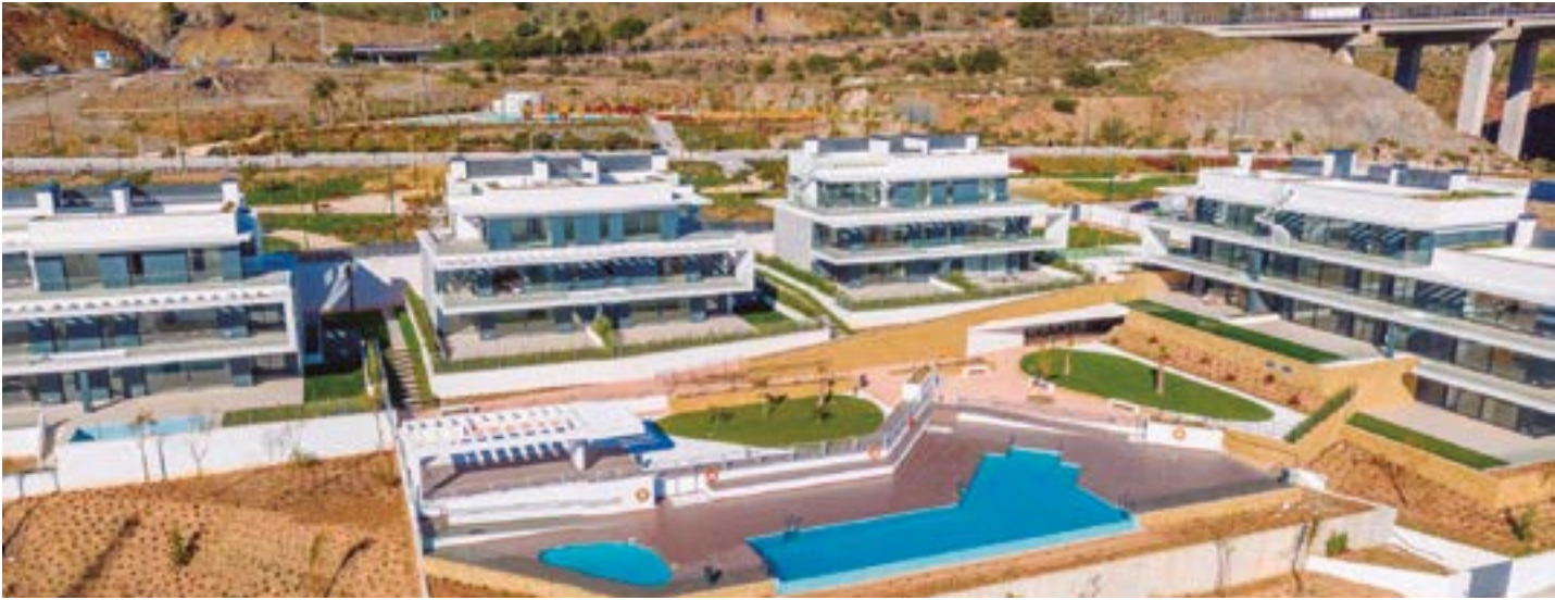
Edificio La Escala de Valdebebas Residential Complex, Madrid (Spain)
