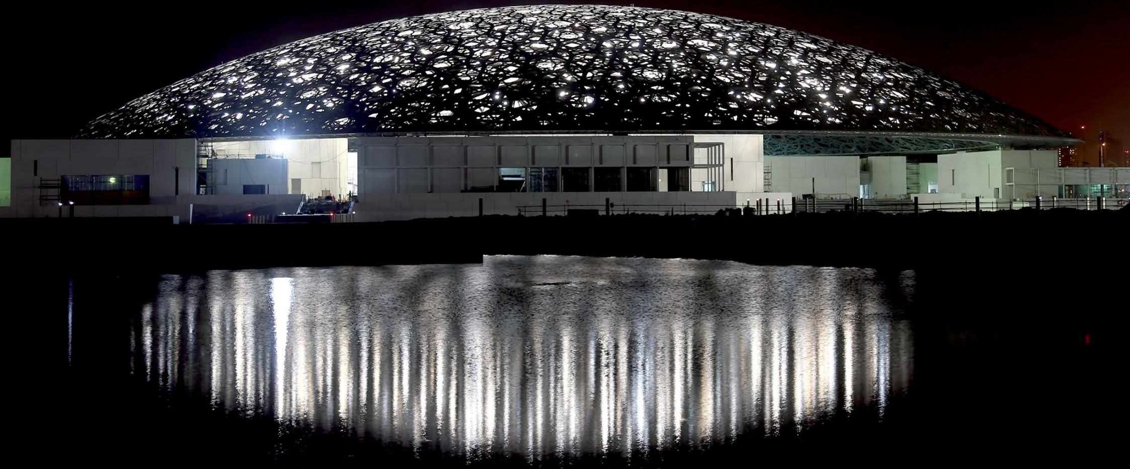
MUSEO LOUVRE ABU DHABI (EMIRATOS ÁRABES UNIDOS) EN EL PRIMER ENCENDIDO DE LAS 4.500 LUCES DE TUBO DE ACERO DE LA ESTRUCTURA DE LA CÚPULA
