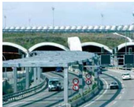
TÚNELES AEROPUERTO DE BARAJAS, MADRID
