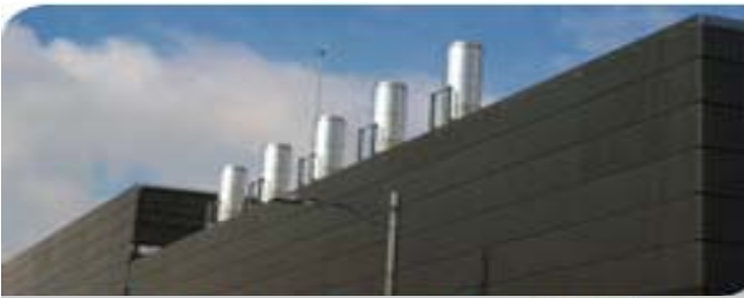
Central Energética Aeropuerto, Barcelona.
